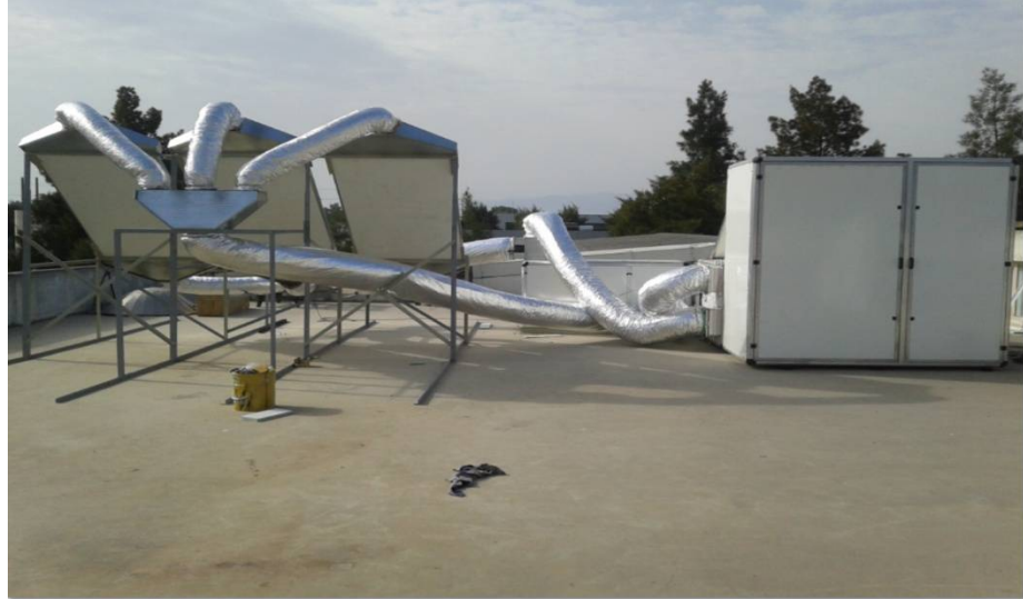
Şekil 4.2b Güneş enerjisi destekli enerji depolama sistemli zirai ürün kurutma sistemi montaj resmi (arkadan görünüş)
