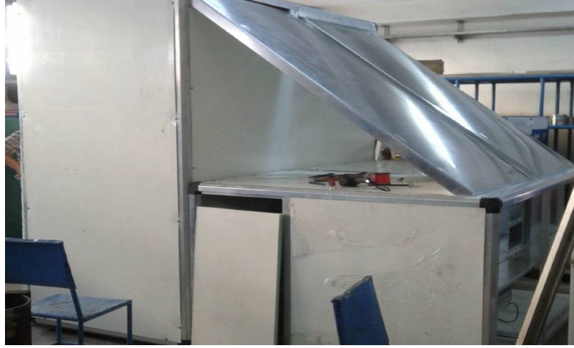
Şekil 4.6a Kurutma kabini montaj resmi (yapım aşaması)
