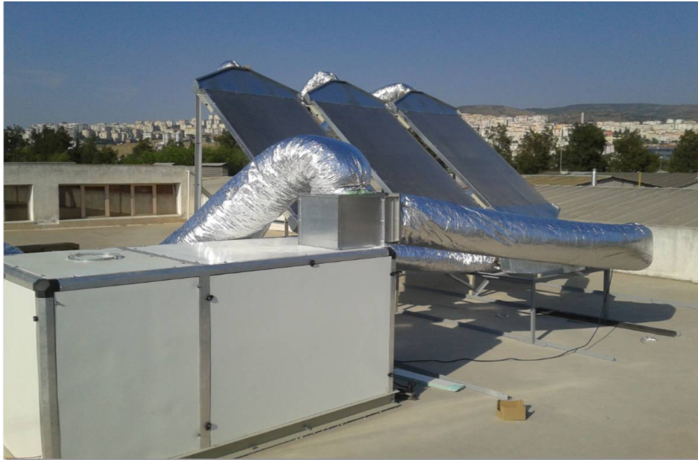
Şekil 4.19 Çakıl taşı enerji depolama sistemi montaj resmi
