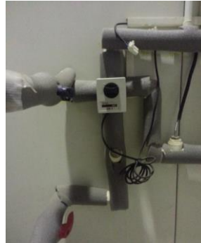
Şekil 3.23 Tank ıkışından sonraki drt yollu vana
