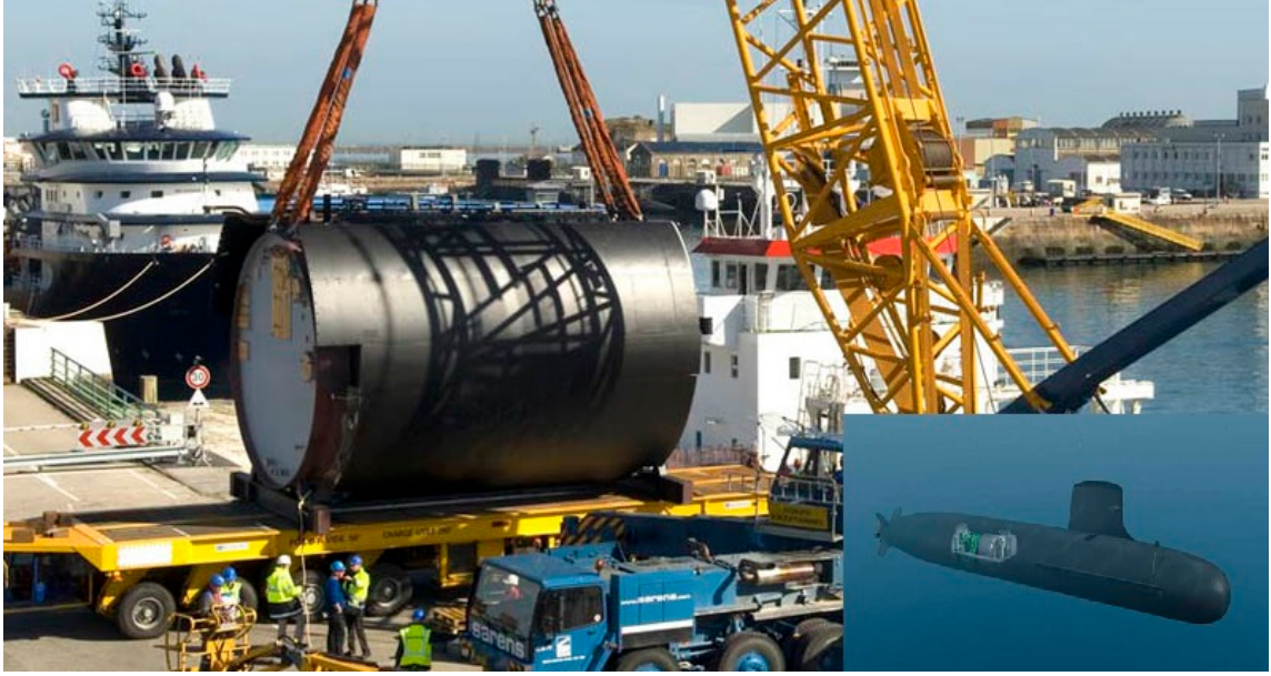
Şekil 4.4 MESMA Sistemi Modülü [286]
