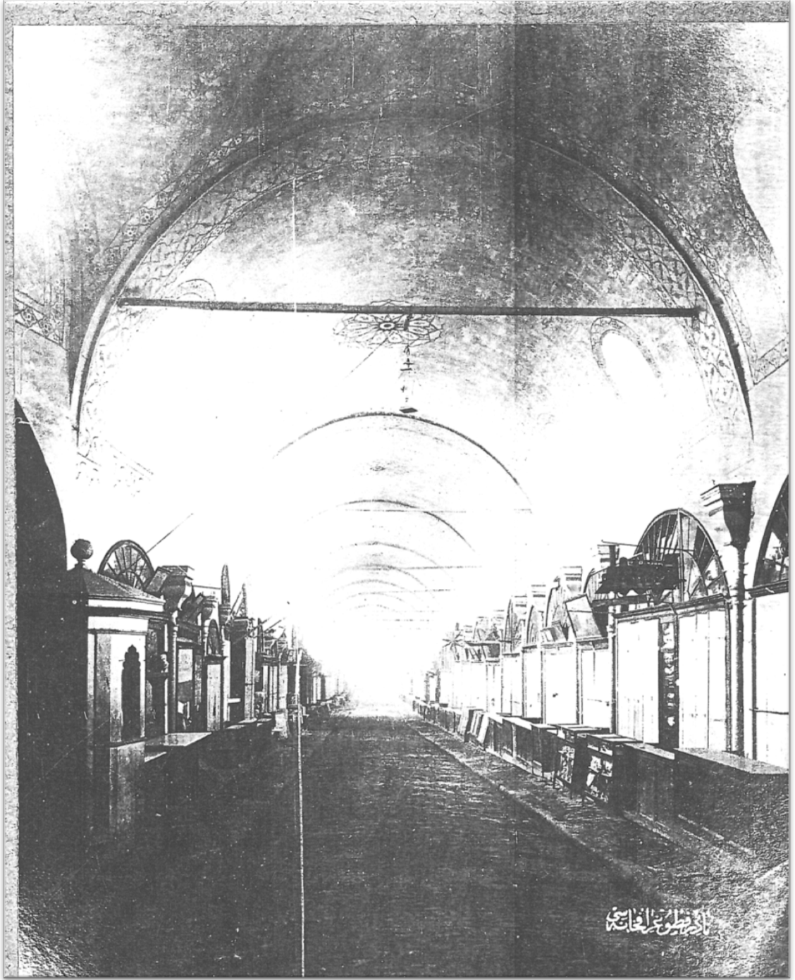
Şekil 5.22 1896 onarımı sonrası Kapalıçarşı-III 66
