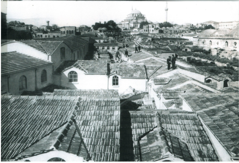
Şekil 5.23 1896 onarımı sonrası Kapalıçarşı çatısı
