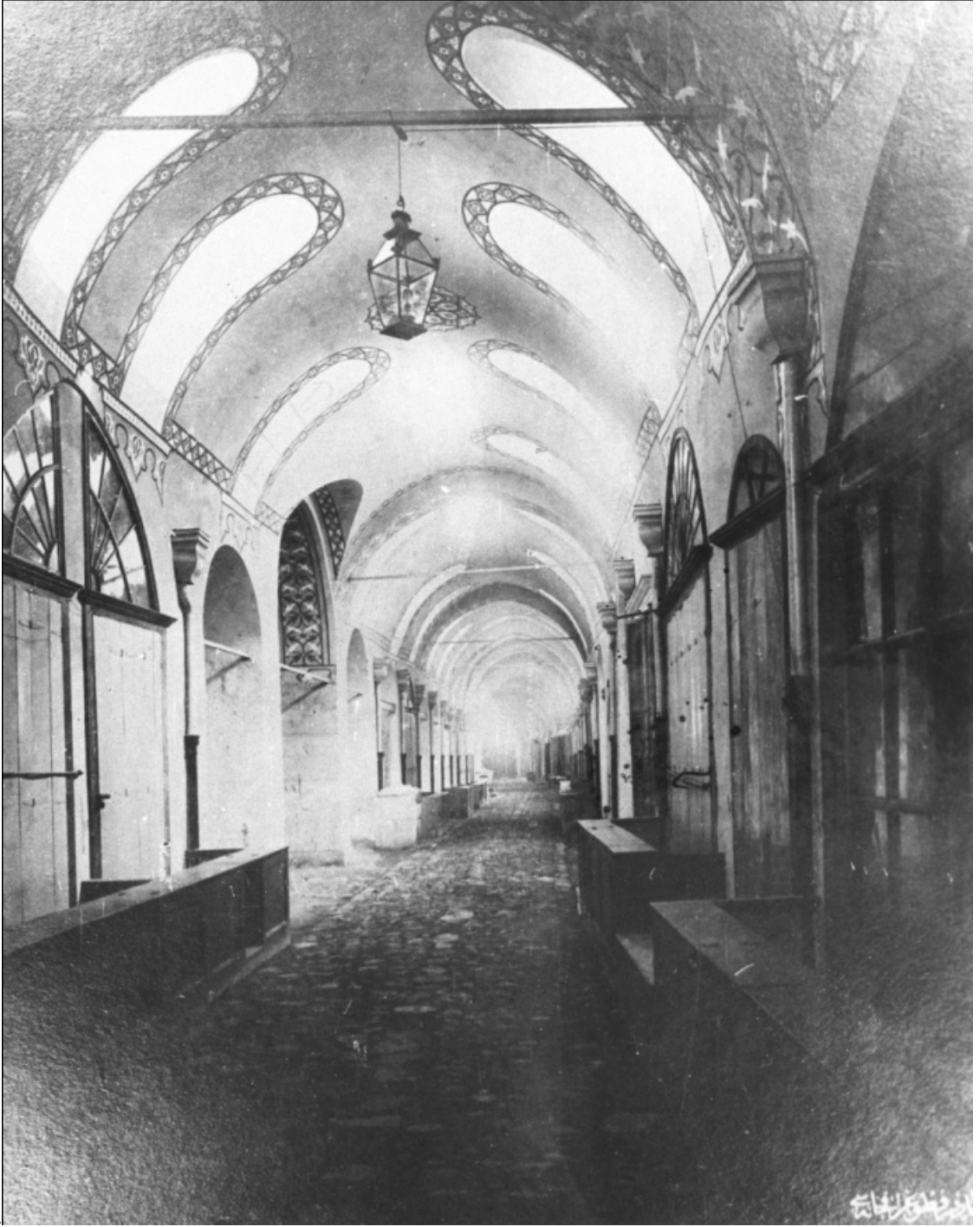
Şekil 5.21 1896 onarımı sonrası Kapalıçarşı-II 65
