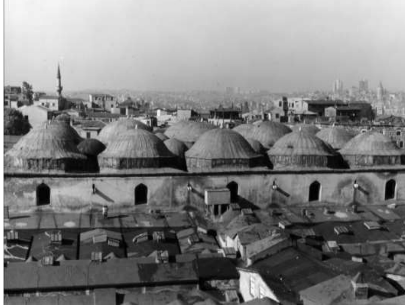
Şekil 5.5 1894 onarımı sonrası Cevahir Bedesteni 44
