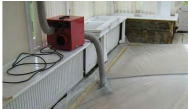
Şekil 3.41 Döşemenin kurutulması için hava verilmesi (English Heritage, 2015)
