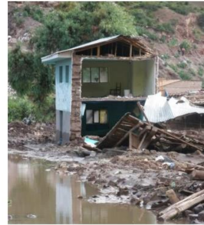
Şekil 4.15 Sel etkisiyle yıkılmış kerpiç yapılar (San Bartolomé vd., 2013)
