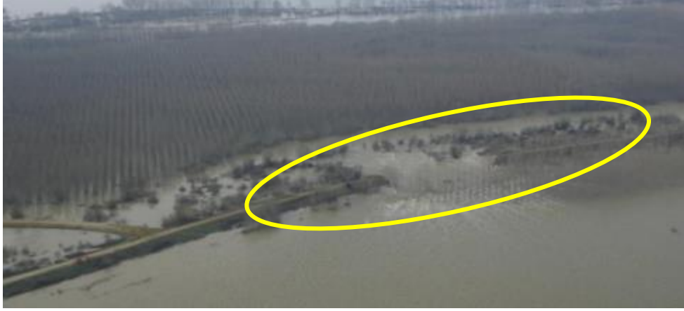
Şekil 5.12 2006 selinde İpsala kış seddesinin patlaması (Türkmenoğlu, 2012)
