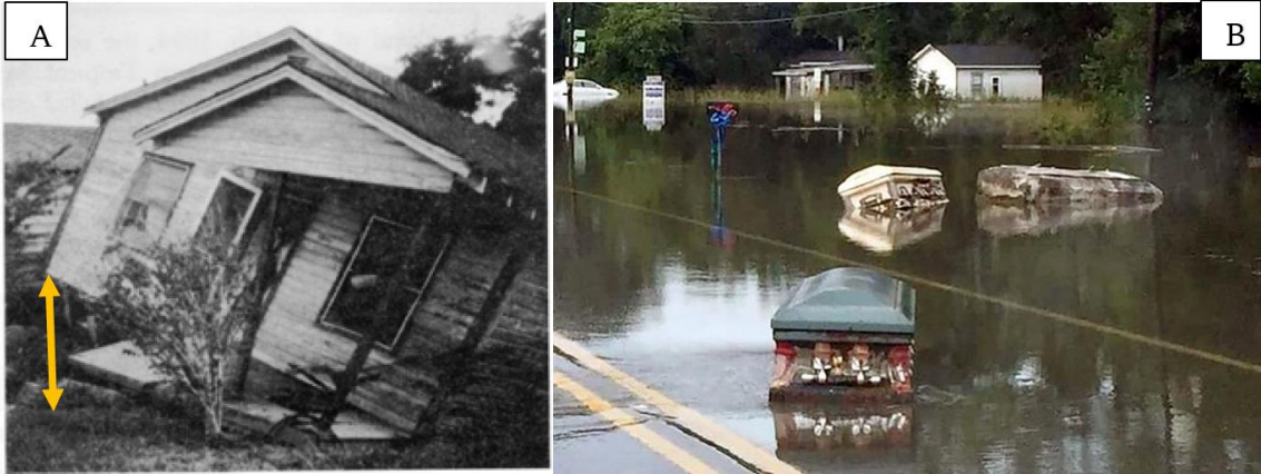
Şekil 3.26 1994 Georgia sel sonrası (Historic Preservation Division, 1997) ve Louisiana ‘da sürüklenen tabutlar (URL69)
