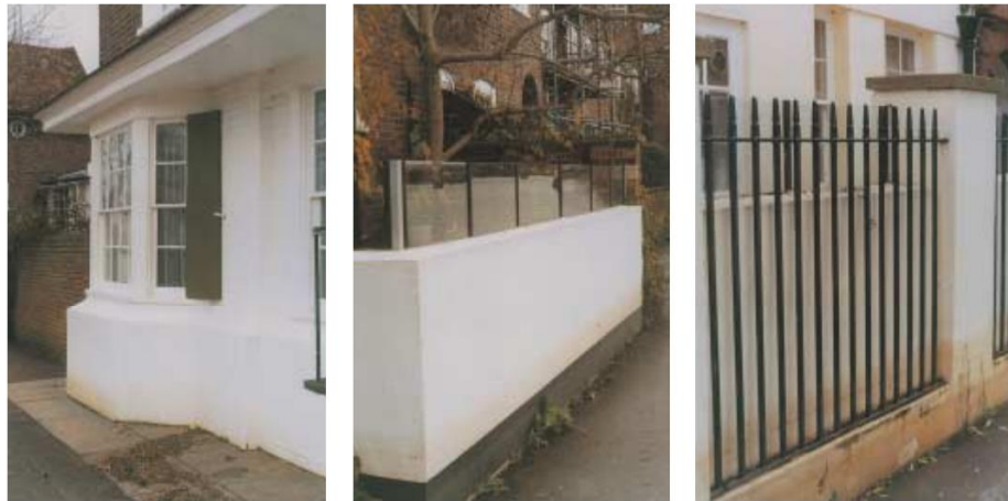
Şekil 3.42 Birleşik Krallık’ta kullanılan kalıcı sel bariyerleri (English Heritage, 2015)
