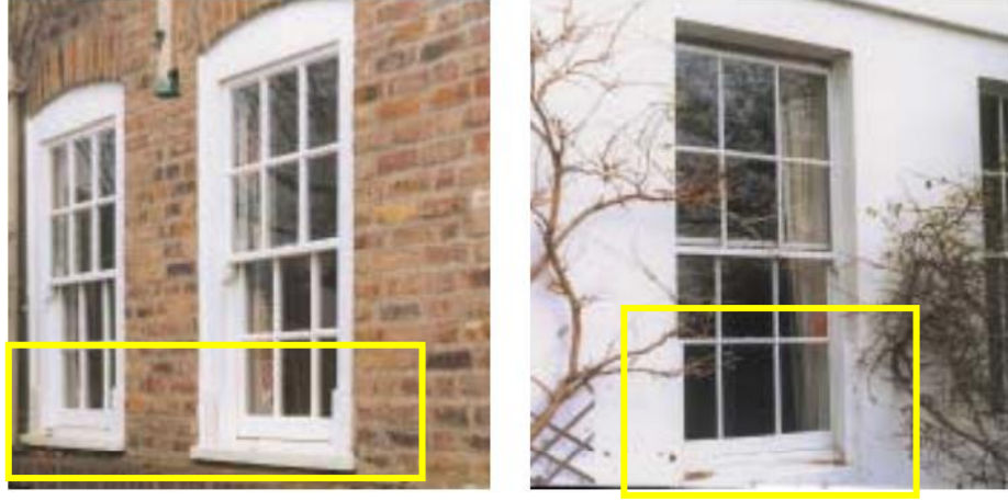
Şekil 3.47 Giyotin pencerelere uygulanmış geçici sel bariyeri kanalları
