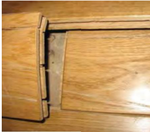
Şekil 3.38 Kuruma süreci bitmeden sabitlenmiş döşemde bükülme (English Heritage, 2015).
