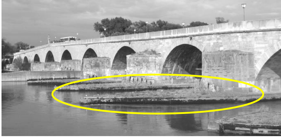
Şekil 3.21 Regensburg'daki Ortaçağ köprüsü koruyucu adalar (Drdácký ve Slížková, 2007).
