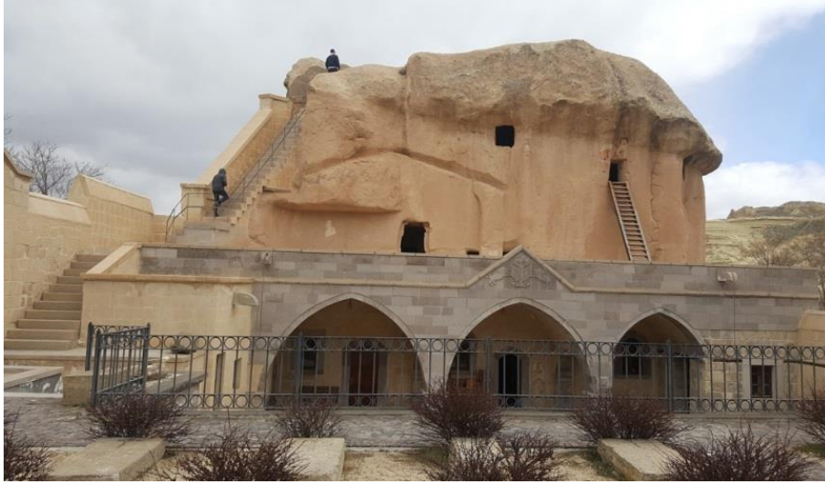
Şekil 4.48 Anadolu'daki yerleşimde bulunan Aziz Nicholaos Manastırı, mübadele öncesinde muhafaza ettiği ikonalar yeni yerleşim'e taşınmıştır. Nea Sinasos'taki merkez kiliseye ismi verilmiştir. Restore edilen yapı günümüzde müze olarak kullanılmaktadır (Ulubay, 2019)
