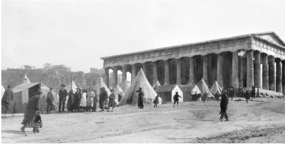
Şekil 2.9 Anadolu Rum göçmenlerin Atina'daki Akropolis bölgesi ve yakın çevresinde kurduğu geçici yerleşimler (Atina, 1922), (Morris, 1925)
