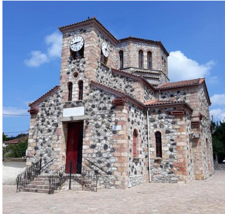
Şekil 4.61 Nea Sinasos’ta yer alan Saint Nicholaos Kilisesi’nin ön cephesi ve giriş kapısı, giriş kapısının üzerinde yazıt yer almakta (Ulubay, 2019)
