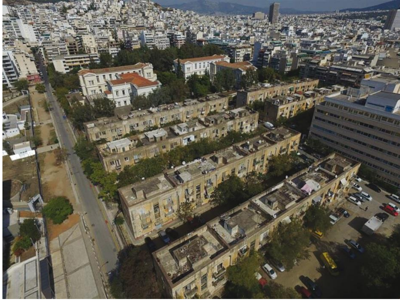
Şekil 2.41 III. Evre – Yerinden edilenler için yapılan kentsel konut bloklarının terk edilmiş ve atıl hali 103 (Atina, 2016), (Λιανός, 2016)
