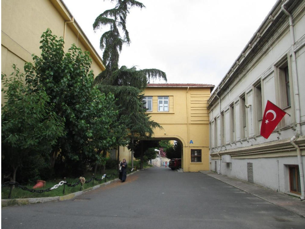
Şekil 4.59 Özgün yapıyı yeni yapıya bağlayan bağlantı bloğu (Saadet Mutlu Kaytan Arşivi, 2017)
