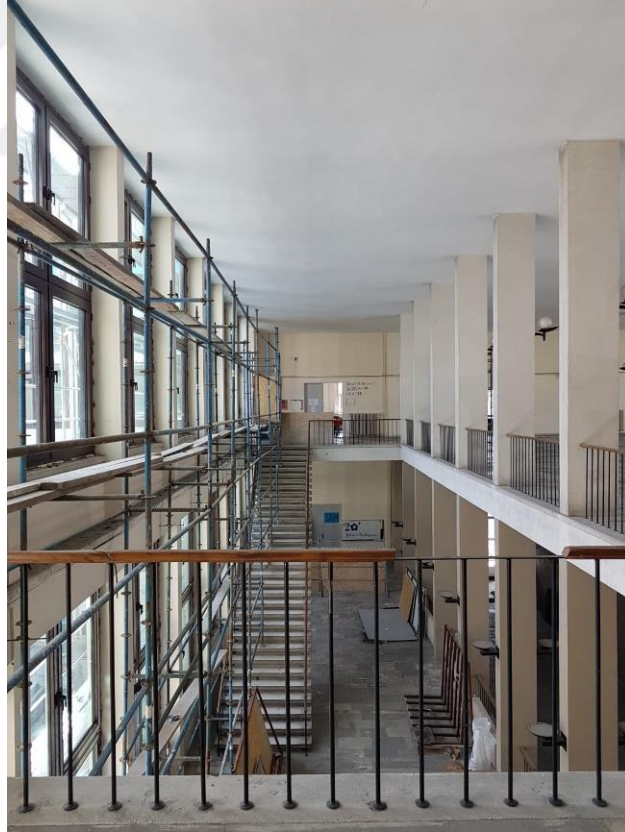
Şekil 4.151 Maça Silahhanesi iç mekan görünümü (Saadet Mutlu Kaytan Arşivi, 2019)
