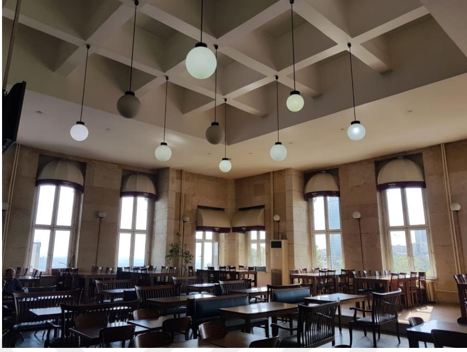
Şekil 4.150 Maça Silahhanesi iç mekan görünümü kaset döşeme (Saadet Mutlu Kaytan Arşivi, 2019)
