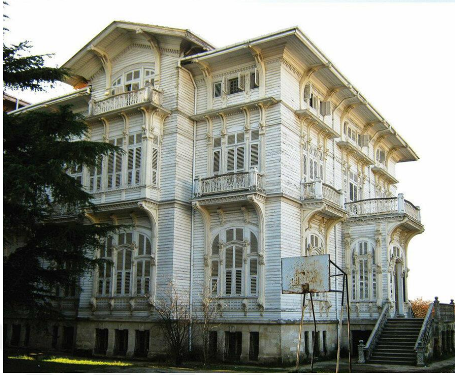
Şekil 4.22 Giriş cephesi, https://www.gzt.com/arkitekt/mimar-kemaleddinden-art-nouveau-tarzinin-essiz-ornegi-camlıca-kız-lisesi-3549821
