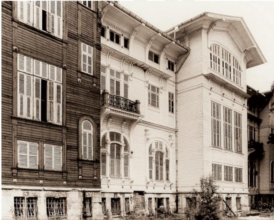
Şekil 4.23 Arka cephe görünümü (Badur, 2018, s. 11)
