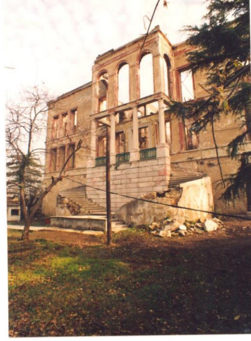
F.1. Saray, Batı cephesi.
