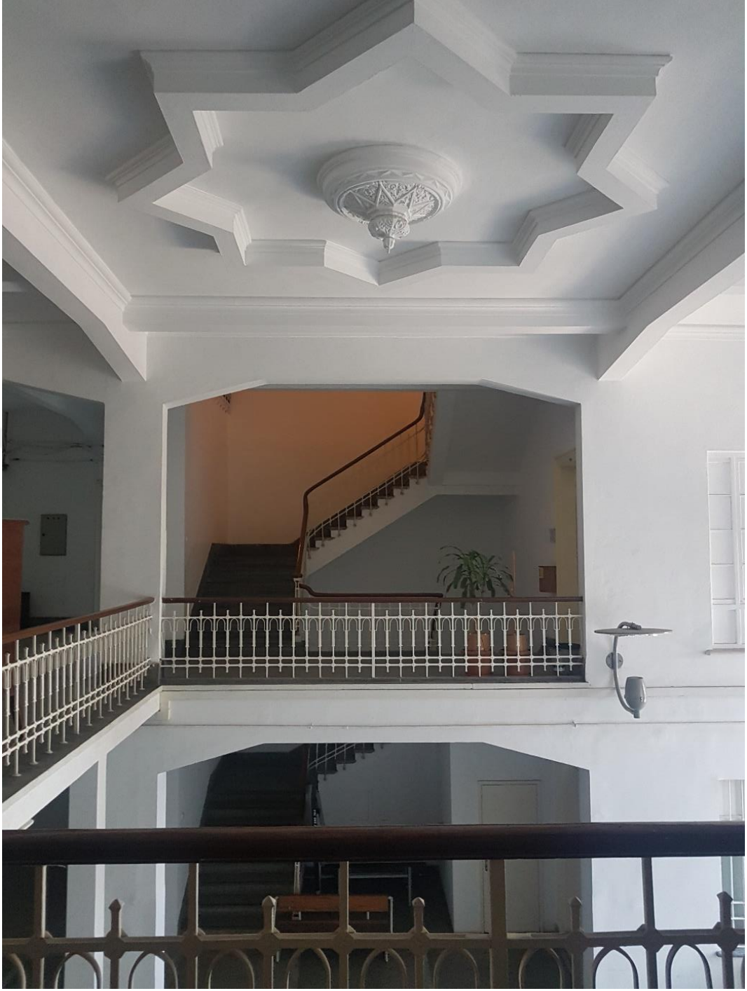
Şekil 4.44 İç mekan görünümü (Saadet Mutlu Kaytan Arşivi, 2021)
