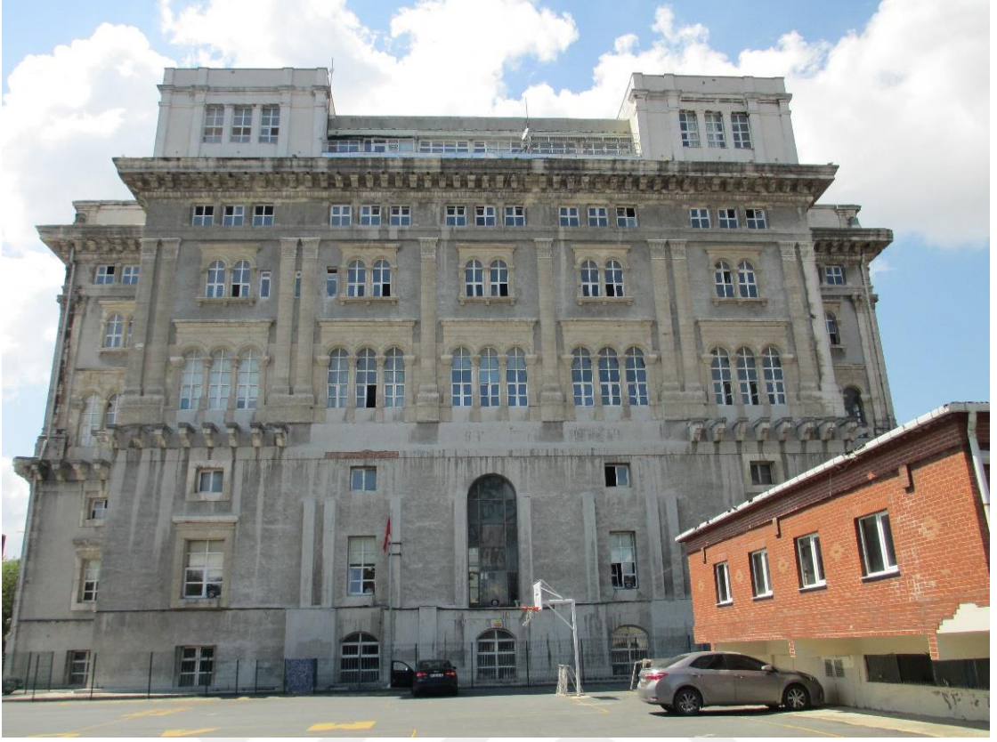
Şekil 4.97 Dış cephe görünümü (Saadet Mutlu Kaytan Arşivi, 2017)
