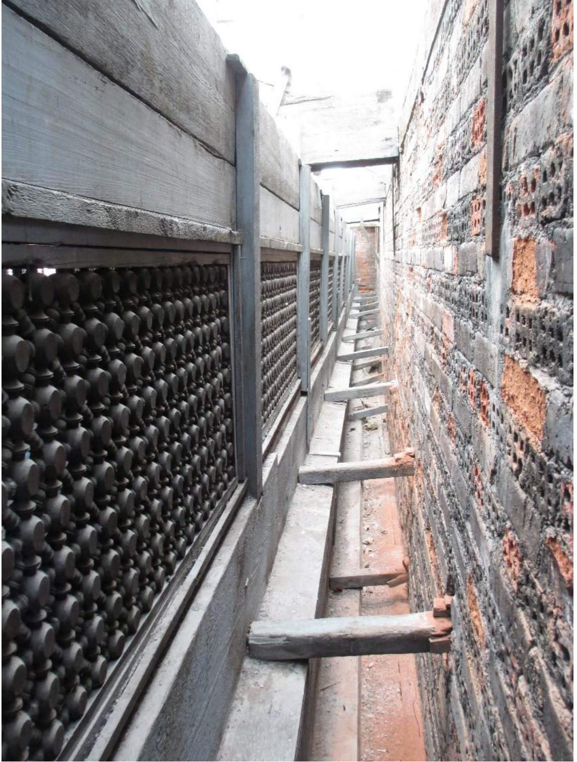
Şekil 4.292 İstanbul Erkek Lisesi, çatı feneri görünümü (Saadet Mutlu Kaytan Arşivi, 2017)
