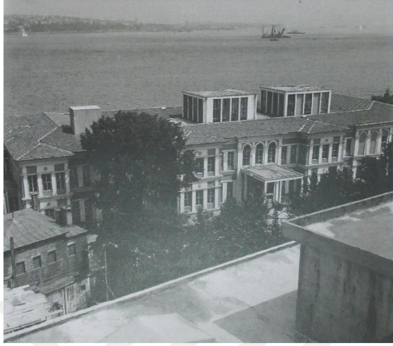
Şekil 4.199 1976 Uygulaması sırasında yapılan çatı fenerleri (Mimar Sinan Güzel Sanatlar Üniversitesi Fındıklı Yerleşkesinde Bulunan Binaların Tarihsel Gelişim Raporu, 2013)
