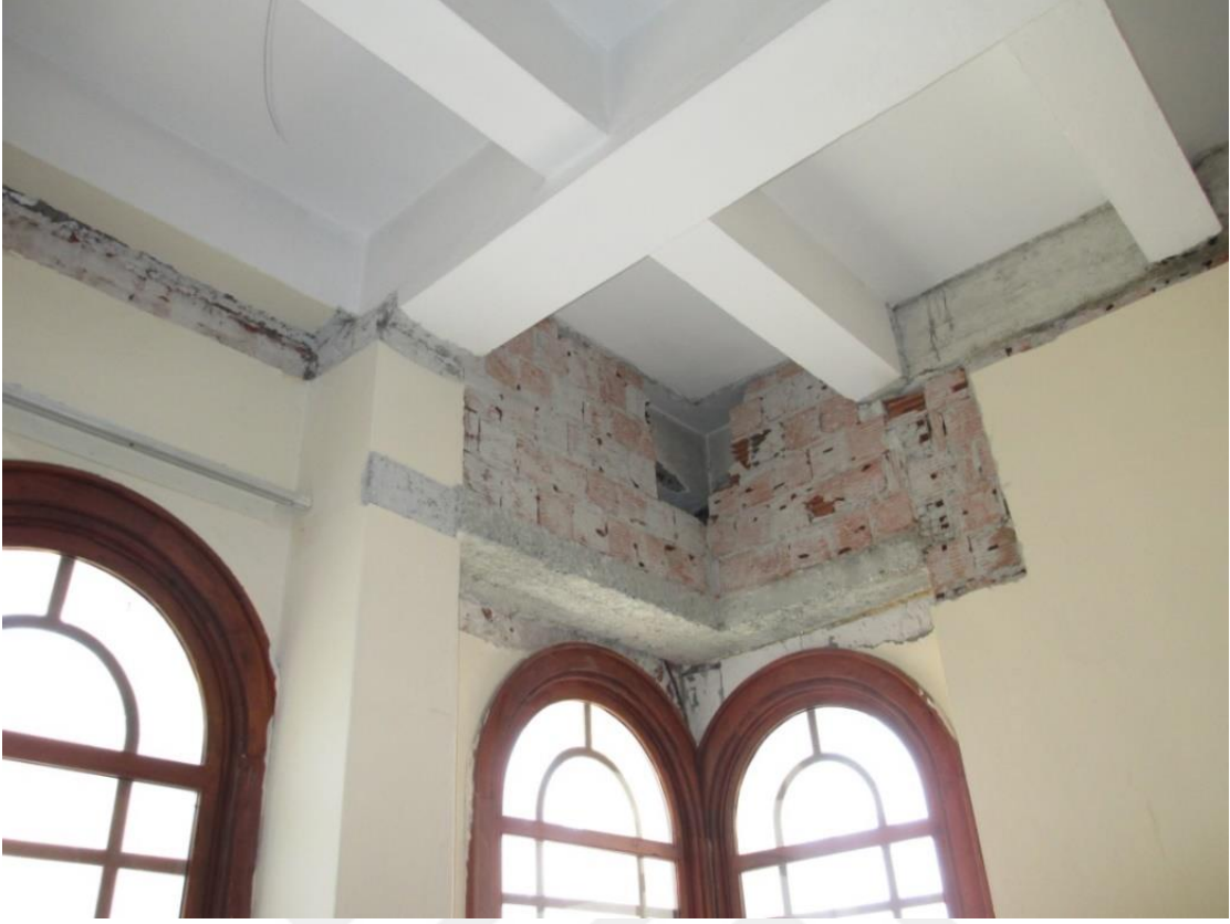
Şekil 4.238 Betonarme destek eklentisi (Saadet Mutlu Kaytan Arşivi, 2017)
