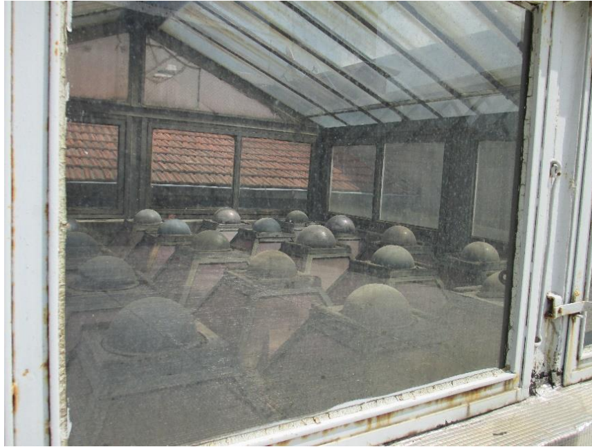
Şekil 4.290 İstanbul Erkek Lisesi çatı feneri görünümü (Saadet Mutlu Kaytan Arşivi, 2017)
