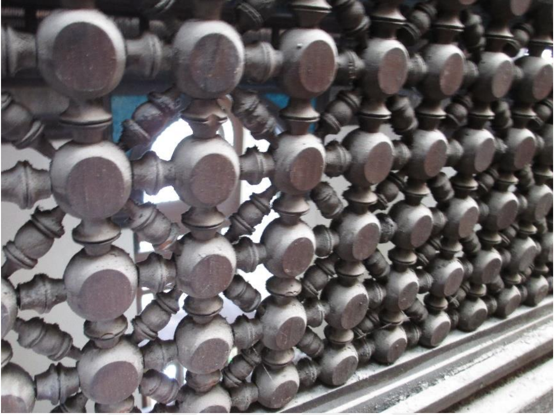
Şekil 4.293 İstanbul Erkek Lisesi, çatı feneri görünümü (Saadet Mutlu Kaytan Arşivi, 2017)
