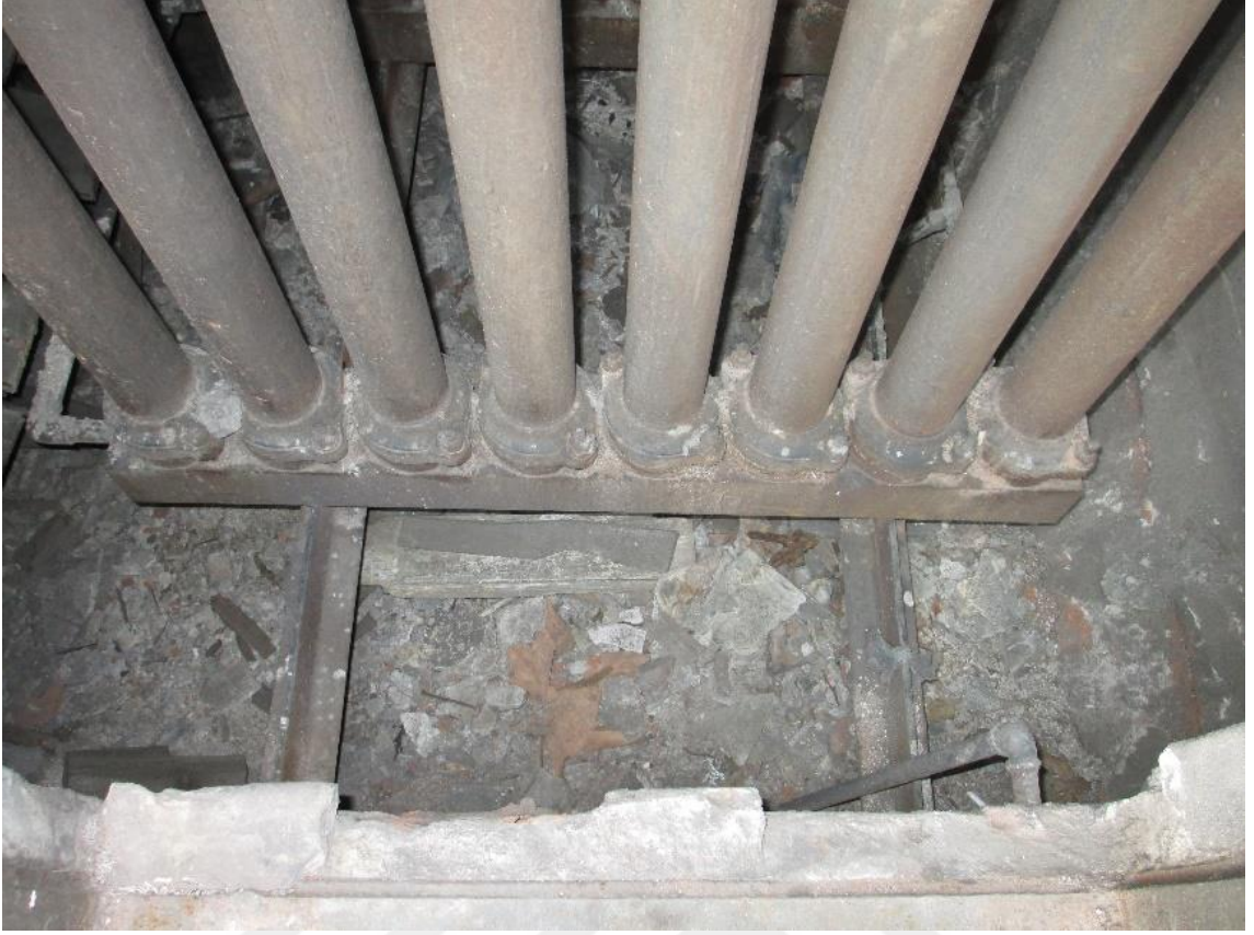
Şekil 4.299 İstanbul Erkek Lisesi baca içindeki mekanizma (Saadet Mutlu Kaytan Arşivi, 2017)
