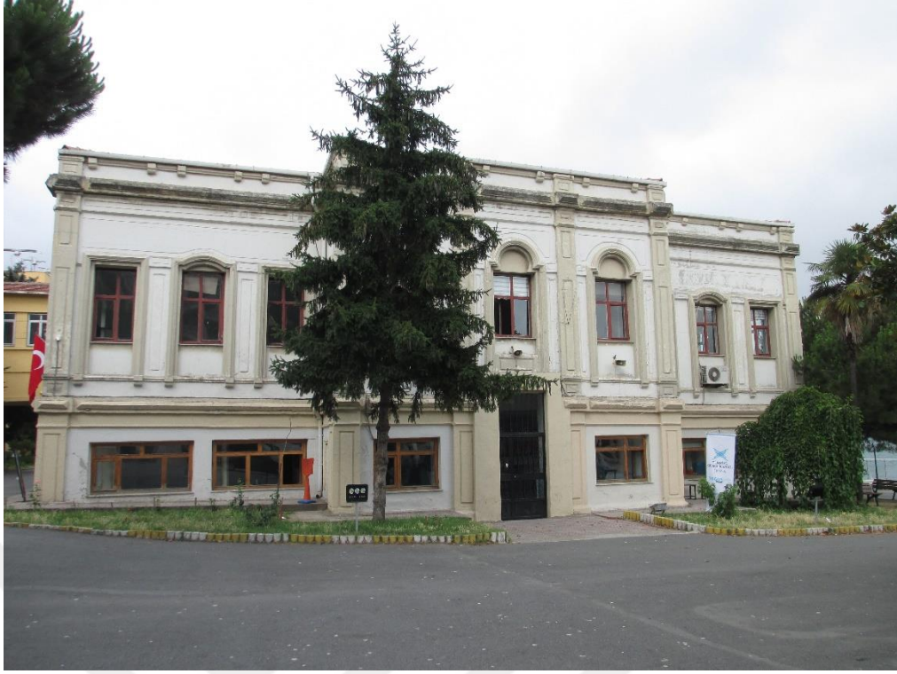
Şekil 4.58 Dış cephe görünümü (Saadet Mutlu Kaytan Arşivi, 2017)
