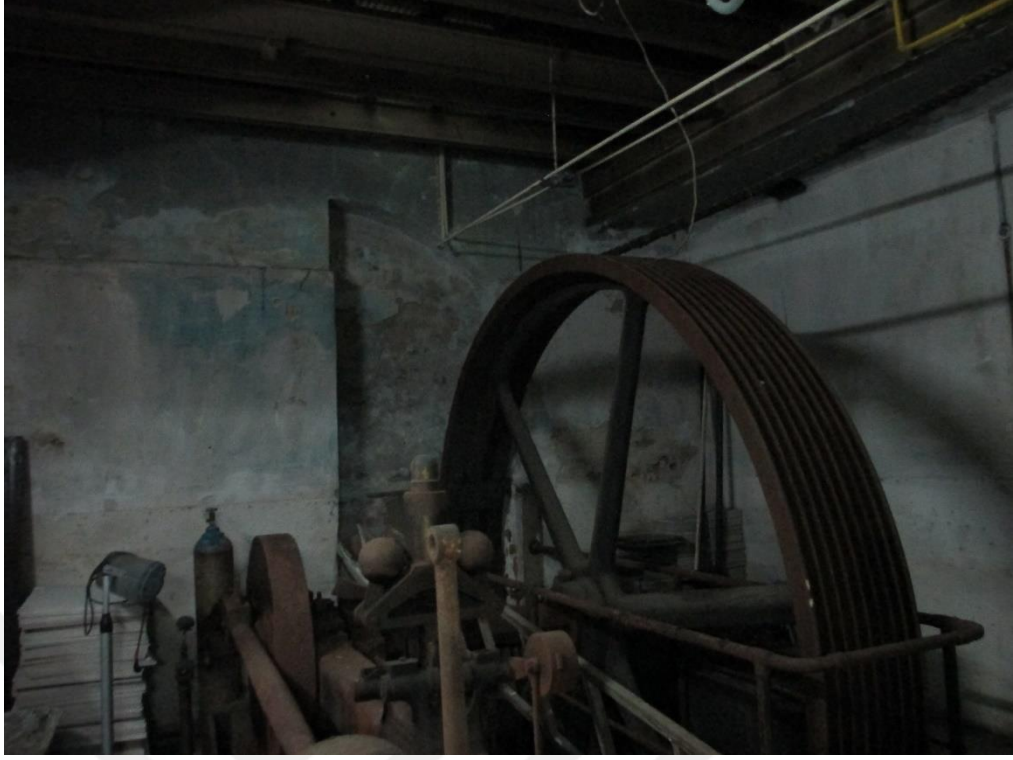
Şekil 4.296 İstanbul Erkek Lisesi bodrum katta yer alan buharlı ısıtma mekanizması (Saadet Mutlu Kaytan Arşivi, 2017)
