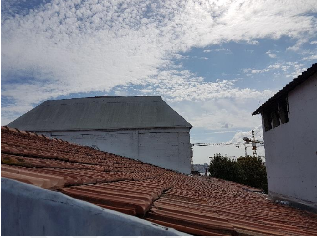
Şekil 4.190 Mimar Sinan Güzel Sanatlar Üniversitesi Mimarlık Fakültesi çatı feneri görünümü (Saadet Mutlu Kaytan Arşivi, 2019)
