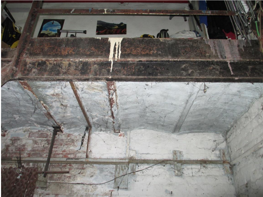
Şekil 4.297 İstanbul Erkek Lisesi bodrum katta yer alan volta döşeme örneği (Saadet Mutlu Kaytan Arşivi, 2017)
