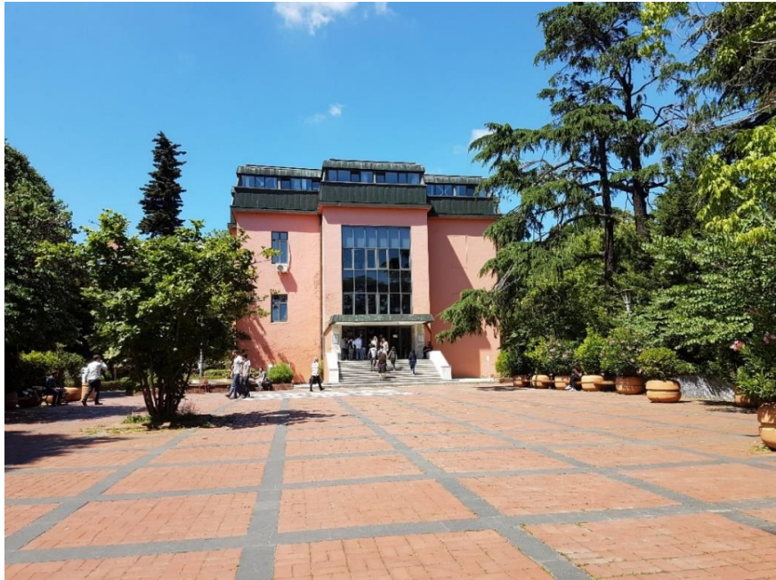
Şekil 4.129 YTÜ Mimarlık Fakültesi ana giriş cephesi (Saadet Mutlu Kaytan Arşivi, 2019)
