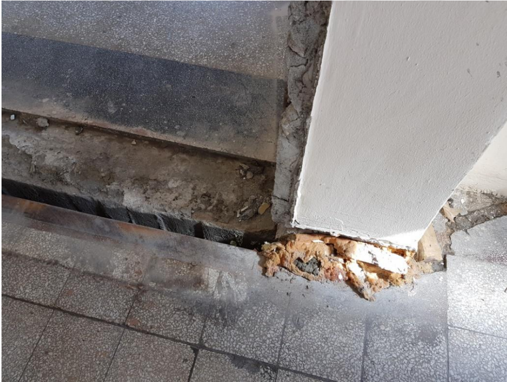
Şekil 4.234 Kabataş Erkek Lisesi dilatasyon görünümü (Saadet Mutlu Kaytan Arşivi, 2017)
