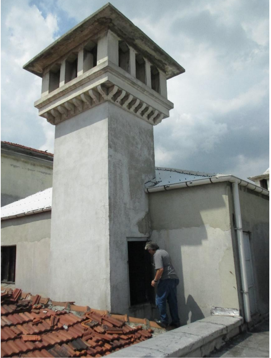
Şekil 4.298 İstanbul Erkek Lisesi baca görünümü (Saadet Mutlu Kaytan Arşivi, 2017)
