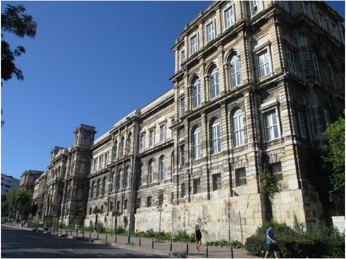
Şekil 4.104 Ön cephe (Saadet Mutlu Kaytan Arşivi, 2017)
