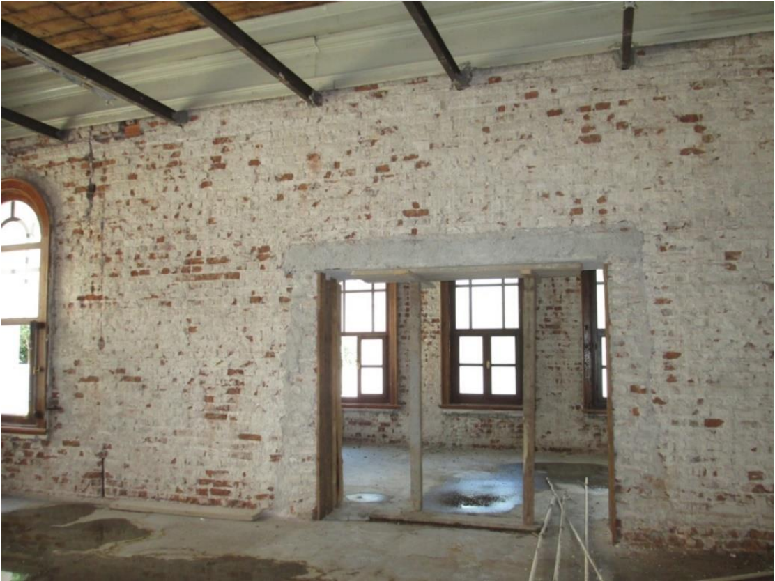
Şekil 4.239 Özgün duvar görünümü (Saadet Mutlu Kaytan Arşivi, 2017)
