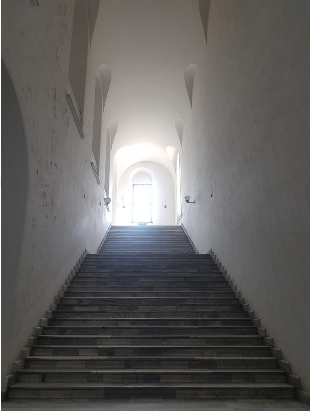
Şekil 4.88 İç mekan görünümü (Saadet Mutlu Kaytan Arşivi, 2021)
