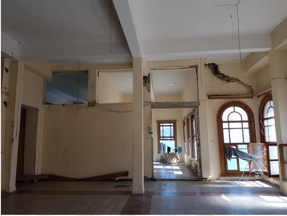
Şekil 4.235 Betonarme taşıyıcı sistem eklentisi (Saadet Mutlu Kaytan Arşivi, 2017)
