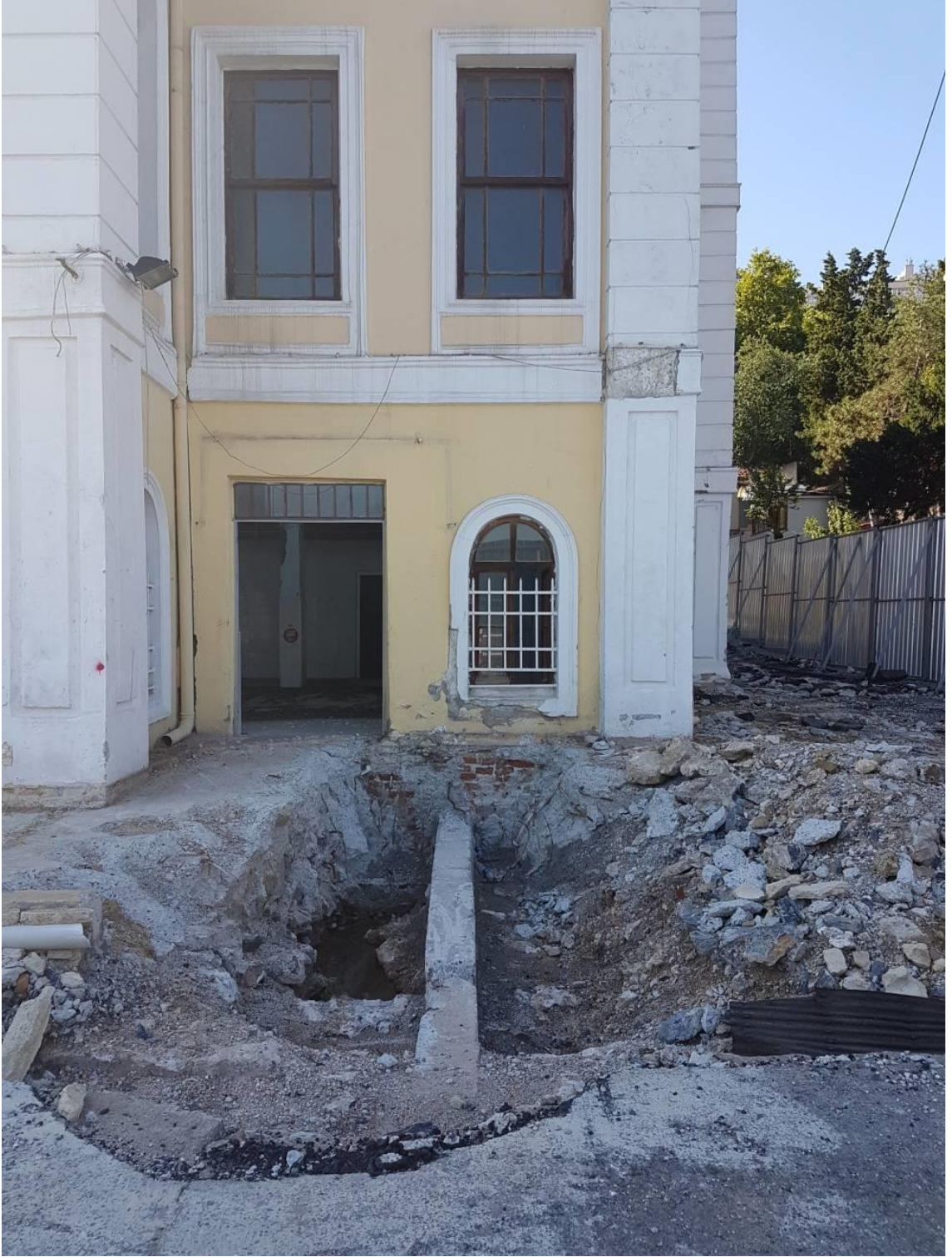
Şekil 4.228 Kabataş Erkek Lisesi sonraki dönem uygulaması temel takviyesi (Saadet Mutlu Kaytan Arşivi, 2017)
