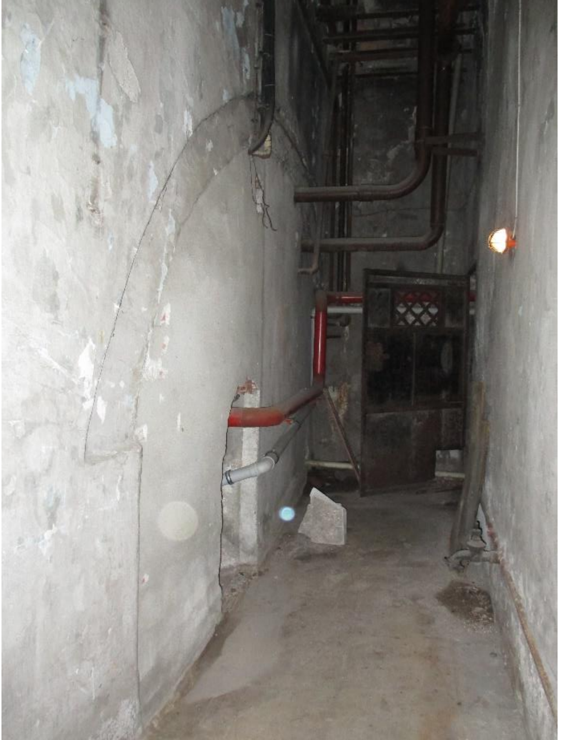
Şekil 4.303 İstanbul Erkek Lisesi bodrum katta sonraki dönemlerde kapatılmış duvar (Saadet Mutlu Kaytan Arşivi, 2017)
