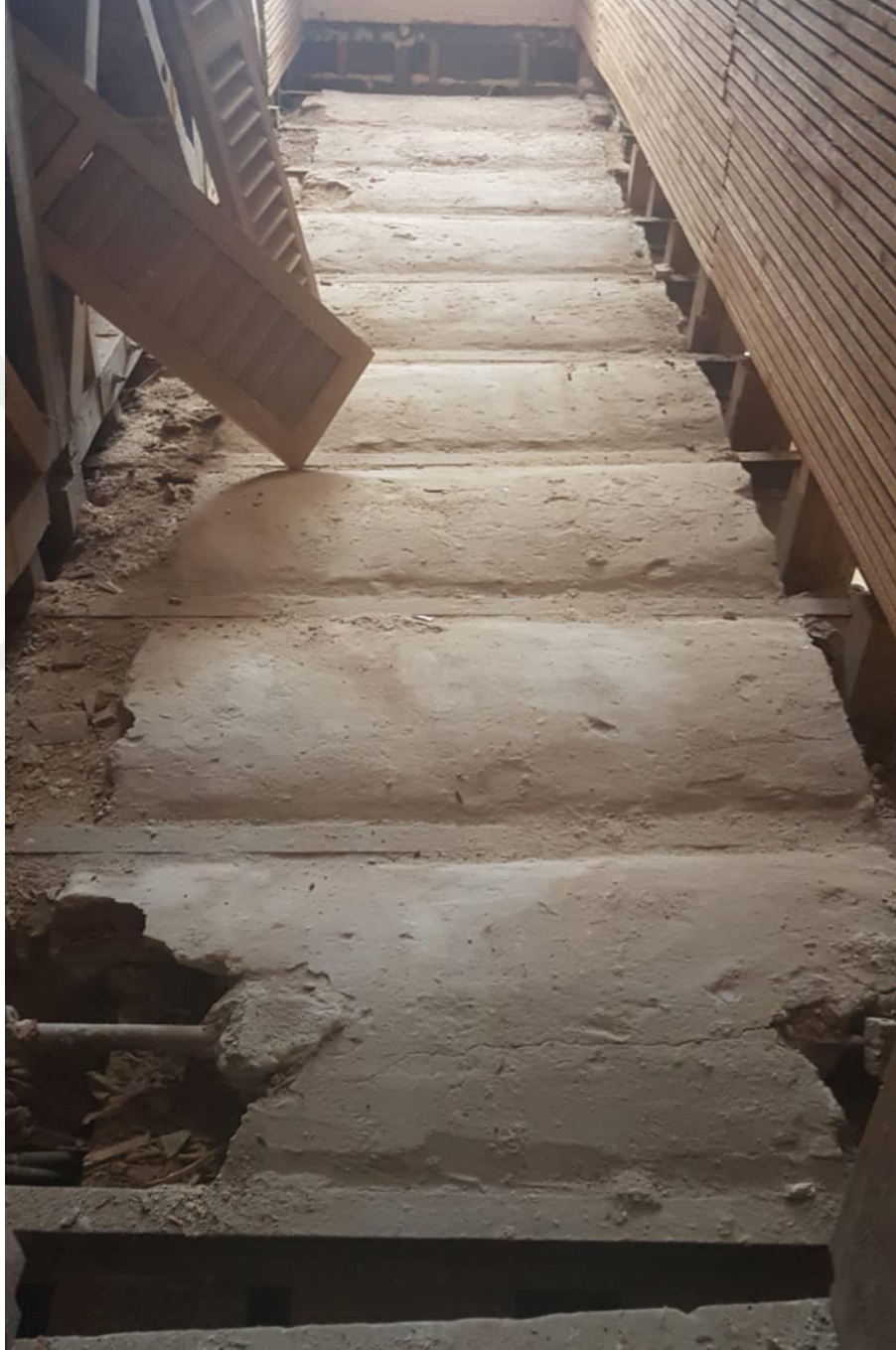
Şekil 4.24 2018 yılında gerçekleştirilen restorasyon uygulaması sırasında ortaya çıkan döşeme ve duvar yapım sistemi (Saadet Mutlu Kaytan Arşivi, 2018)
