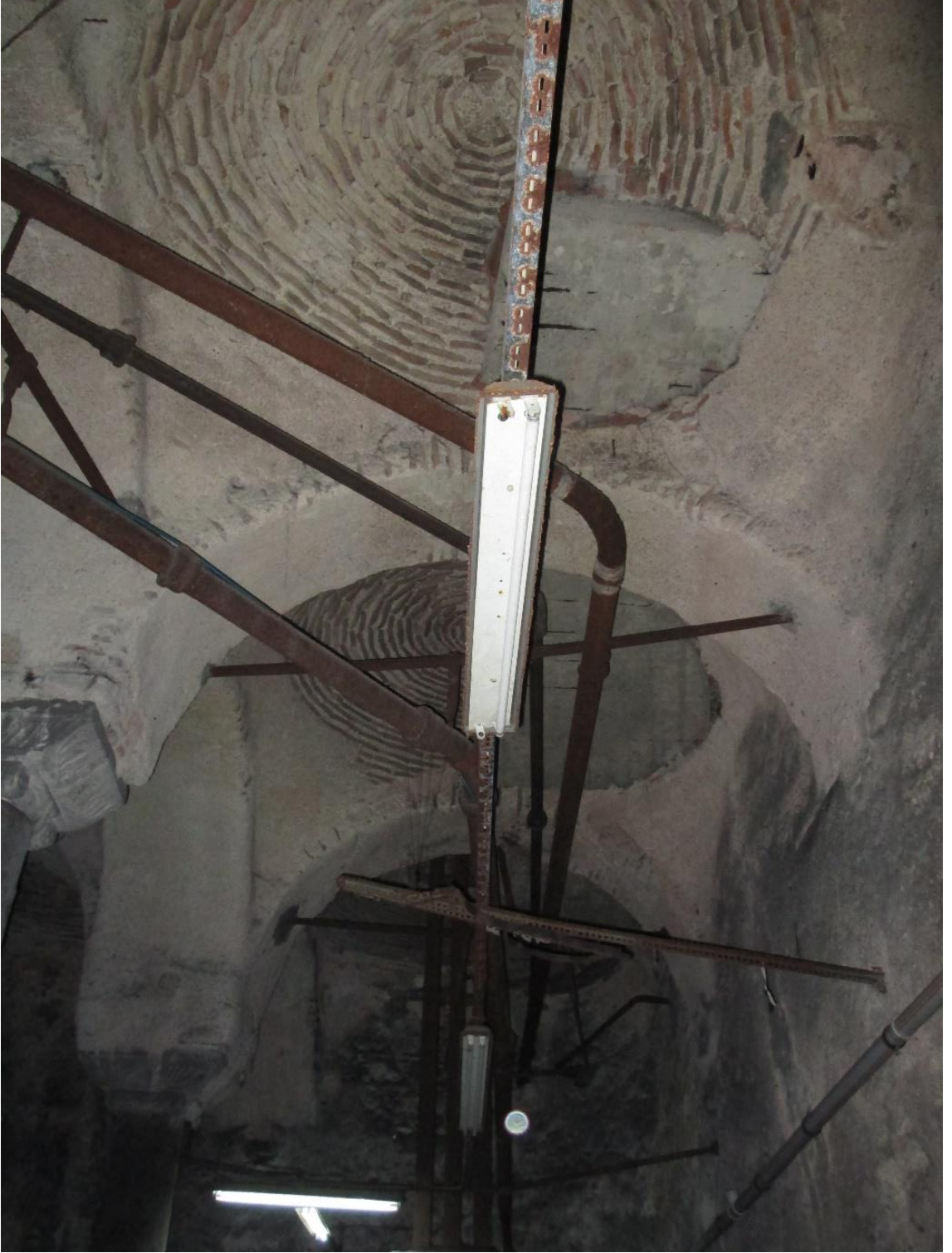
Şekil 4.285 İstanbul Erkek Lisesi ikinci kat bodrumda yer alan Bizans sarnıcı (Saadet Mutlu Kaytan Arşivi, 2017)
