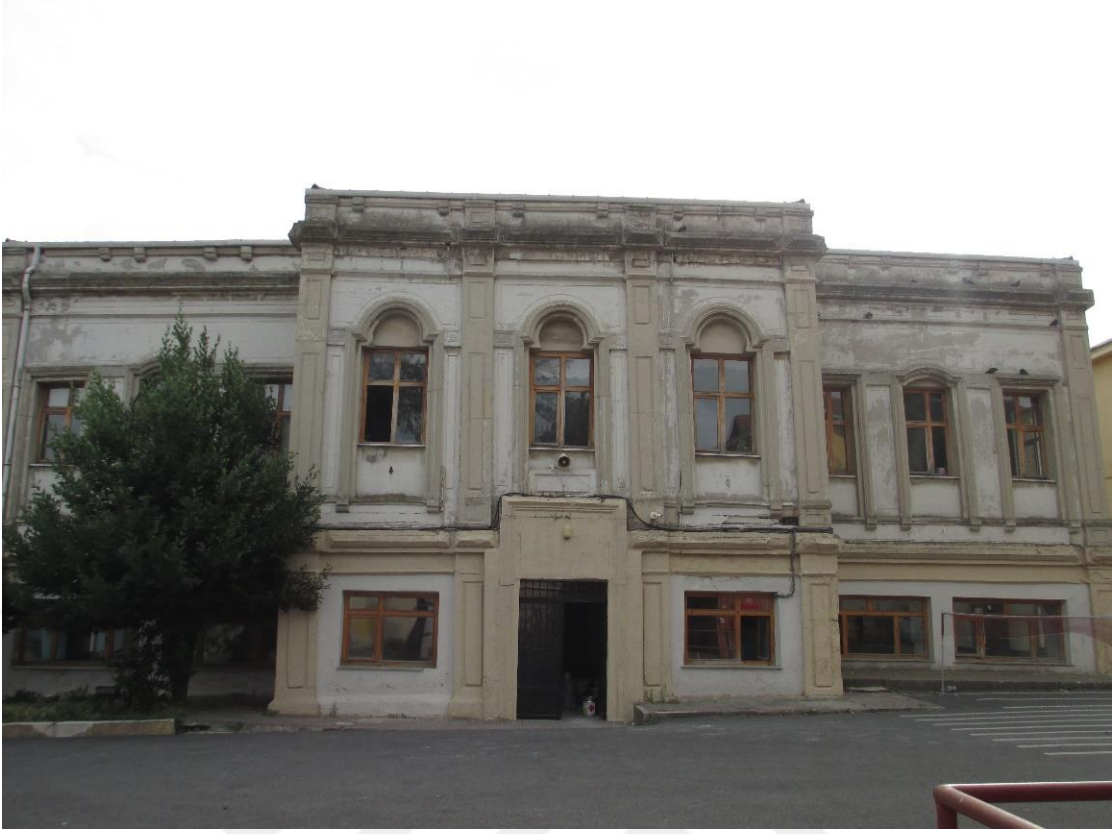
Şekil 4.60 Dış cephe görünümü (Saadet Mutlu Kaytan Arşivi, 2017)
