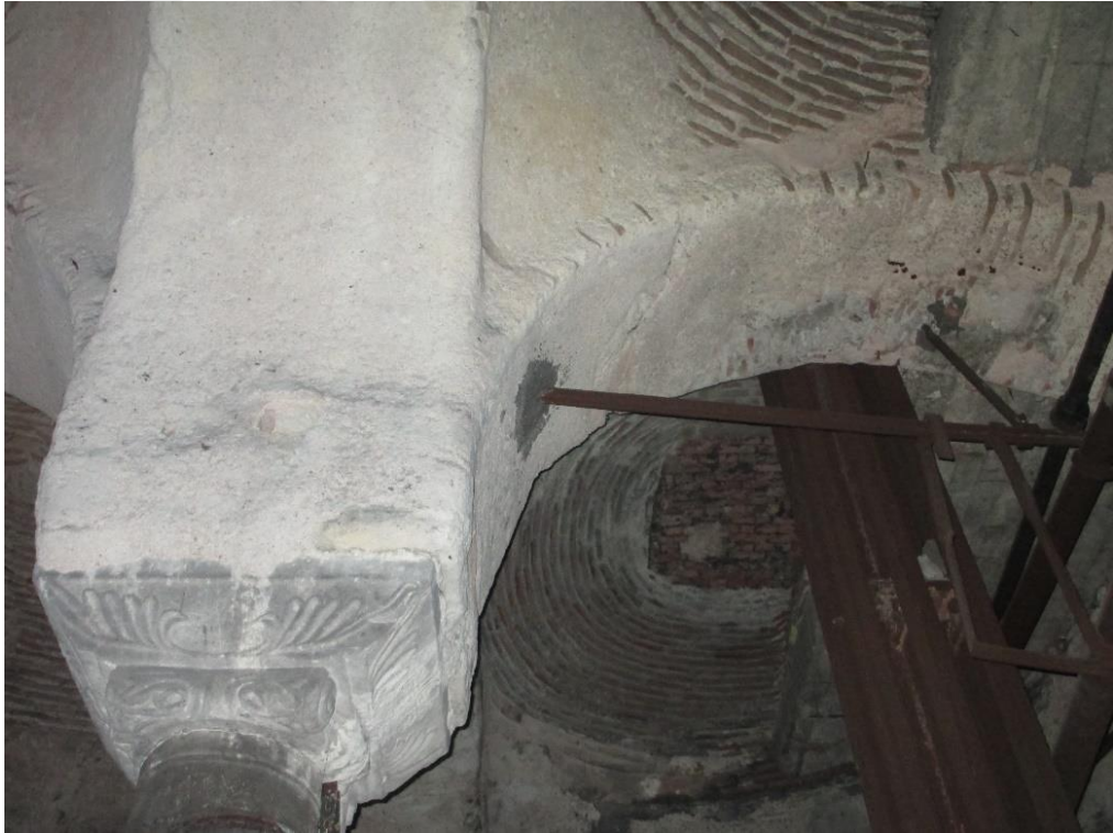
Şekil 4.301 İstanbul Erkek Lisesi bodrum katta yer alan sarnıç ve Vallaury eki çelik kolonlar (Saadet Mutlu Kaytan Arşivi, 2017)
