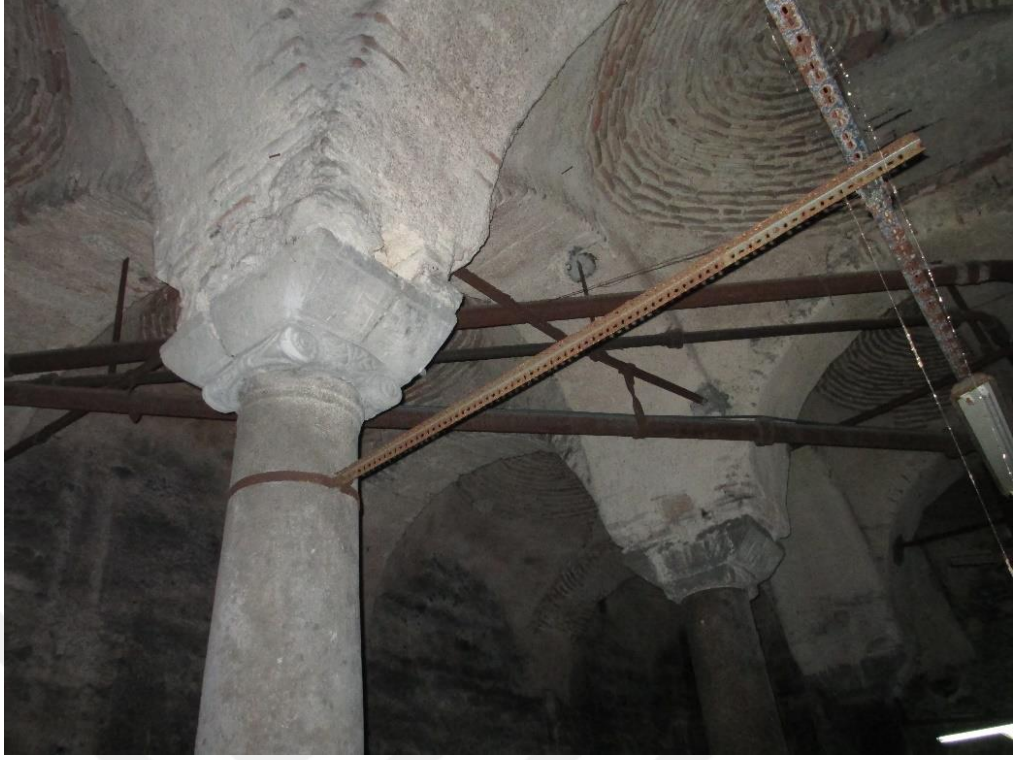
Şekil 4.300 İstanbul Erkek Lisesi bodrum katta yer alan Sarnıç (Saadet Mutlu Kaytan Arşivi, 2017)
