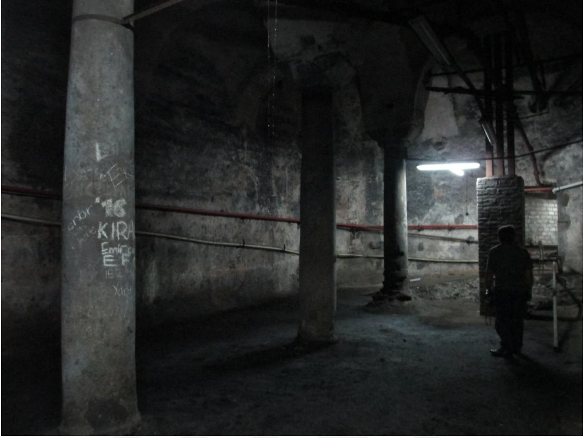
Şekil 4.287 İstanbul Erkek Lisesi ikinci kat bodrumda yer alan Bizans sarnıcı (Saadet Mutlu Kaytan Arşivi, 2017)
