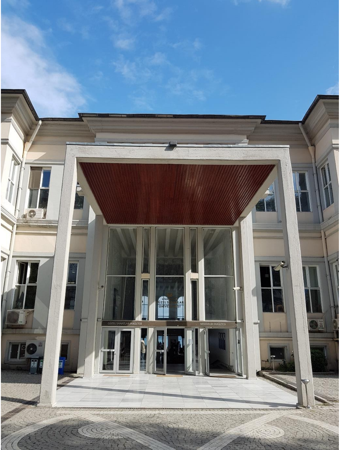
Şekil 4.27 Ana giriş cephesi (Saadet Mutlu Kaytan Arşivi, 2019)
