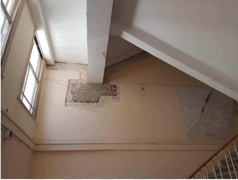
Şekil 4.233 Kabataş Erkek Lisesi betonarme merdiven desteği (Saadet Mutlu Kaytan Arşivi, 2017)
