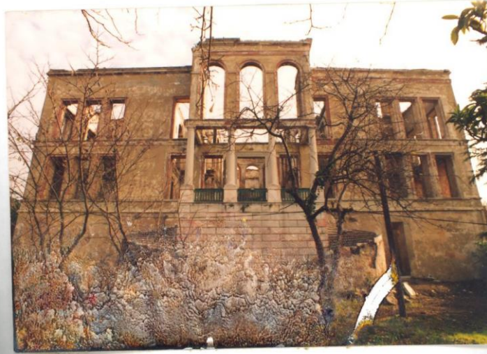
F.2. Saray, Batı cephesi.
