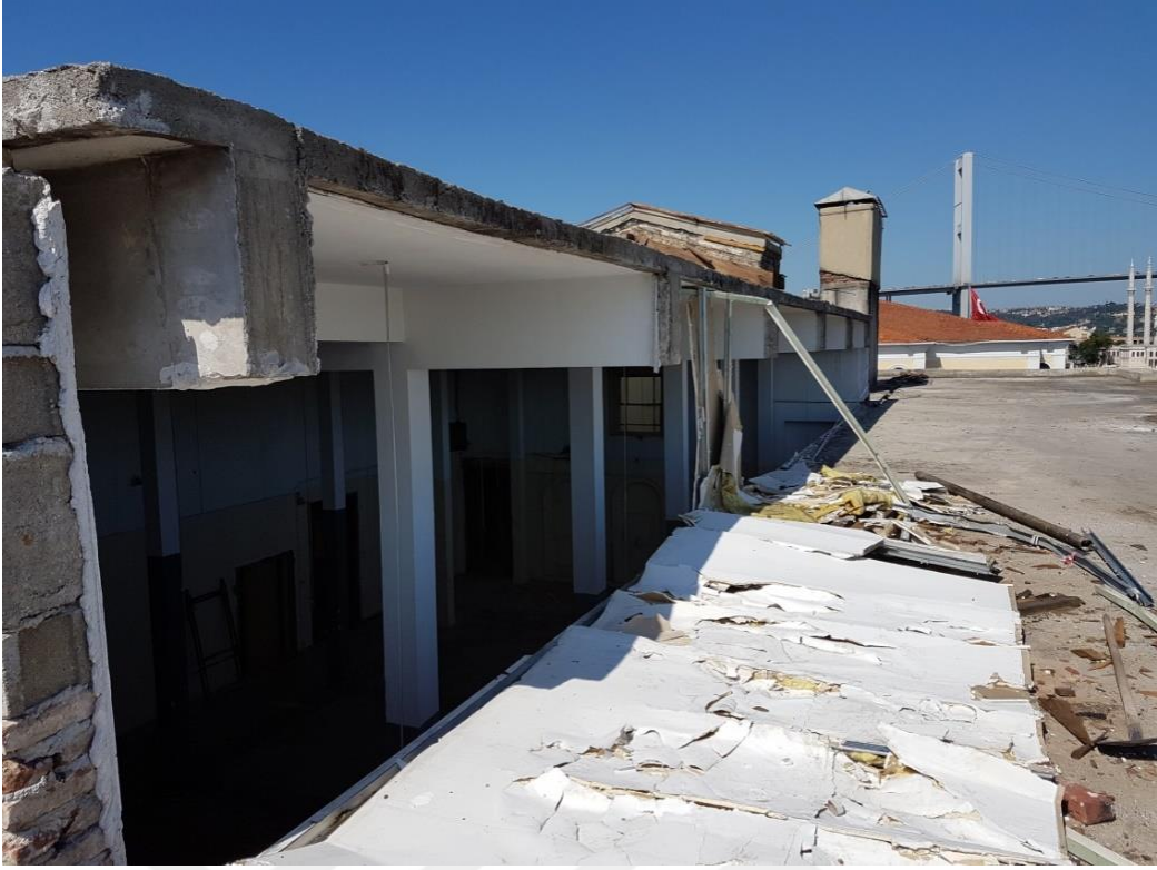
Şekil 4.243 Sonraki dönem uygulaması çatı ışıklığı (Saadet Mutlu Kaytan Arşivi, 2017)
