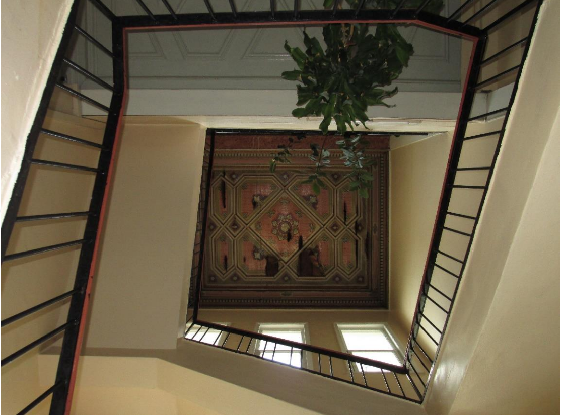
Şekil 4.52 Merdiven kovanında yer alan tavan detayının görünümü (Saadet Mutlu Kaytan Arşivi, 2017)
