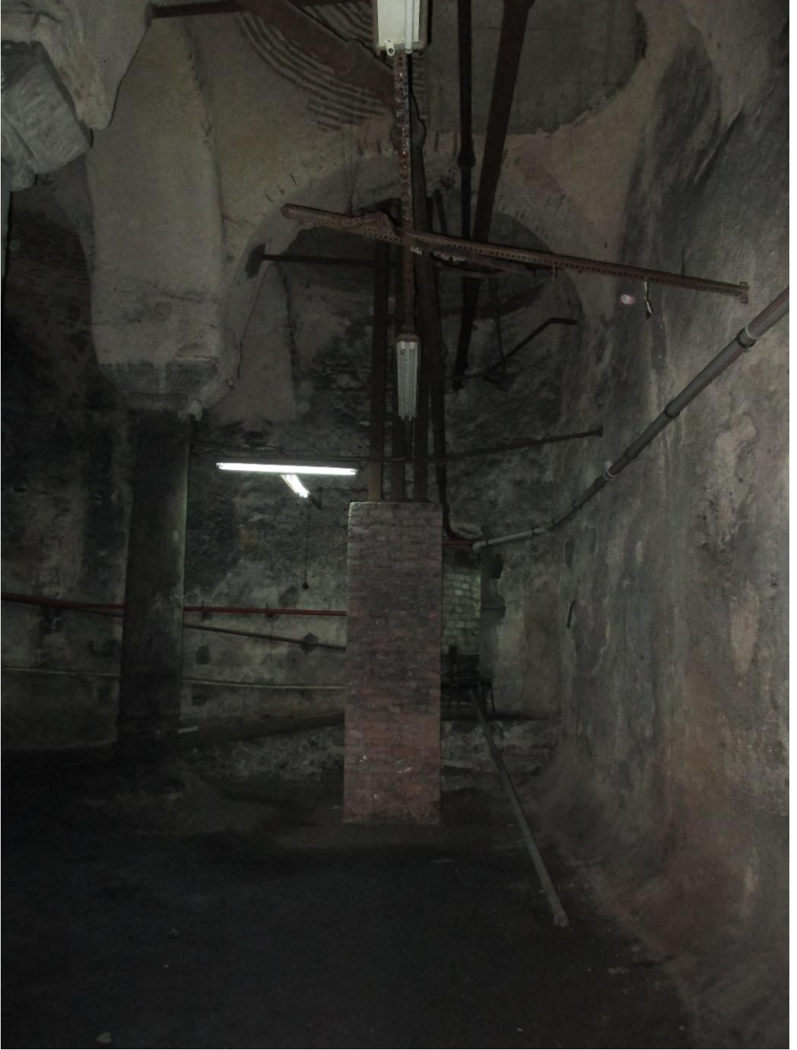
Şekil 4.286 İstanbul Erkek Lisesi ikinci kat bodrumda yer alan Bizans sarnıcı (Saadet Mutlu Kaytan Arşivi, 2017)
