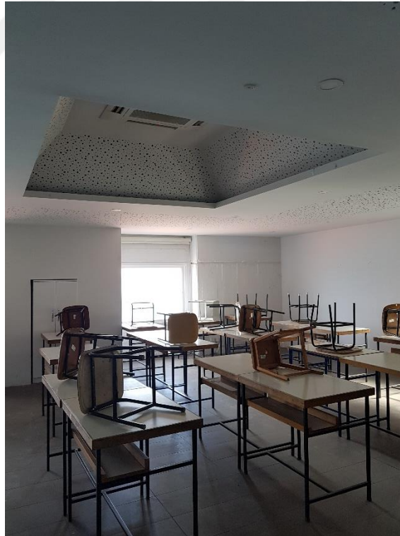
Şekil 4.191 Mimar Sinan Güzel Sanatlar Üniversitesi Mimarlık Fakültesi çatı feneri görünümü (Saadet Mutlu Kaytan Arşivi, 2019)
