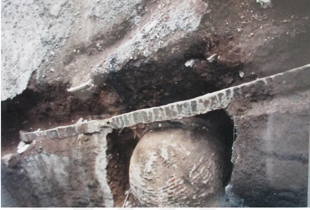
Şekil 4.279 Ek inşaat çalışmaları sırasında bulunan sarnıç kalıntısı (1673, 1973)
