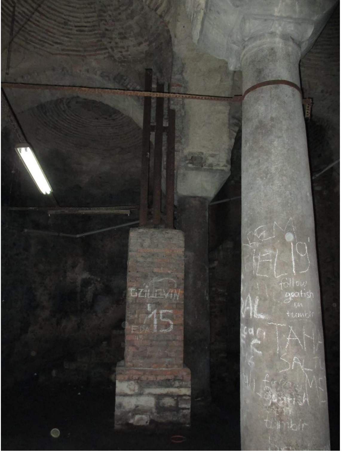
Şekil 4.284 İstanbul Erkek Lisesi ikinci kat bodrumda yer alan Bizans sarnıcı (Saadet Mutlu Kaytan Arşivi, 2017)
