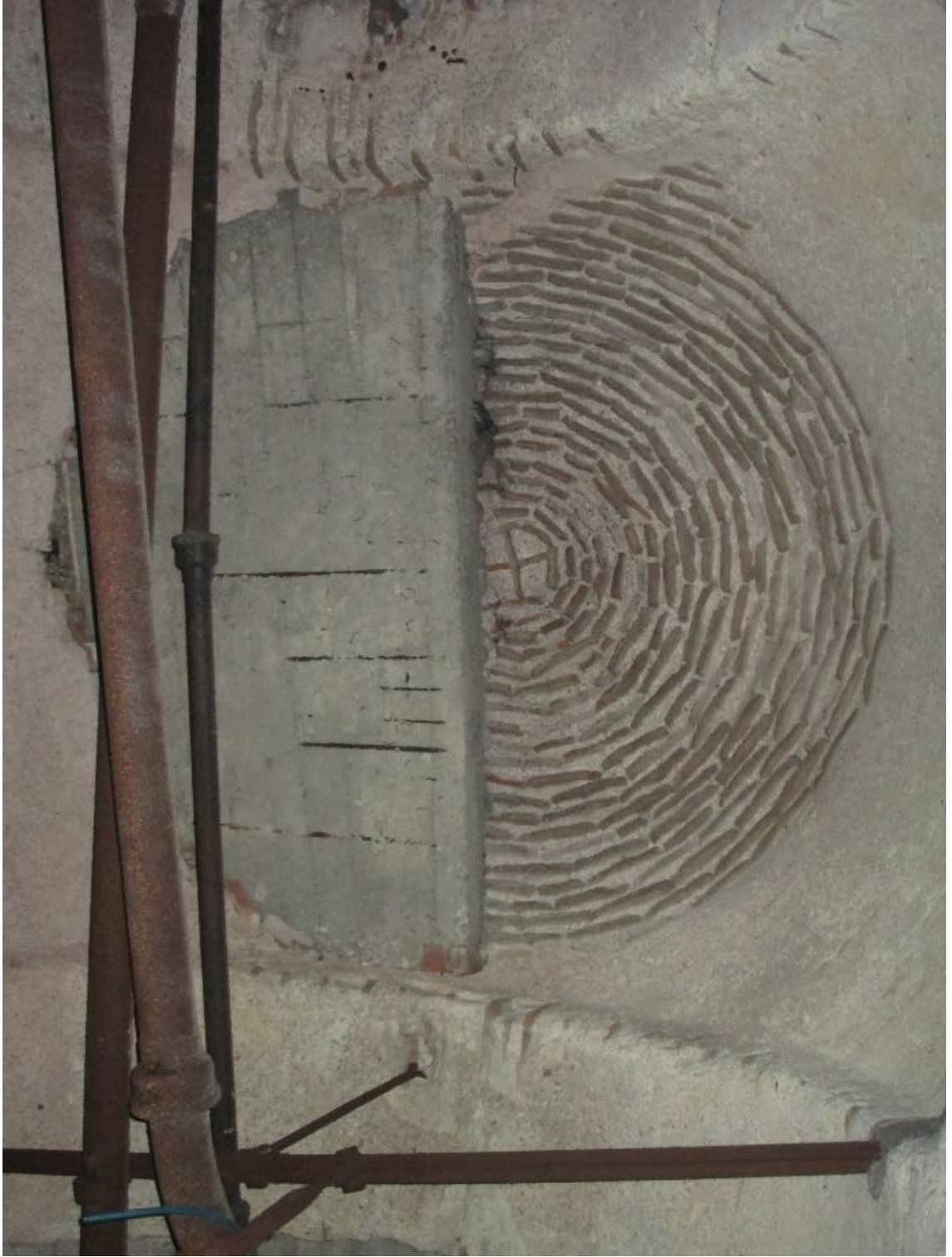
Şekil 4.302 İstanbul Erkek Lisesi bodrum katta yer alan sarnıçta yapılan tavan destek yastıkları (Saadet Mutlu Kaytan Arşivi, 2017)
