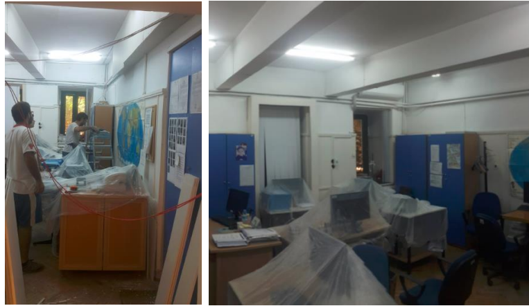
Şekil 4.7 Hacim içi elektrik tesisatının yenilenmesi
