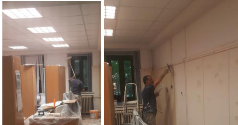
Şekil 4.11 Deney hacmi duvarlarının boyanması
