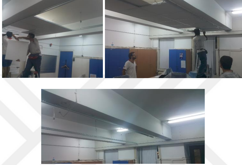
Şekil 4.8 Asma tavan yapımı
