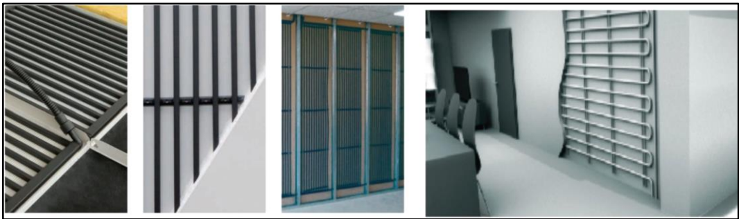
Şekil 3.1 Duvardan ısıtma ve soğutmada kullanılan serpantin paneller
