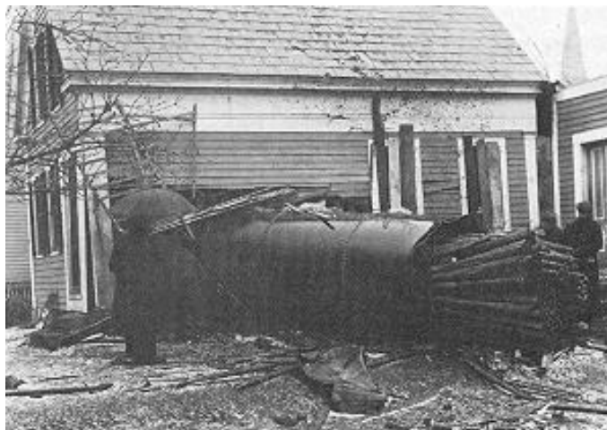
Şekil 3. 1 Ayakkabı fabrikasında kazanın patlamış hali
