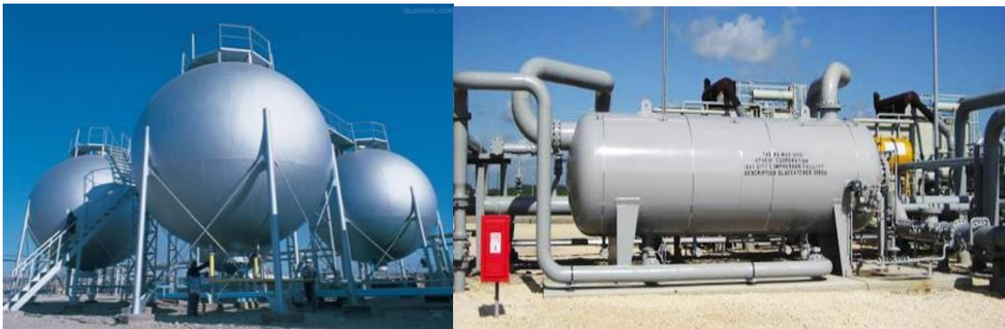
Şekil 2. 1 Küresel ve silindirik basınçlı kaplar
