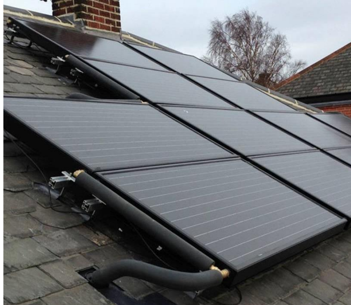
Şekil 2.3 Hibrit PV ve sıcak su uygulaması
