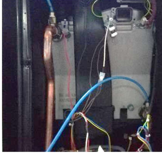
Şekil 5.5 Su basınç ölçümü için ölçüm noktaları ve problemlerin yerleşimi
