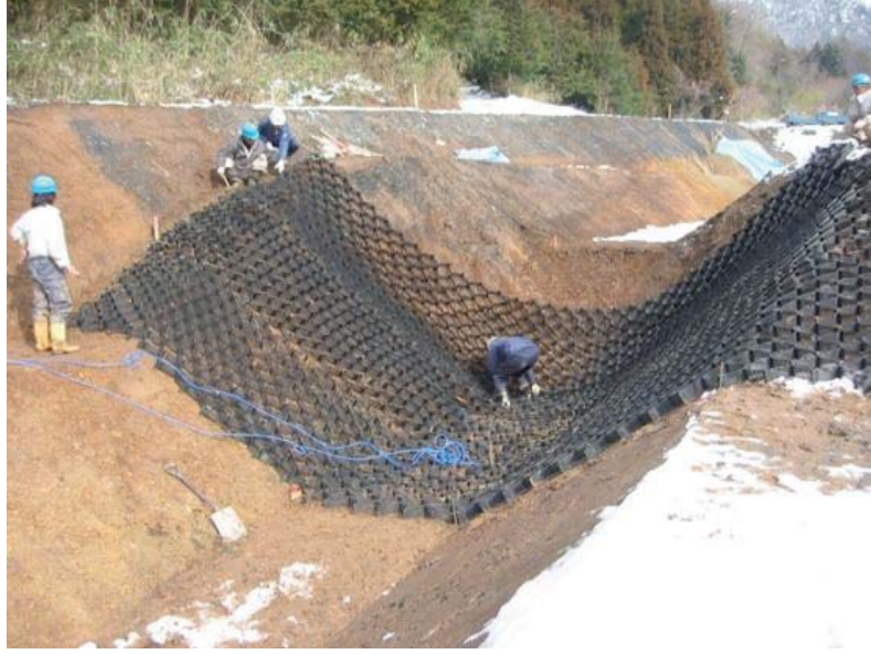
Şekil 4.4 Erozyon kontrol uygulaması
