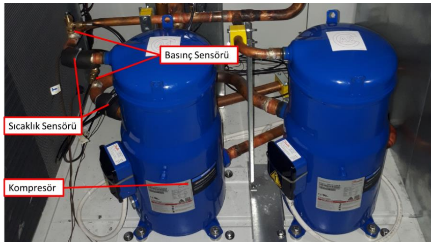
Şekil 3.13 Kompresör tarafındaki sıcaklık ölçümleri
