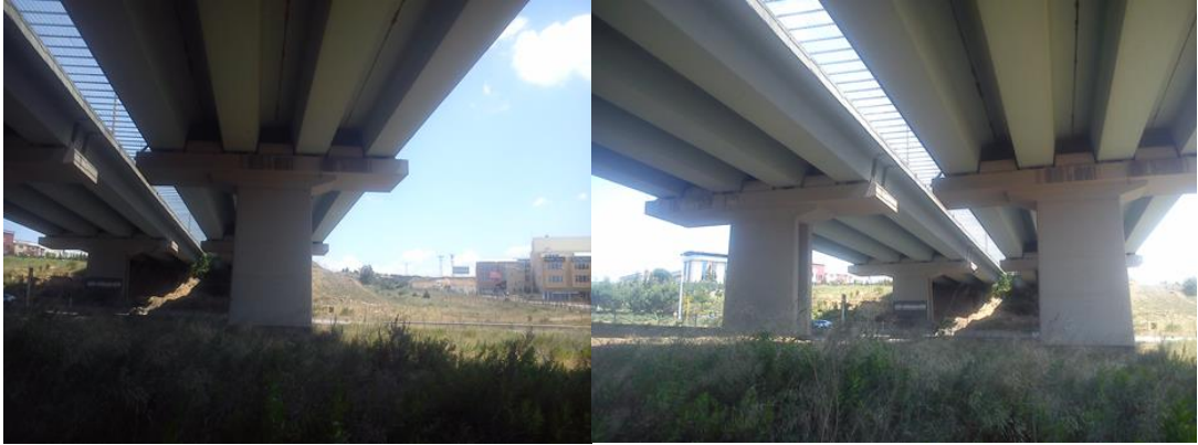
Şekil 4.47 Betonarme karayolu köprüsü
