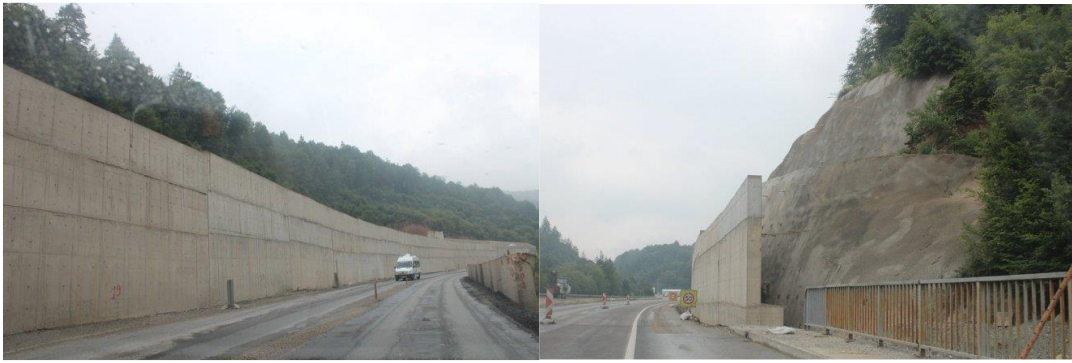
Şekil 4.16 Otoyol boyunca sık rastlanan betonarme istinat duvar örneği [126]
