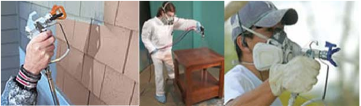
Şekil 2.34. Püskürtme yöntemiyle uygulama
