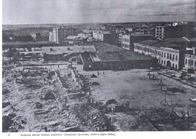
Şekil 4.115 Taksim Kışlası yıkılırken (Gülersoy, 1999, s.44)
