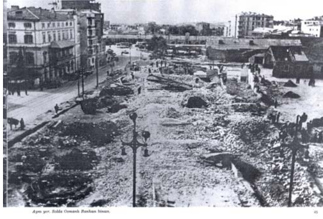
Şekil 4.116 Taksim Kışlası yıkılırken (Gülersoy, 1999, s.45)
