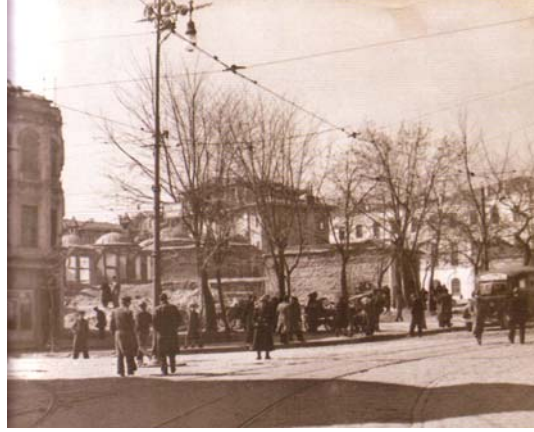
Şekil 4.96 Beyazıt Meydanı'nda bugün Vakıf Hat Sanatları Müzesi olan medrese çevresindeki 19. yüzyıl yapılaşması yıkılırken (Anonim, 02/2003, s. 85)
