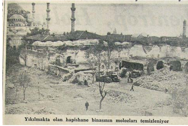
Şekil 4.170 Hapishane binası yıkılırken (Cumhuriyet, 16 Kasım 1939)
