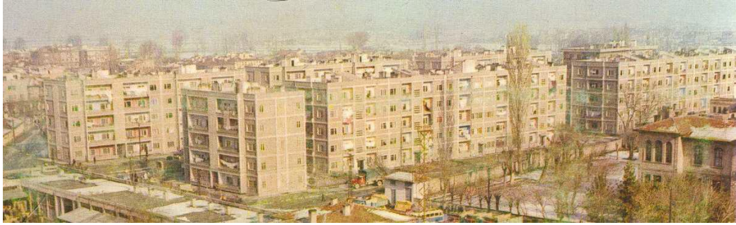
Şekil 3.31 Kayseri Belediye Blokları görünüşü. 1968 [112]
