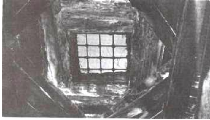
ıekil 3.11 Güpgüpoğlu Konağı. Tokanadaki havalandırma ve aydınlatma için kullanılan tavandaki açıklık 1
