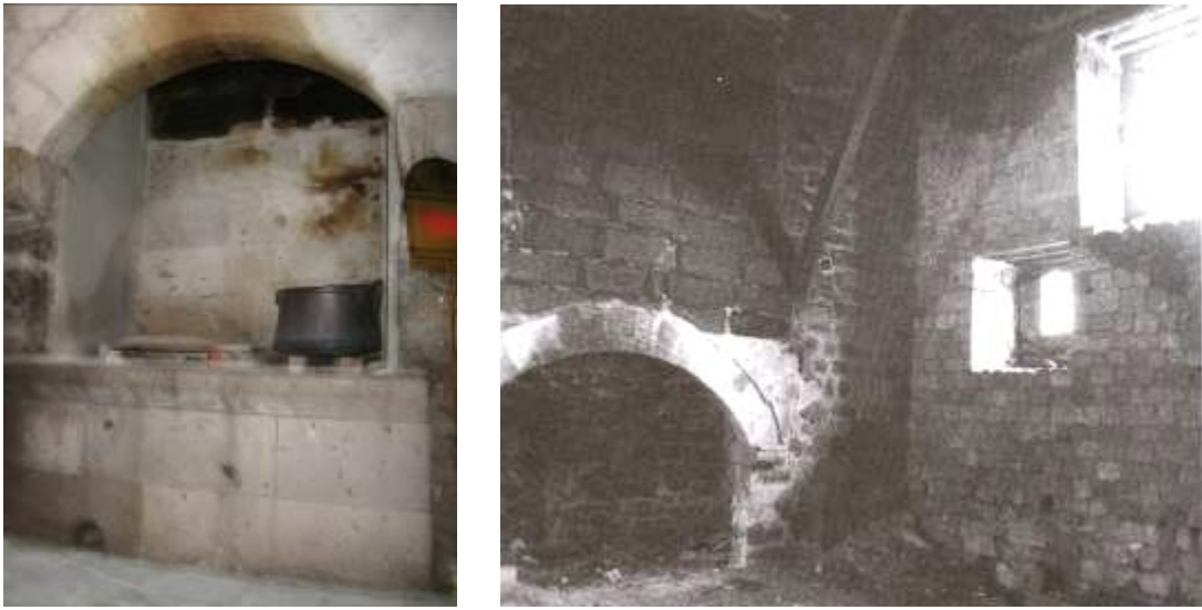
Şekil 3.10 A-Güpgüpoğlu Konağı, Tokana-Ocak ve tandır bölümü 1 B- Zennecioğulları Konağı tokanasındaki ocak elemanı [4]
