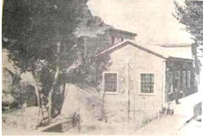
Şekil 4.16 Bünyan Elektrik Santrali 1
