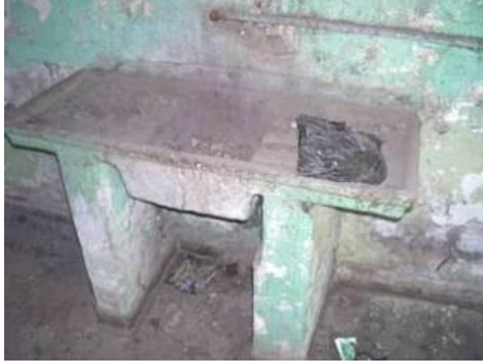
Şekil 4.17 S.K.B. Fabrikası, Dış Vazife Evlerinde eviye örneği. 1942-1945 2
