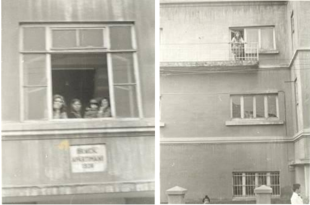
Şekil 3.35 Örnek Apartmanı cephesi. 1938 3
