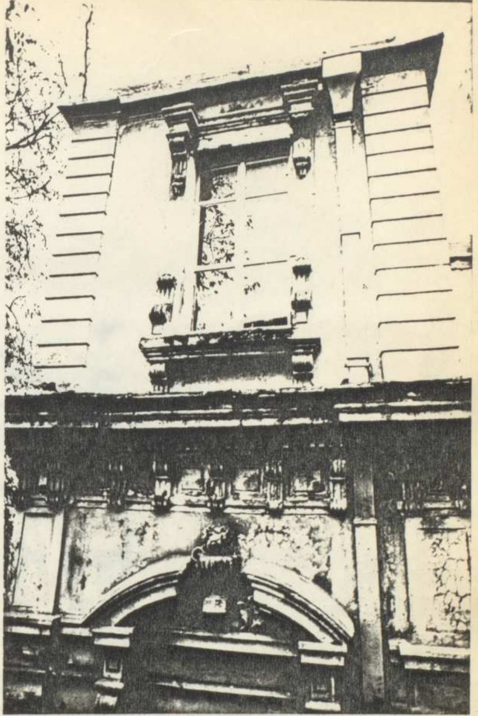
Kızlarağası D. Kuzey cephe (kısmı)
