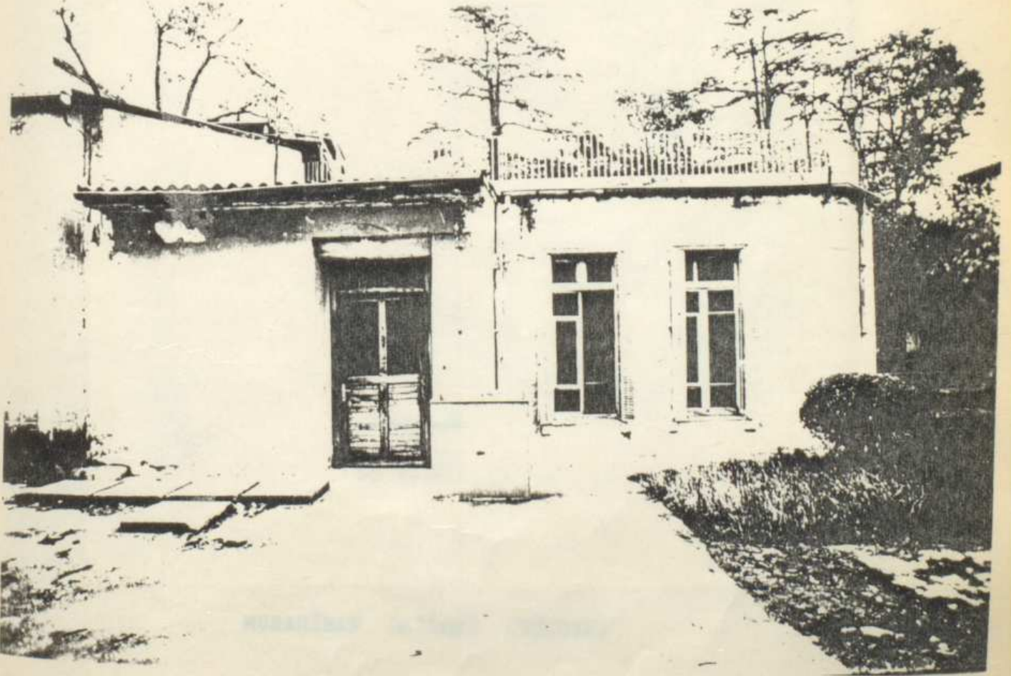
Musahiban darası güney cephesi
