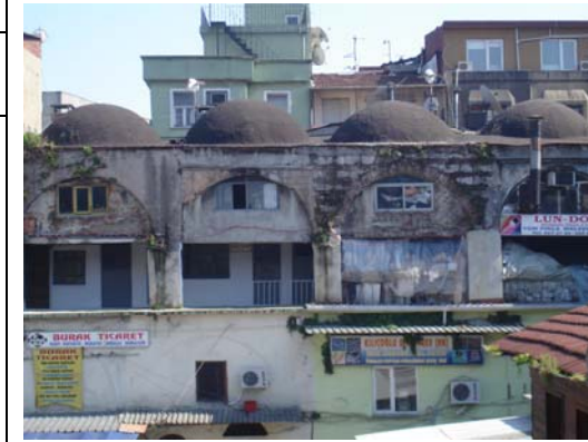
Güney-doğu cephesindeki revak modülleri
