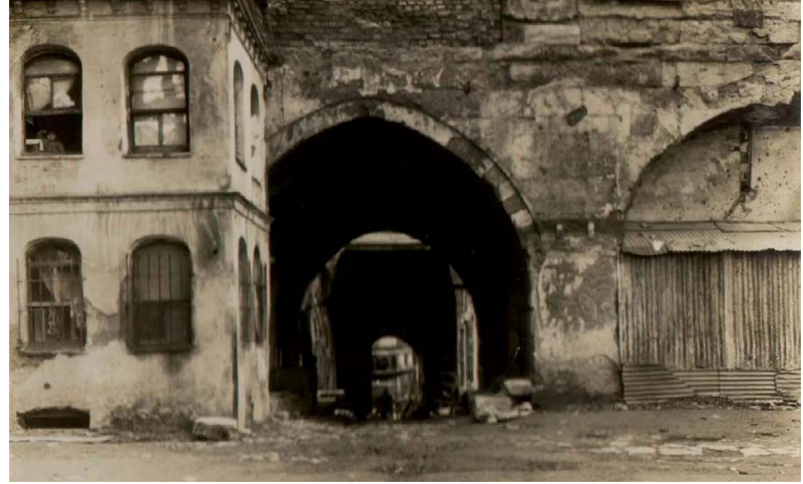
Geçitten 2. avluya çıkıştaki hanın önündeki geleneksel ek yapı
