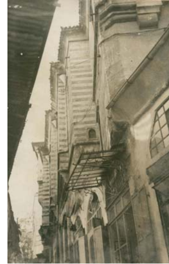
Sultan Mektebi sokaktan dış cepheye bakış
