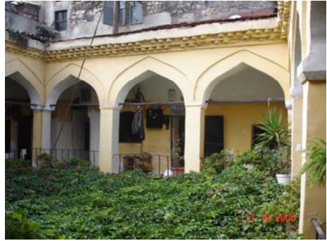
Avludan revak görünüşü ve metal gergiler
