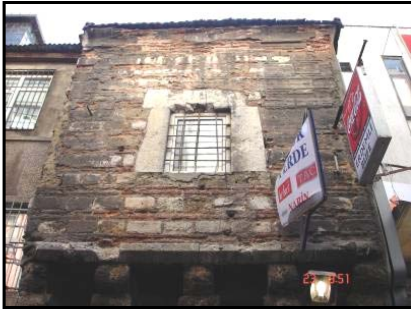
Fotoğraf 6.34 Leblebici Han'ın cephesinde malzeme yüzeyinde kopmuş küçük parçalar
