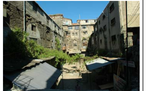
3. avlu doğu cephesi ve sol arka köşedeki Saint İrene Kulesi
