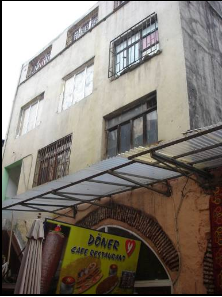
Fotoğraf Ek- 3 Birinci avlu doğu cephesi, özgün zemin kat revakı üzerine yapılmış günümüz dönem eklentisi
