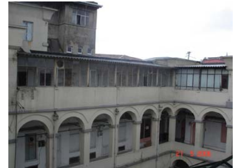
Güney-batı cephesi eklenti yapı
