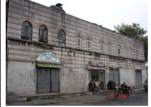
Ragıp Gümüş Pala Cad. onarım görmüş dış cephesi
