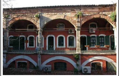
Güney cephesi üst kat revakları
