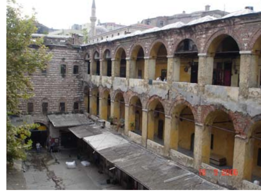
1. avlu batı cephesi revakları
