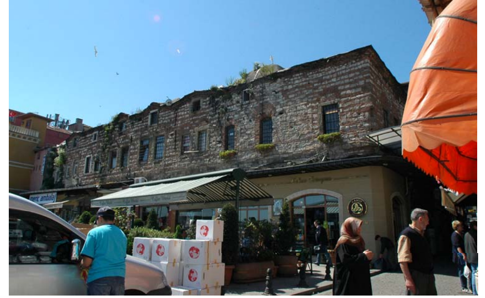
Kuzeybatı cephesi (Büyükbaz sok.)
