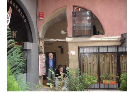
Kuzey cephendeside değiştirilen zemin kat revakı
