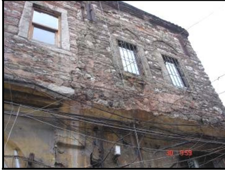
Fotoğraf 6.35 Rüzgarın cephe yüzeyine etkisi (Varakçı Han)
