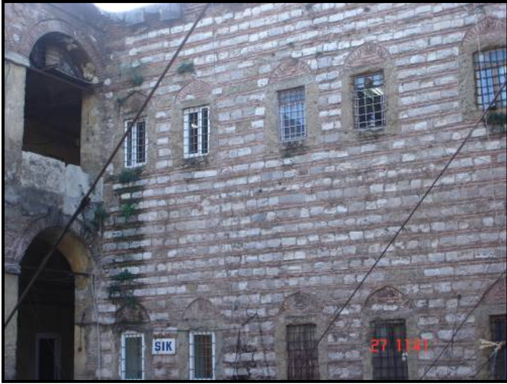
Fotoğraf 5.19 Büyük Yeni Han hafifletme kemeri. Kapı ya da pencere boşluklarını oluşturmak ve boşluk üzerindeki duvarın desteklenmesi için boşluk açıklığının büyüklüğüne bağlı olarak; taş lento ve hafifletme kemeri kullanılmıştır
