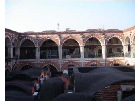
Kuzey cephesindeki 1. kat revak modülleri
