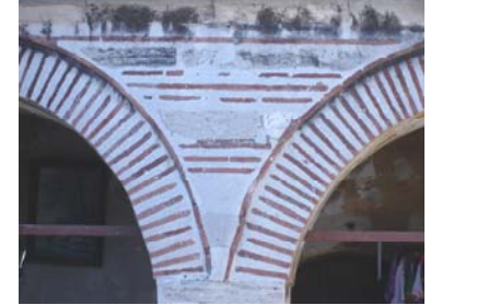
Onarımı yapılmış revak duvarı
