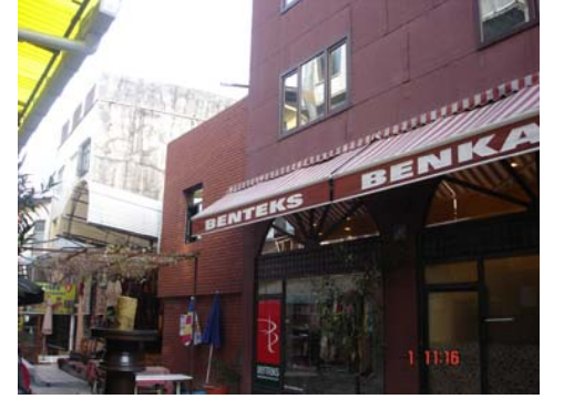
1. avlu (iç cebeci han) doğu cephesi
