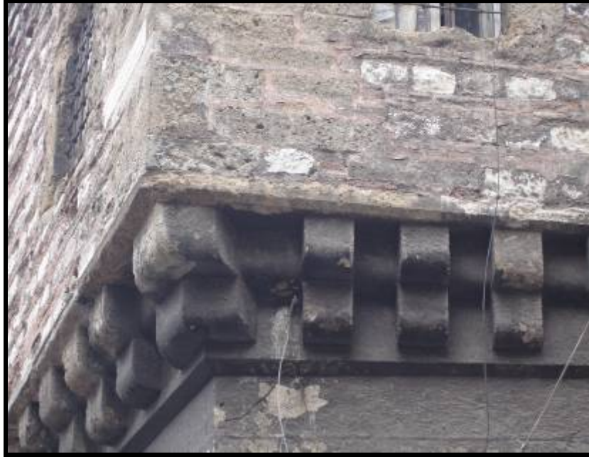
Fotoğraf 6.16 Taş konsollardaki kabuklanma ve kirlenme
