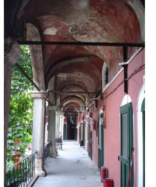
Revakların çapraz tonoz üst örtüsü
