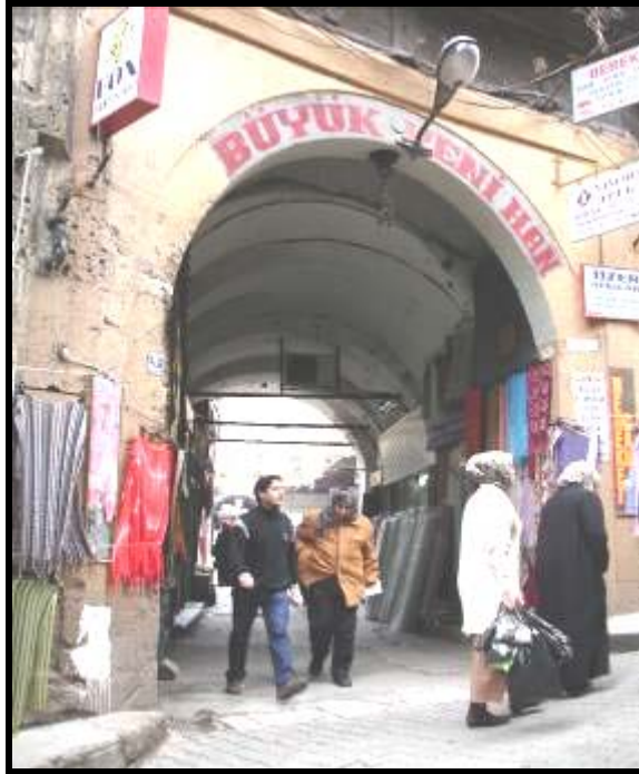
Fotoğraf 5.23 Köşenin taş malzeme ile oluşturulması. Büyük Yeni Han Çakmakçılar Yokuşu köşesinin zeminden saçak altına kadar taş malzeme ile oluşturulduğu görülmektedir
