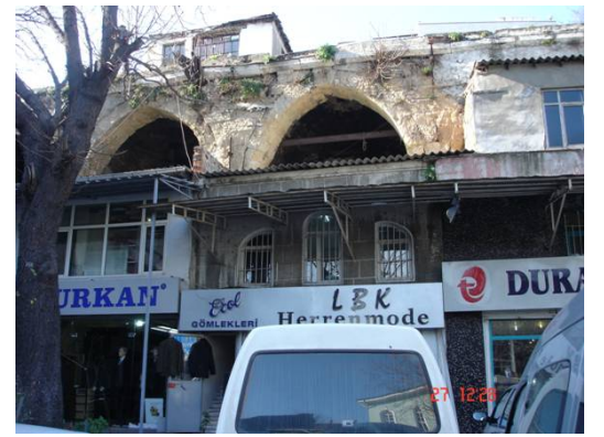
3. avlu da revakların üzerindeki ek yapılar
