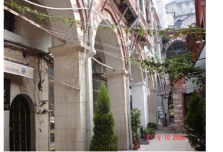
Zemin katta revaklar ve dükkanlar (doğu cephesi)
