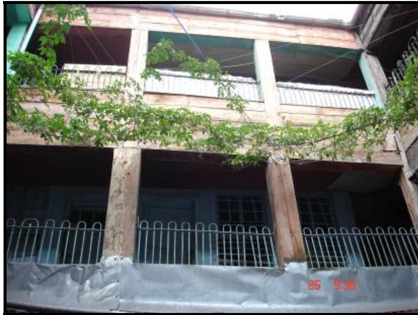
Fotoğraf 4.7 Demirtaş Han iç cephe (ahşap kolon ve döşemeleri) (K: karışık yapım tekniği)
