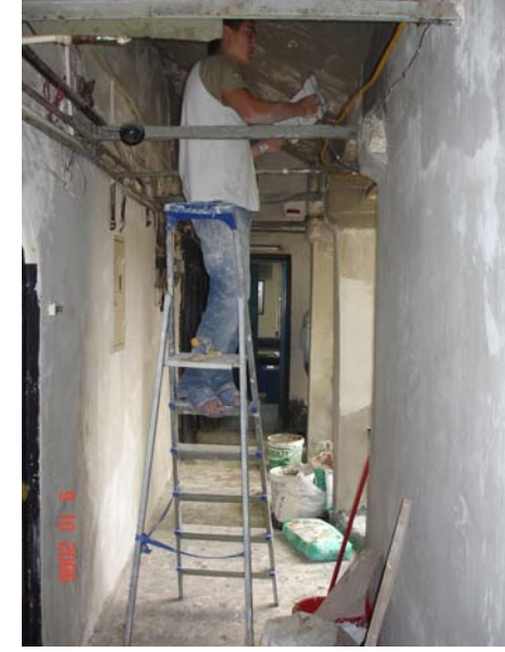
1. kat revaklarındaki onarım
