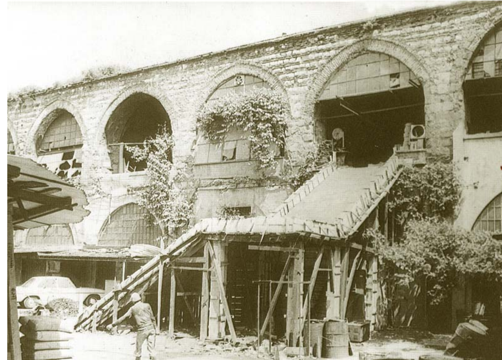
2. avlu güney cephesine eklenen merdiven, 1975
