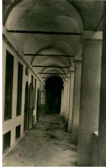
Doğu cephesi revakı
