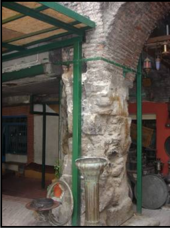
Fotoğraf Ek- 9 İkinci avlu Kuzeybatı köşesindeki revak payesi ve sergileme ünitesi üst saçağı
