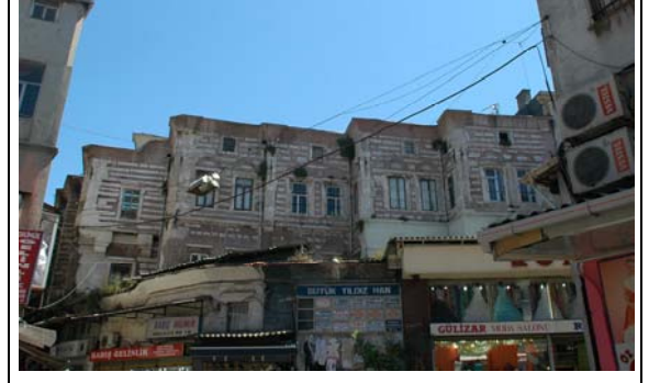
Batı cephesi (giriş)
