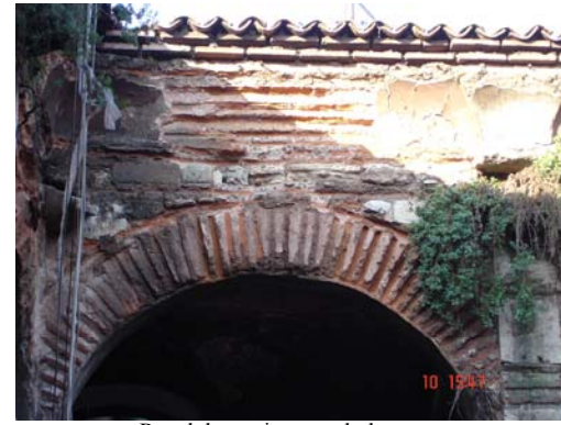
Revak kemeri ve saçak detayı
