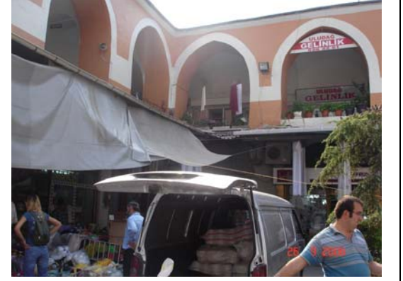
1. avlu güneydoğu revakları
