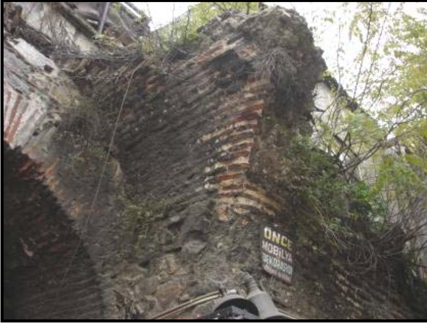
Fotoğraf Ek- 15 İkinci avludan üçüncü avluya olan geçitin başındaki kemer ile aynı zamanda yapıldığı görülebilen ikinci avlunun kuzeybatı köşesindeki revak kemerinin başlangıcı bir arada görülmektedir.
