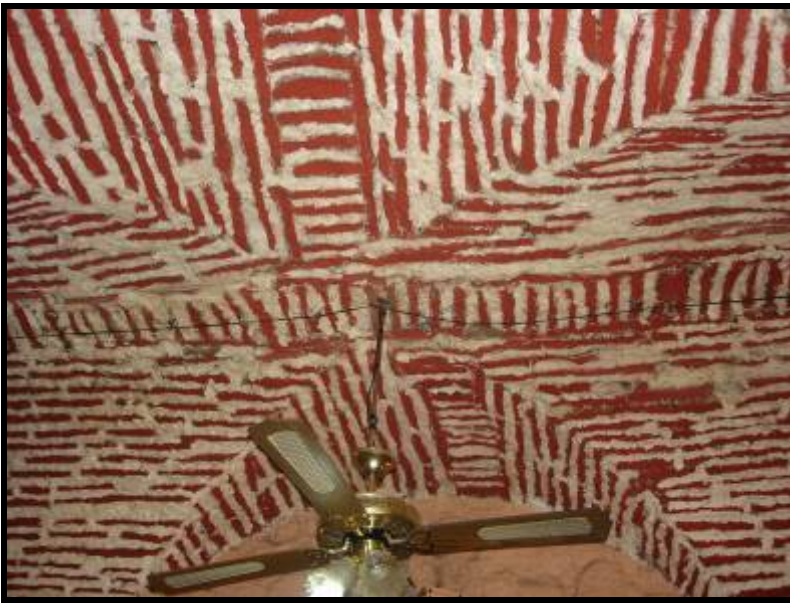
Fotoğraf Ek- 4 Önceki fotoğrafta görülen zemin kat revakının özgün tuğla üst örtüsü
