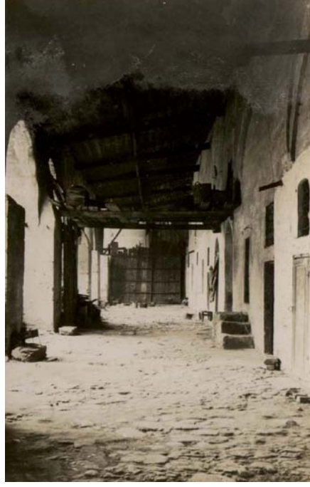
2. avlu 1. kat kuzey revakı ve yer döşemesi
