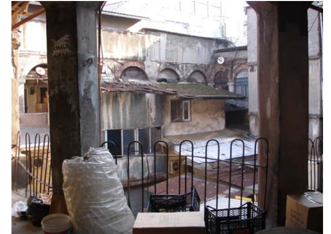
Revaklardan avlu görünüşü
