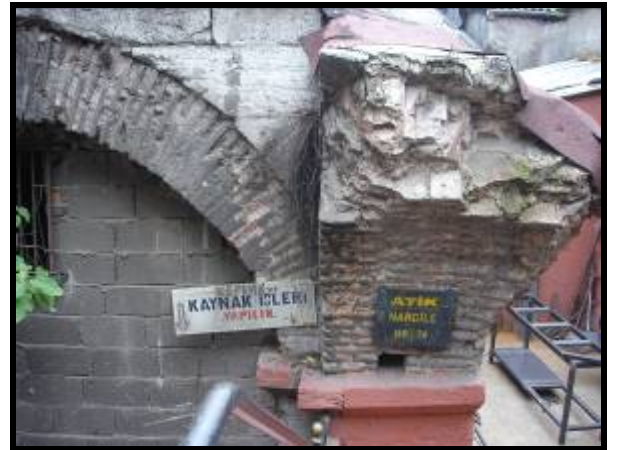
Fotoğraf Ek- 18 Üçüncü avlunun ortasındaki revak payesinin kuzey yönüne devam eden kemer ve üzerindeki kesme taş revak duvarı. Ayrıca hanın üçüncü avlusunun üçüncü katına ait kat silmesi de görülmektedir.
