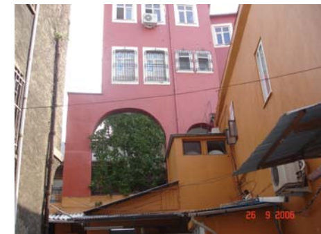
2.avlunun doğu cephesinden görülen yeni yapı
