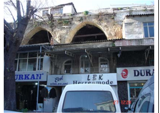
Güneydoğu cephedeki revaklar
