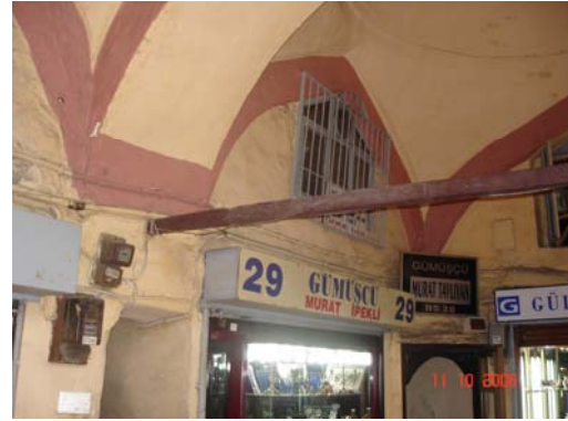
Üst kat revak kemerleri ve metal gergi
