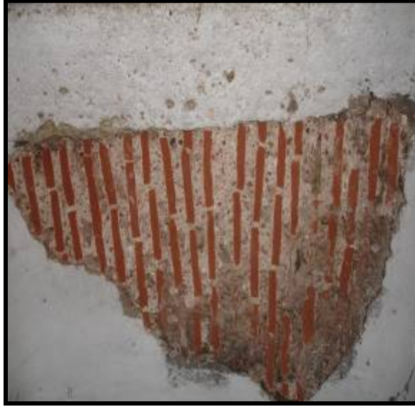
Fotoğraf 6.25 Çukur Han'ın sonraki dönemde yapılmış tonoz sıvasındaki dökülmeler
