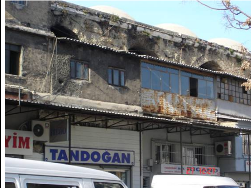
2. avlu batı cephesi ve han önündeki ek yapılar
