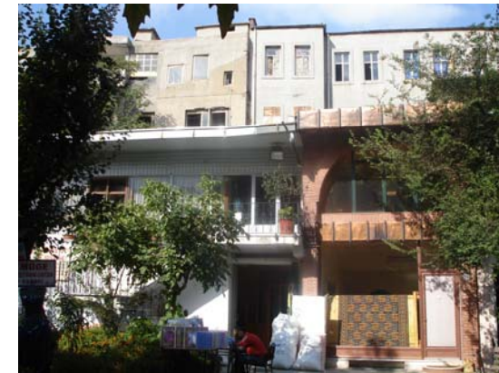
2. avlu batı cephesi
