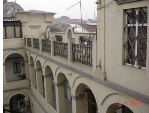
Çatı hizası ve revaklar
