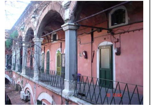
Kapatılan zemin kat revakları
