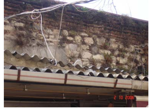
Doğu cephesindeki özgün duvar örgüsü
