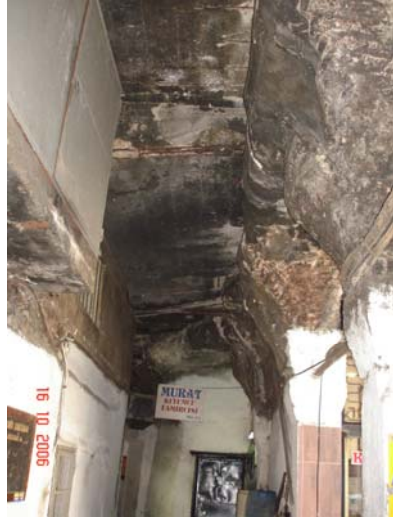
Zemin kat revak iç tarafı
