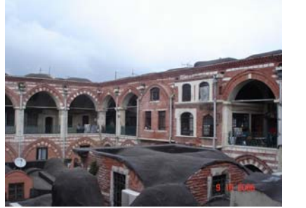
Kapatılan revaklar (kuzey-doğu cephesi)
