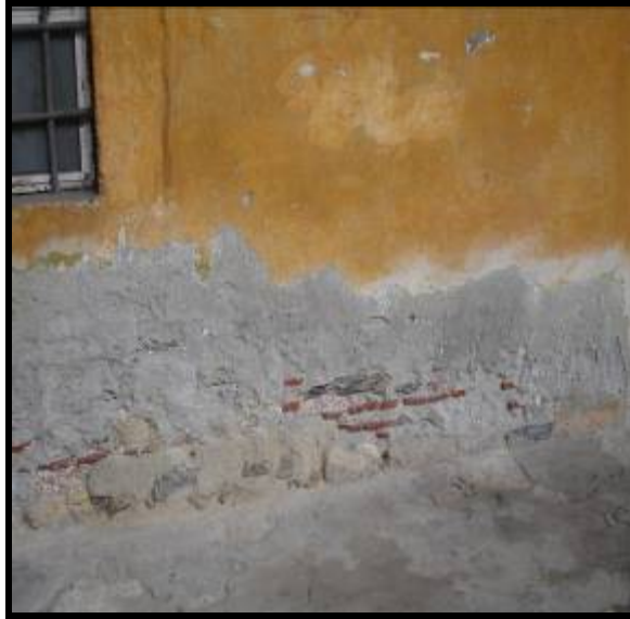
Fotoğraf 6.24 Çukur Han’ın sonraki dönemde yapılmış sıvasındaki dökülmeler
