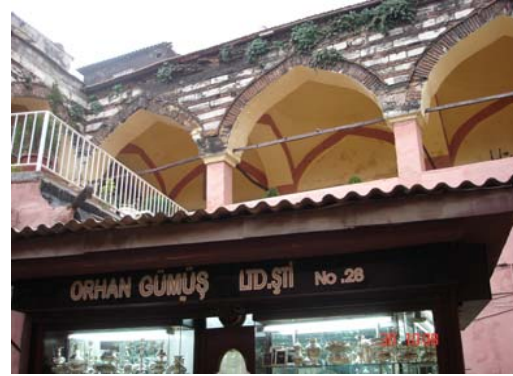
Doğu cephesi 1. kat revakları
