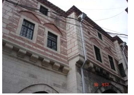
Batı (giriş kapısı cephesi) cephesindeki duvar örgüsü ve pencere modülleri
