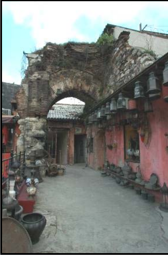
Fotoğraf Ek- 11 İkinci avlu Kuzeydoğu köşesinde kalan revak
