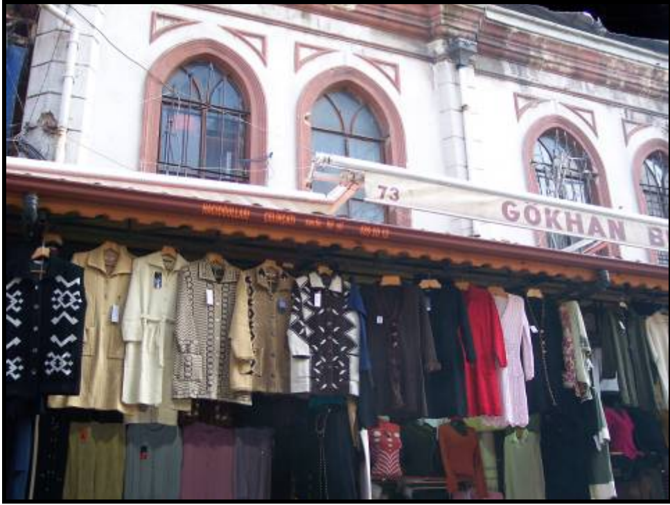
Fotoğraf 4.4 Camili Han dış cephesi (kagir duvar) (K: karışık yapım tekniği)
