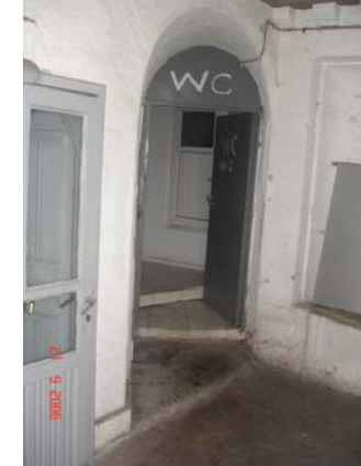
Köşe oda wc mekanına dönüştürülmüştür
