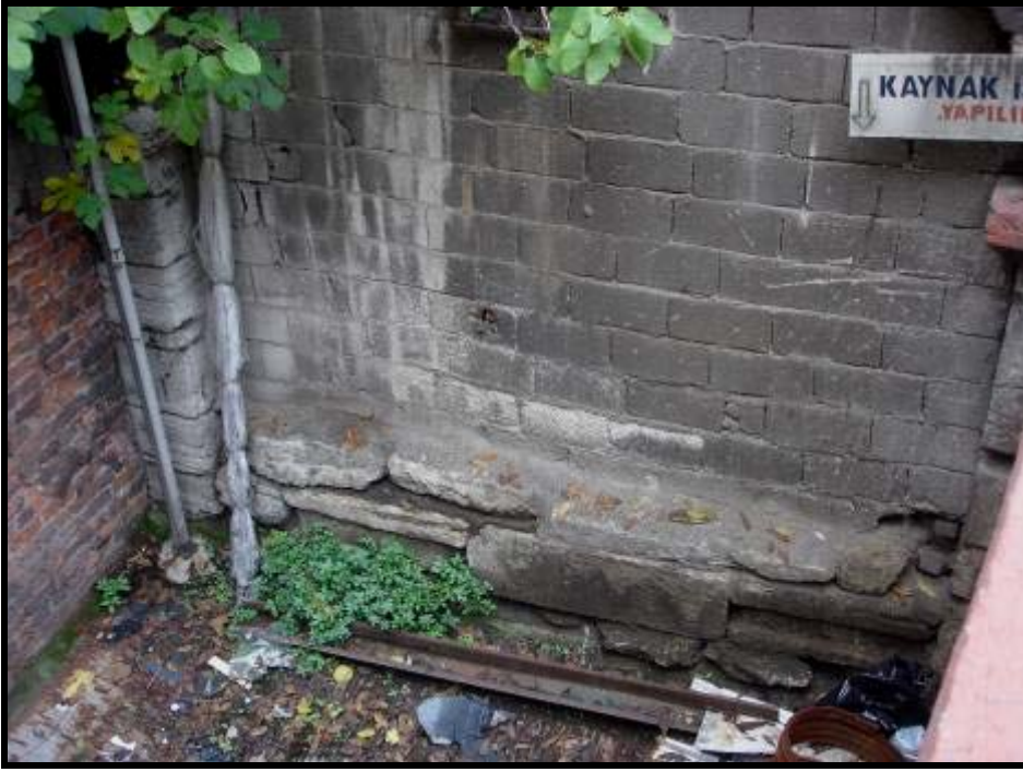
Fotoğraf Ek- 19 Üçüncü avlunun zemin kattaki derinlik ölçüsü görülebilmektedir. ortasındaki revak payesi fotoğrafın sağ köşesindeki kesme taşlar .. revak payesinin zemin kattaki devamını, sol köşesindeki kesme taşlar kuzey yönündeki revak payesine aittir. Alt tarafta görülen blok kesme taşlar ise zemin kat revak kotunu göstermektedir. Birinci avlunun zemin döşemesi hakkında bilgiye henüz ulaşamamış olmamakla birlikte, ikinci ve üçüncü avlu zeminlerinin toprak olduğu düşünülmektedir. Revak duvarı günümüz malzemesi ile örülerek kapatılmıştır.
