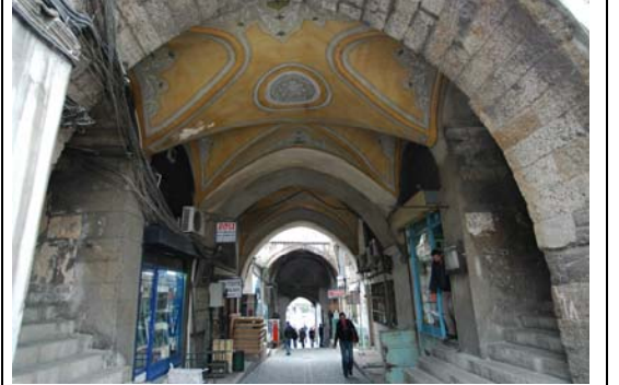
2. avluya çıkan geçitteki 2 yöndeki merdiven
