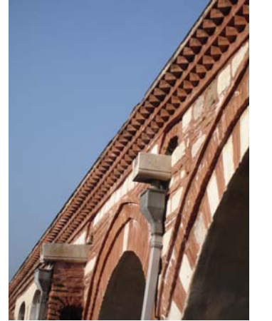
İç cepheden kirpi saçak detayı
