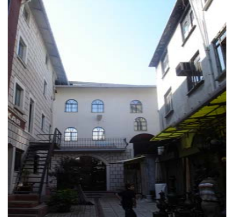
1.avlu güney cephesi
