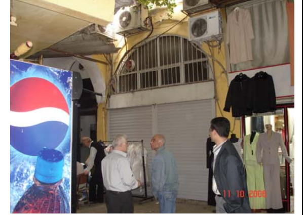
Zemin kat revakları
