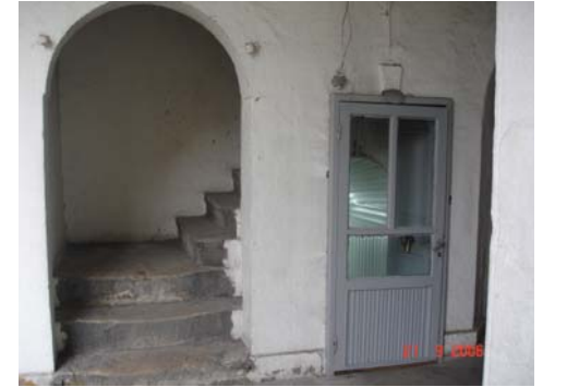
Doğu cephesi 1. kattan 2. kata çıkış merdiveni
