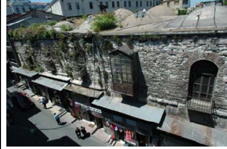
Güney (giriş) cephesi
