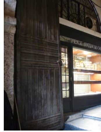
Batı cephesi giriş kapısı
