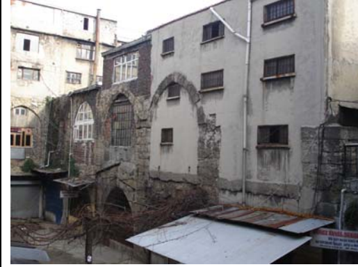
3. avlu güney cephesi
