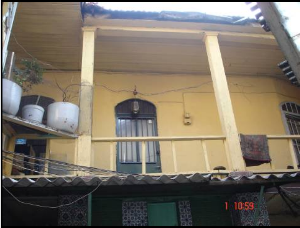
Fotoğraf 4.5 Camili Han iç cephesi (ahşap kolon ve döşemeleri) (K: karışık yapım tekniği)
