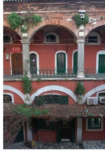
Kuzey cephesi revak modülü
