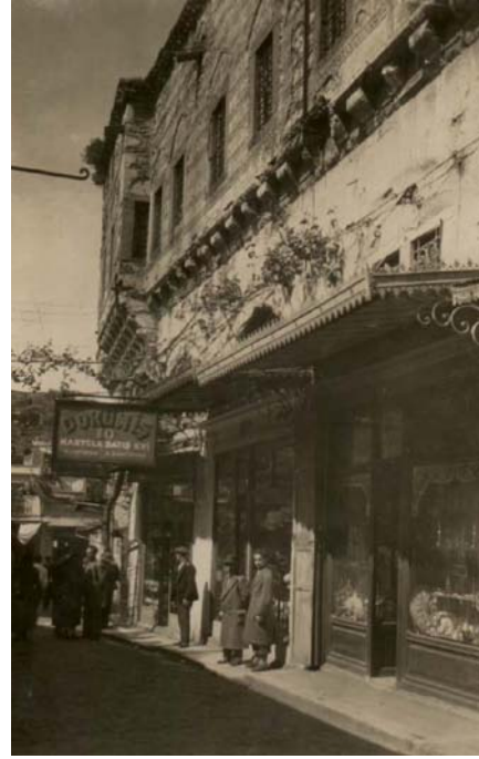
Çuhacıhan sok. giriş cephesi
