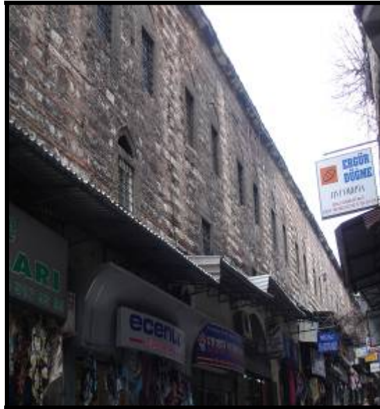
Fotoğraf 6.19 Yağmur suyu ve kirli havanın neden olduğu kirlenme
