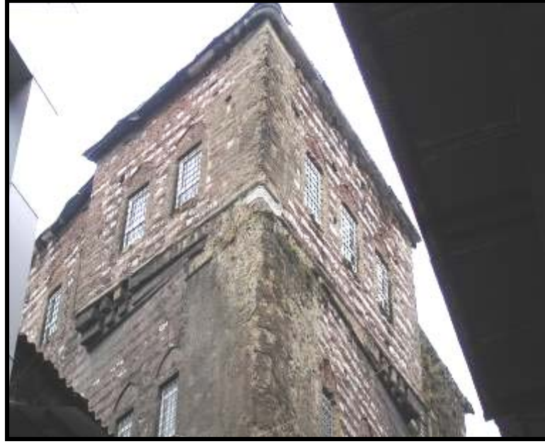
Fotoğraf 5.23 Köşenin taş malzeme ile oluşturulması. Büyük Yeni Han Çakmakçılar Yokuşu köşesinin zeminden saçak altına kadar taş malzeme ile oluşturulduğu görülmektedir
