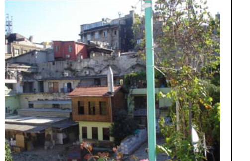
Güneybatı cephesi ve avludaki yeni yapılan mescid
