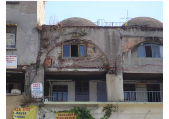
Güneydoğu cephedeki revaklar
