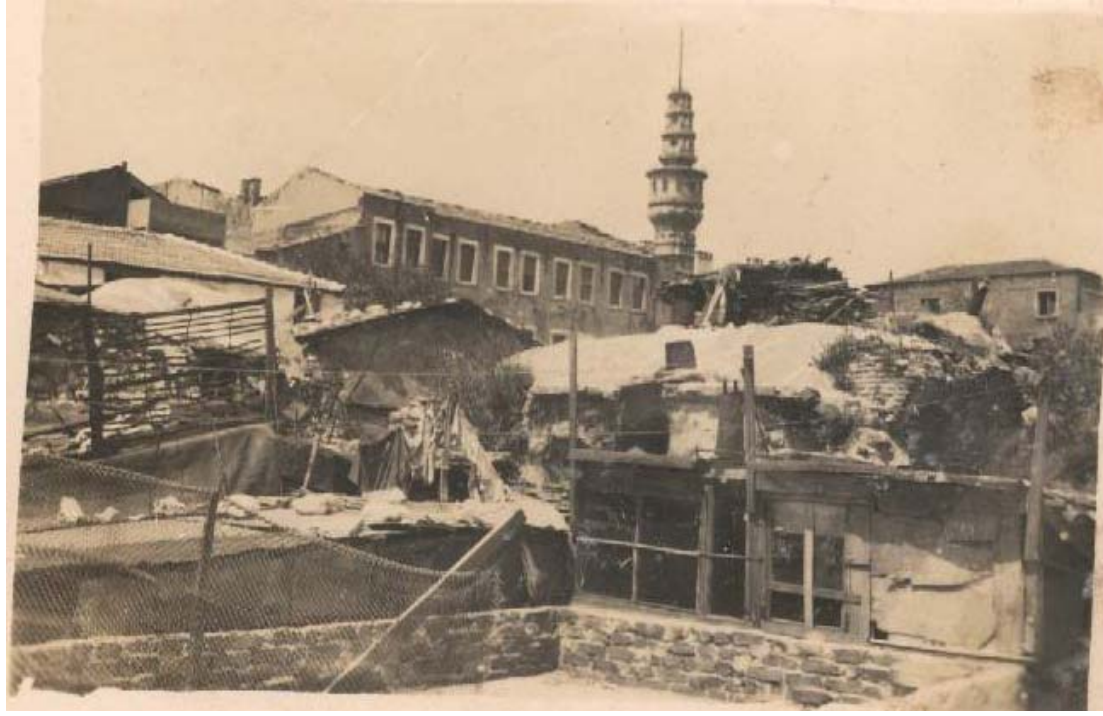
2. avlunun kuzey-batı köşesinden Beyazıt kulesi görülmektedir, 1945
