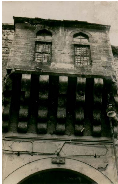
Giriş kapısı üzerindeki çıkmalı oda
