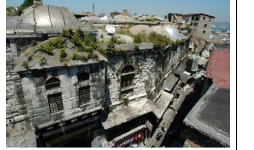
Güney (giriş) cephesi
