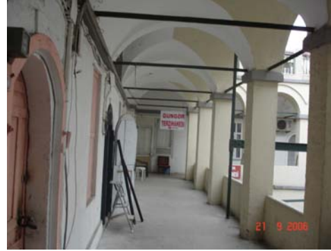
Revaklardaki metal gergi
