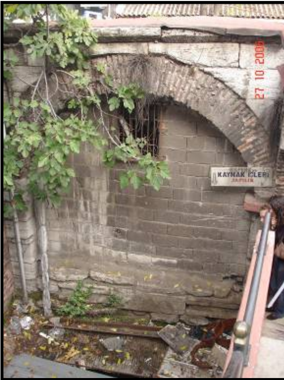
Fotoğraf Ek- 18 Üçüncü avlunun ortasındaki revak payesinin kuzey yönüne devam eden kemer ve üzerindeki kesme taş revak duvarı. Ayrıca hanın üçüncü avlusunun üçüncü katına ait kat silmesi de görülmektedir.
