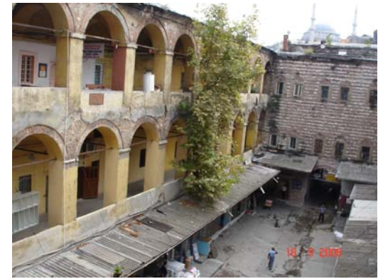
1. Avlu doğu cephesi revakalrı
