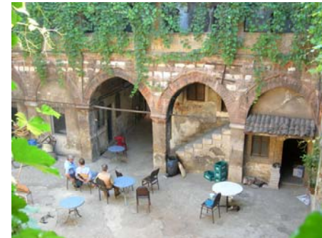
Doğu cephesindeki zemin kat revakları
