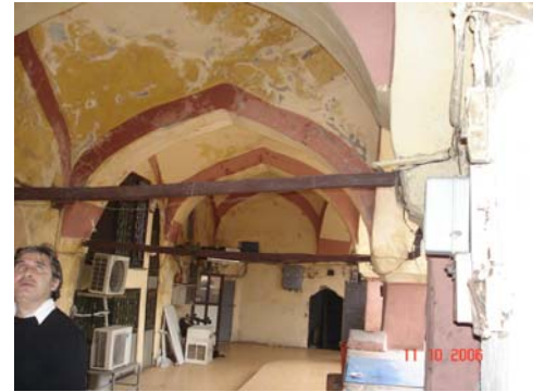
Güney cephesi 1. kat revakı
