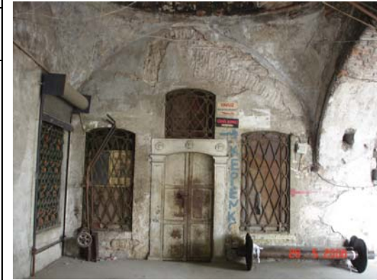
Güney-doğu cephesindeki revak modülleri
