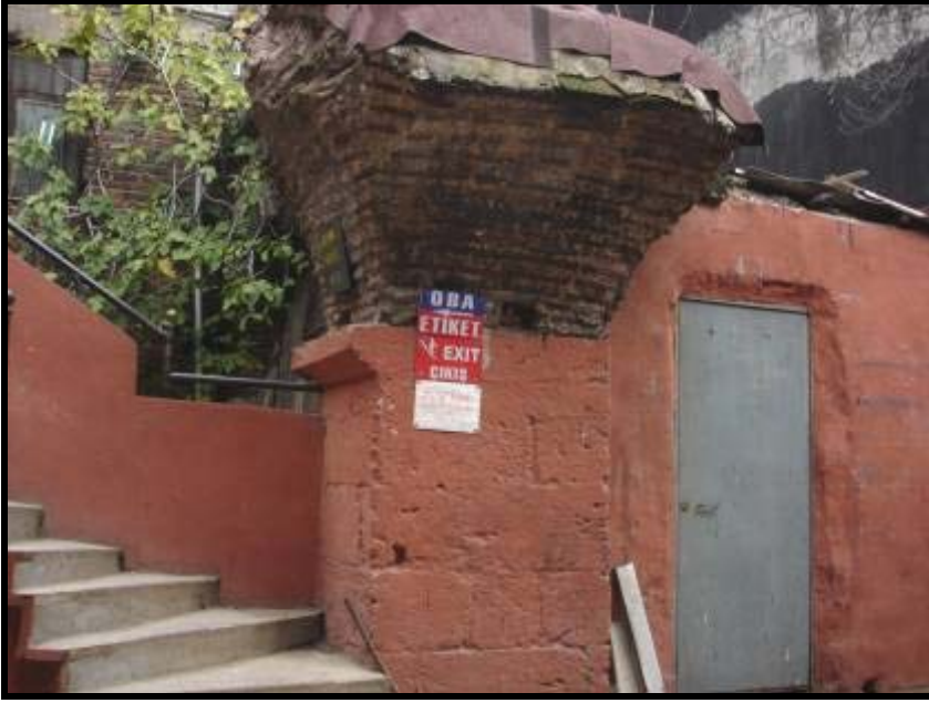
Fotoğraf Ek- 17 Üçüncü avluda özgün kalan revak payesi. Payeyi oluşturan kesme taşlar hanın diğer payelerindeki kesme taşlar ile aynı boyuttadır. 4 yöne başlayan tuğla kemer örgüsü malzeme ve boyut bakımından diğer payelerdekiler ile aynıdır. 1. kata ait olan bu revak payesi aynı zamanda zemin katta da devam etmektedir. Fotoğrafta görülen merdiven ise günümüz malzemesi ile yapılmış olup, Mühürdar Lütfüpaşa sokağına çıkan kata ulaşmak için yapılmıştır.
