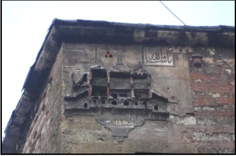
Büyük Yeni Han (18.yy.) (Batı cephesindeki kuş evi)
