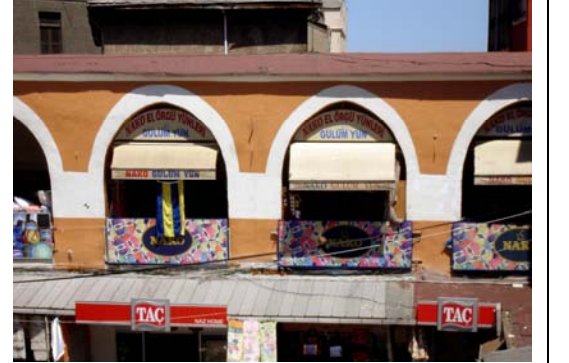
Güney yönü 1. kat revakları
