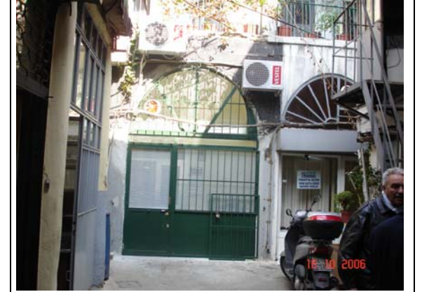
Zemin kat kuzey cephesi
