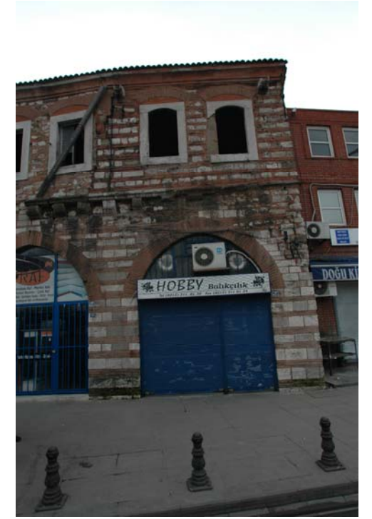
Batı cephesindeki 2 adet pencere modülü
