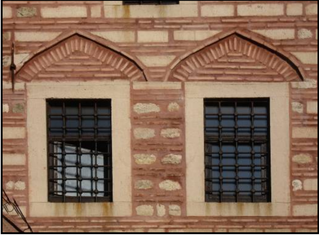
Çuhacı Han (18.yy.) (Onarım sonrası durumu)
