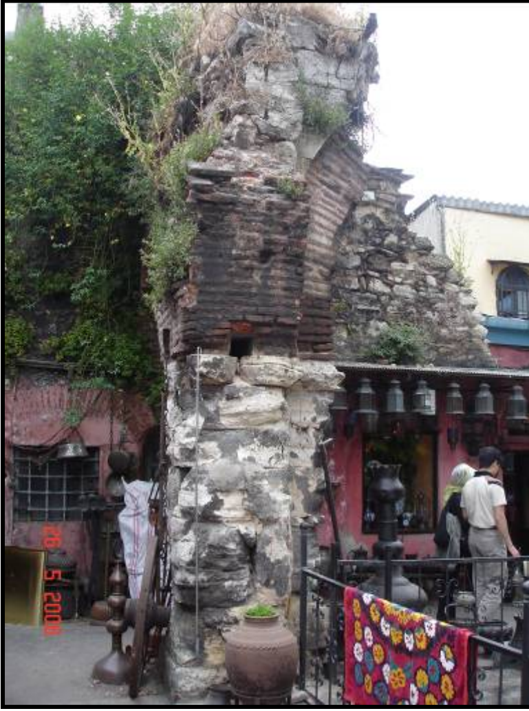
Fotoğraf Ek- 13 Kuzeydoğu köşesindeki revak detayı
