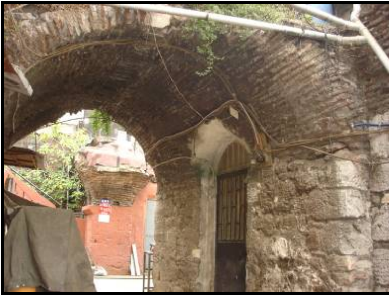
Fotoğraf Ek- 14 Birinci katta bulunan ikinci avludan üçüncü avluya olan beşik tonozlu geçit. Geçit duvarında görülen kapı oda duvarında sonradan açılmış kapısıdır
