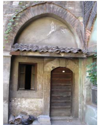
Doğu cephesindeki kapatılmış köşe revakı
