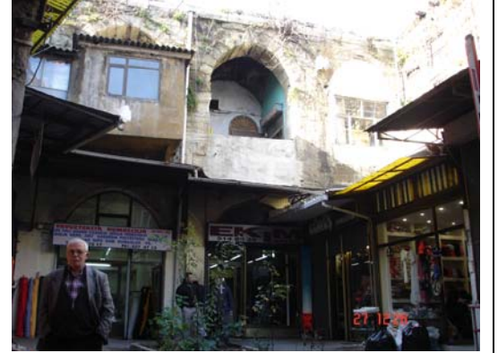
Kuzey-doğu cephesinden 2 adet revak modülü
