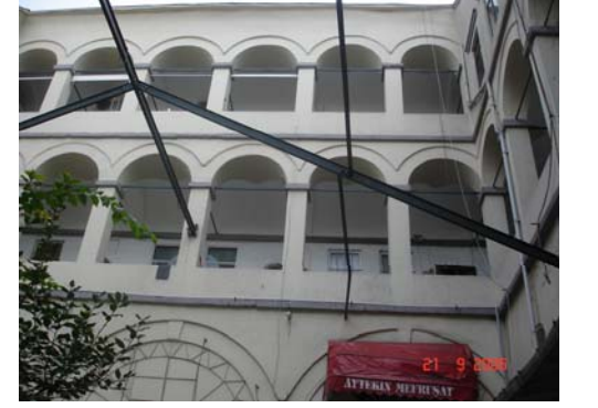
Doğu cephesi 1. ve 2. kat revakları
