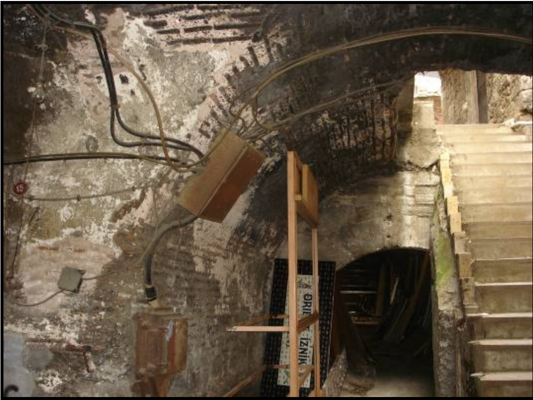
Fotoğraf Ek- 22 Üçüncü avlu girişi kemeri diğer kemerlerden daha alçaktır ve kesme taştan yapılmıştır. Geçiti oluşturan beşik tonozun bir kısmı yıkılarak günümüz malzemesi ile merdiven yapılmıştır. Bu merdivenin yeri ve kendisi özgün değildir. Günümüzde üçüncü avlunun üzeri açıktır ve demir atölyesi olarak kullanılmaktadır.
