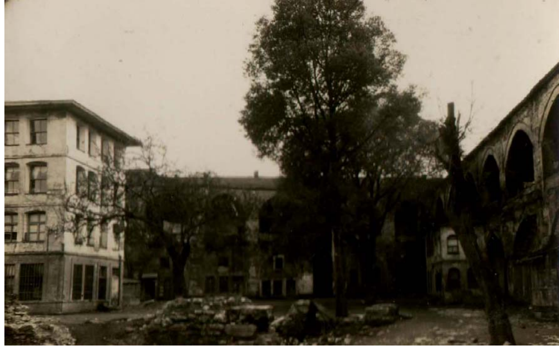
2. avluda doğu cephesinde görülen yapı, Pervititch haritasında (1940) otel olarak görülmektedir. Günümüzde otelin yerinde betonarme yapı bulunmaktadır.
