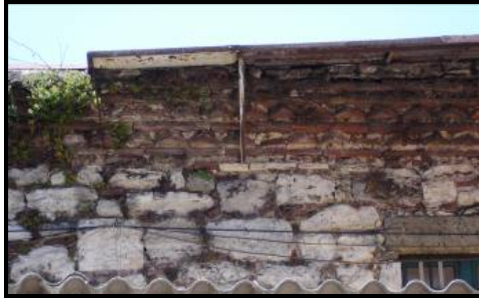
Kürkcü Han (15. yy.) kirpi saçak kat silmesi altında kalan duvar örgüsü
