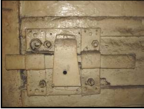
Çuhacı Han oda kapısına ait kilit detayı, kilitin arka ve ön görünüşü (Kapı bütünü Fotoğraf 5.28'de görülebilir)
