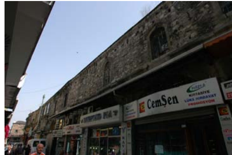
Güneybatı dış cephe
