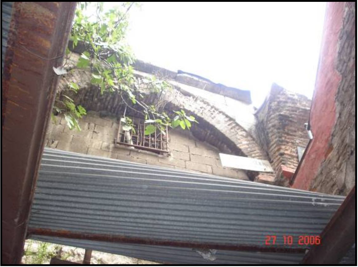
Fotoğraf Ek- 23 Üçüncü avlunun zemininden yukarıya bakınca 1. kattaki revak payesi ve kemeri görülebilmektedir.
