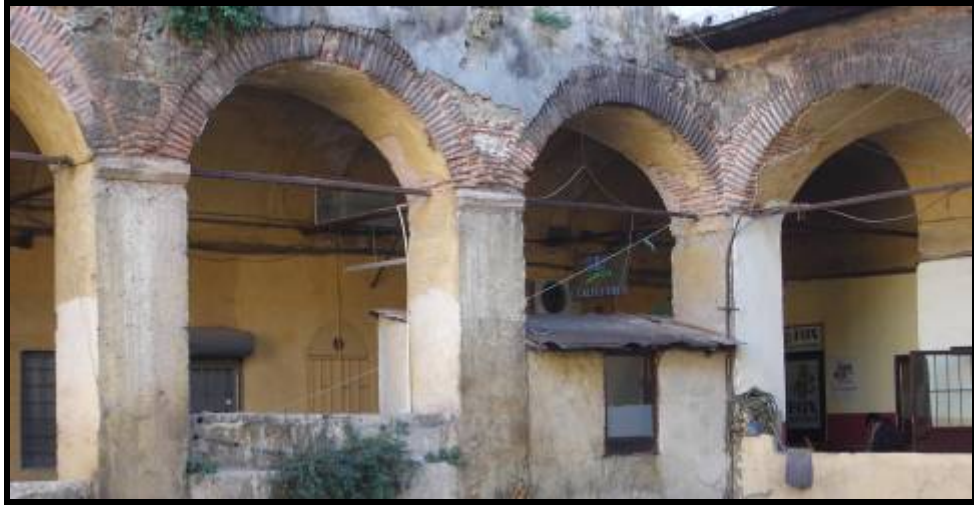
Fotoğraf 5.18 Düşey yükün yatay yönde açılması istemini durdurmak için kullanılan gergi demirleri (Büyük Yeni Han)
