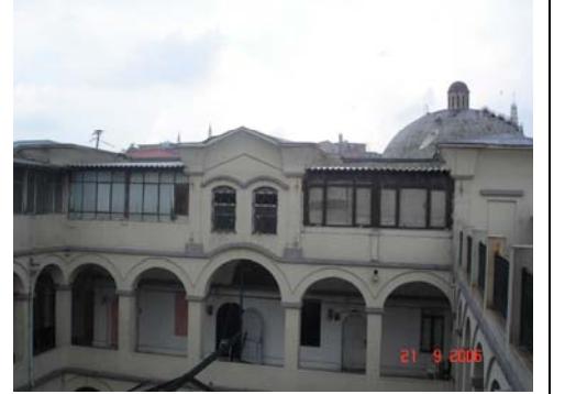
Çatı katındaki ek kat
