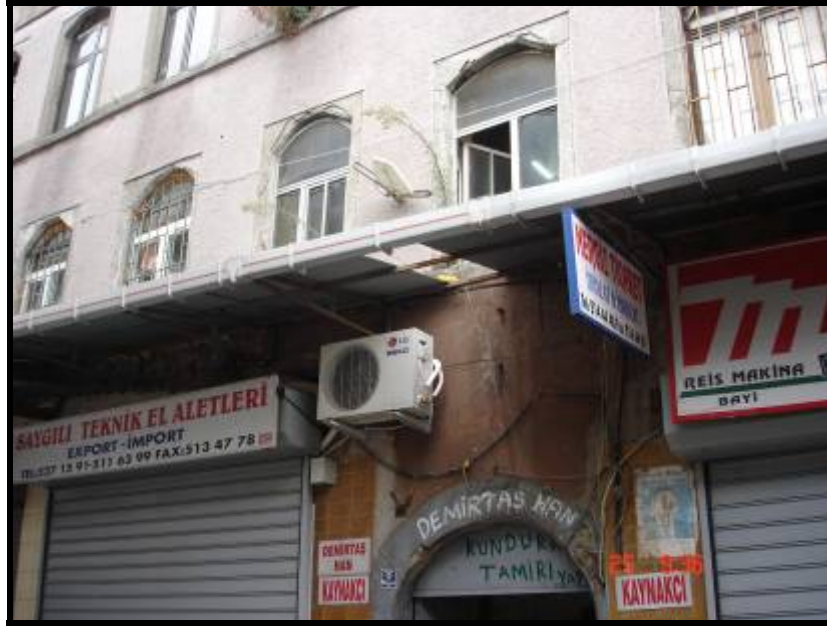
Fotoğraf 4.6 Demirtaş Han dış cephesi (kagir duvar) (K: karışık yapım tekniği)
