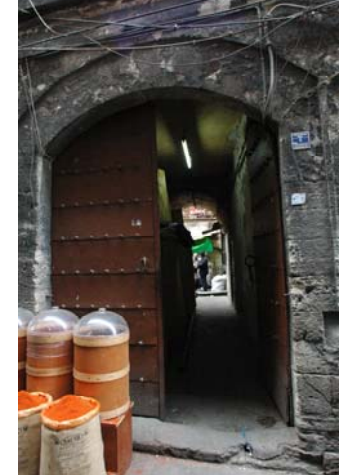
Zemin kat (avlu kotu) girişi
