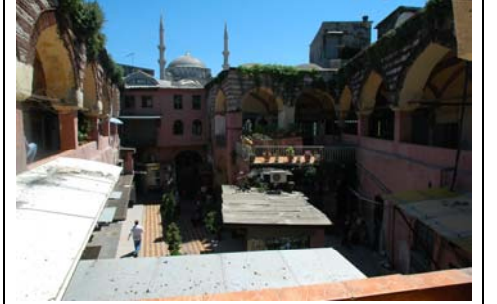
Han girişin sağ tarafındaki merdiven
