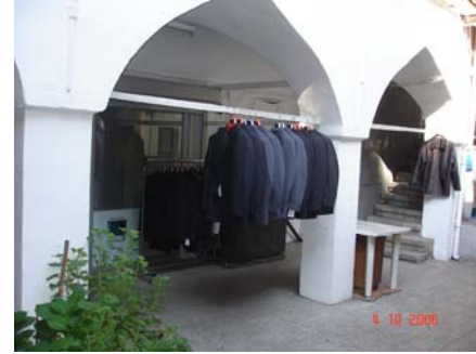
Batı cephesi zemin kat revakları
