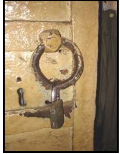
Çuhacı Han oda kapısına ait kilit detayı, kilitin arka ve ön görünüşü (Kapı bütünü Fotoğraf 5.28'de görülebilir)
