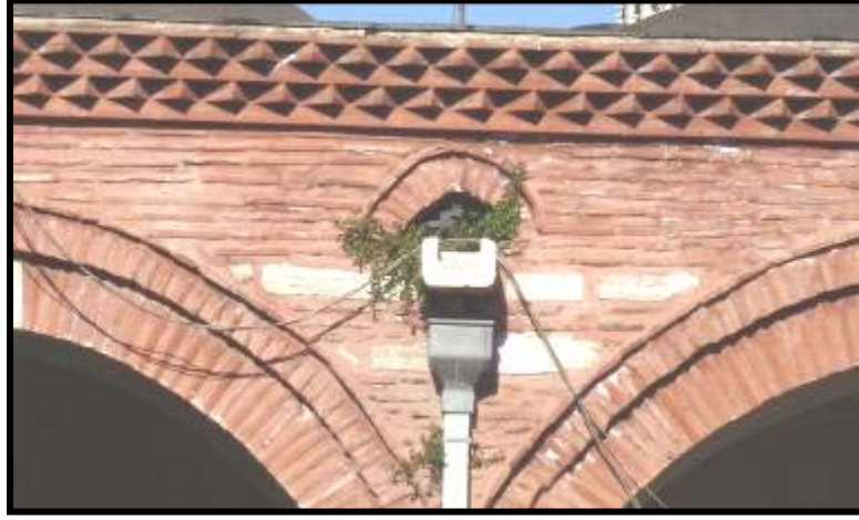
Çuhacı Han (18.yy.) (Restorasyon sonrasındaki kirpi saçak ve çörten)
