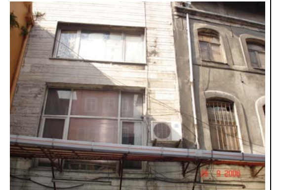
Kürkçü han 2.avlu batı cephesindeki yeni yapılar
