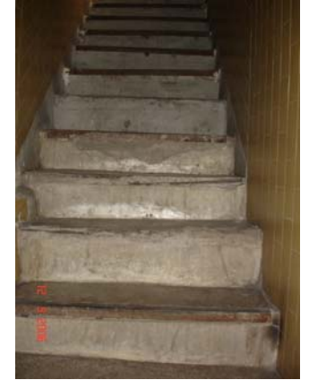
Zemin kattaki merdiven
