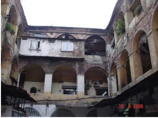
2. avluda 3. kat revakına yapılan ek
