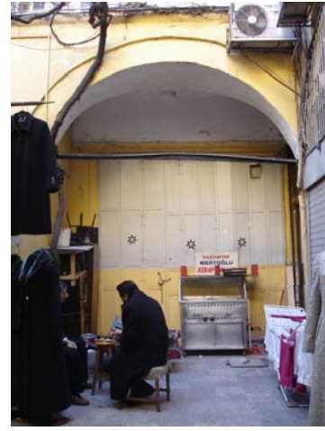
Zemin kat revakları
