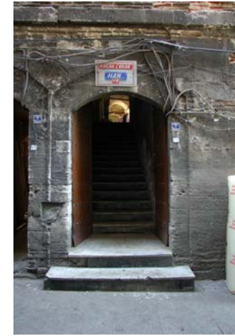
Güneybatı cephesinden 1. kata olan giriş kapısı
