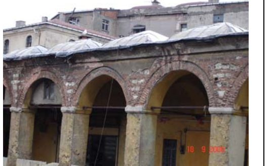
Saçak silmesi ve üst örtü
