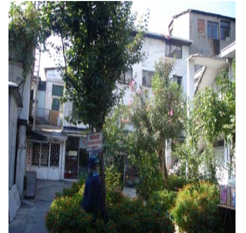
2. avlu güney cephesi
