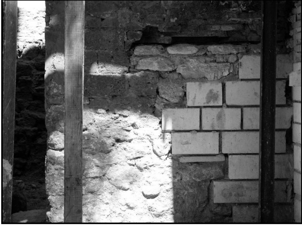
5.37 İstanbul Kara Surlarında yapılan restorasyon çalışmalarında kullanılan detaylar (Aydemir Arşivi)
