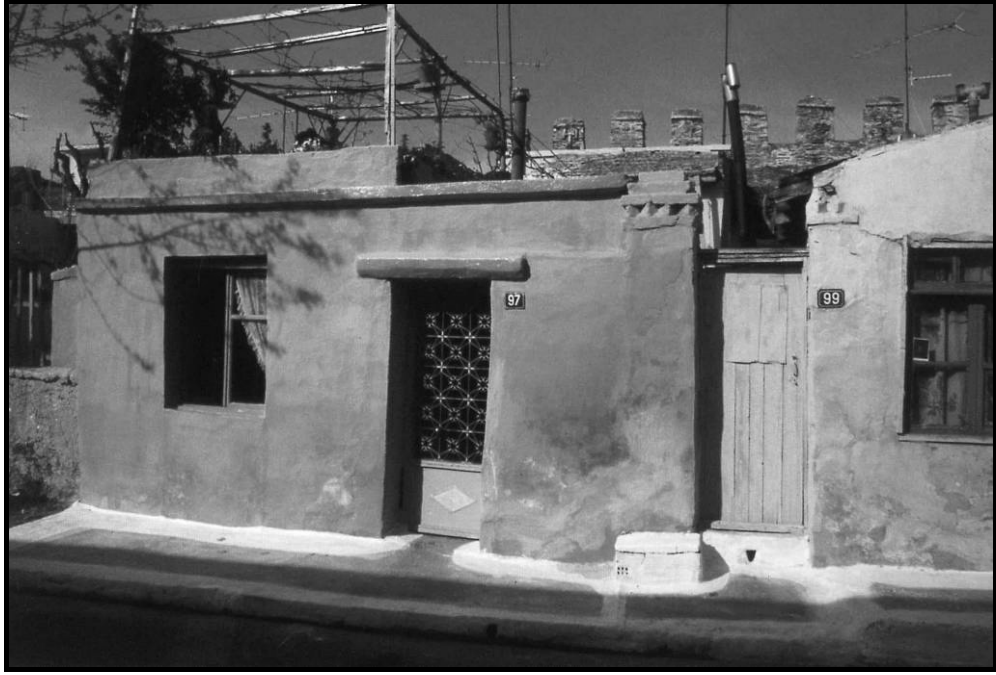
Şekil 3.20 Sur içinde mübadillere ait konutlar (Yerolympos Arşivi)
