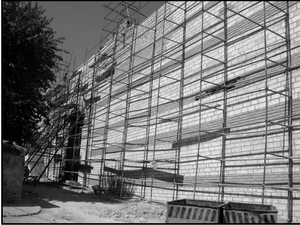
5.36 Tekfur Sarayı çevresinde surlarda yapılan restorasyon uygulamaları, 2003 (Aydemir Arşivi)
