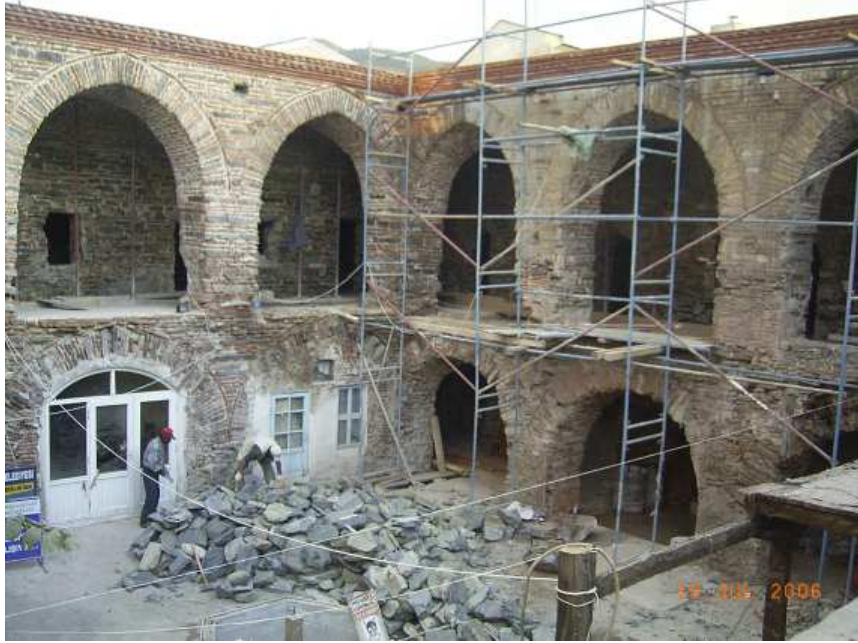
Şekil 4.205 Tuz Han restorasyon sonrası durumu, 2006.
