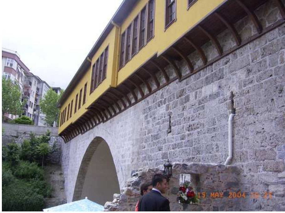
Şekil 4.27 Irgandı Köprüsü'nün görünüşü, 2004.
