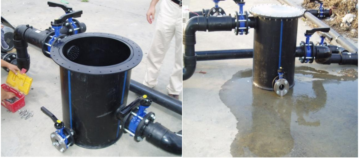
Şekil 5.6 Kondens suyu tutucusu resmi ve vakumla gelen suyun tahliyesi.
