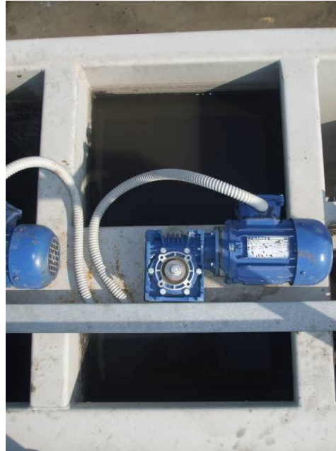
Şekil 3.6 Pilot ölçekli atıksu arıtma tesisi ızgara yapısı
