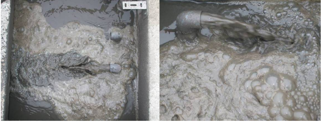
Şekil 3.10 Pilot ölçekli atıksu arıtma tesisi nitrifikasyon ve denitrifikasyon havuzları arası geri devir sistemleri
