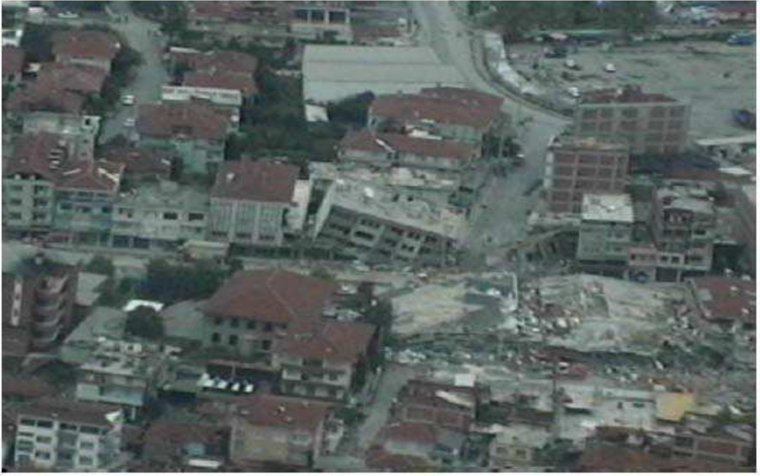
Şekil 1.6 Adapazarı'nda farklı zemin koşullarının bina göçmeleri üzerindeki etkileri (Ansal vd., 1999)
