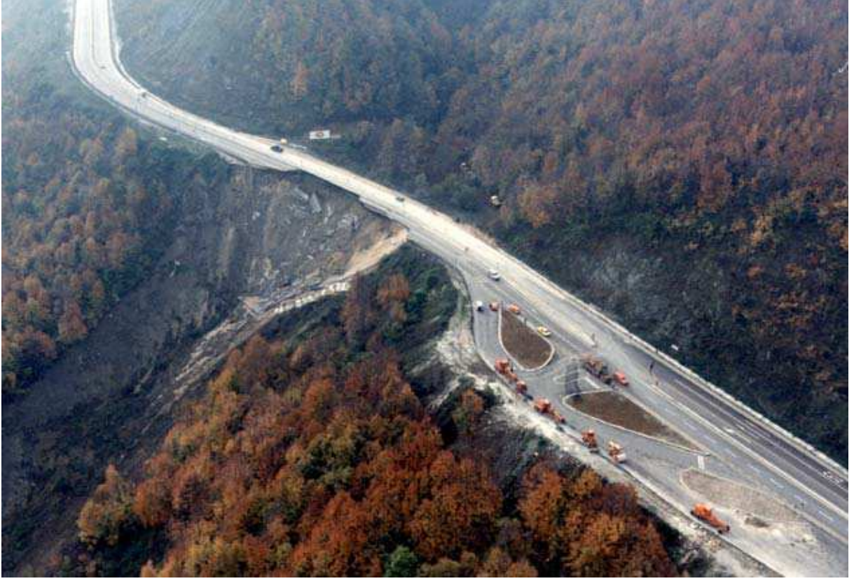
Şekil 1.2 17 Ağustos 1999 Depremi sonrasında Bolu Dağı otoyolunda gözlenen yamaç kayması (Boğaziçi Üniversitesi Sismoloji bölümünden alınmıştır)
