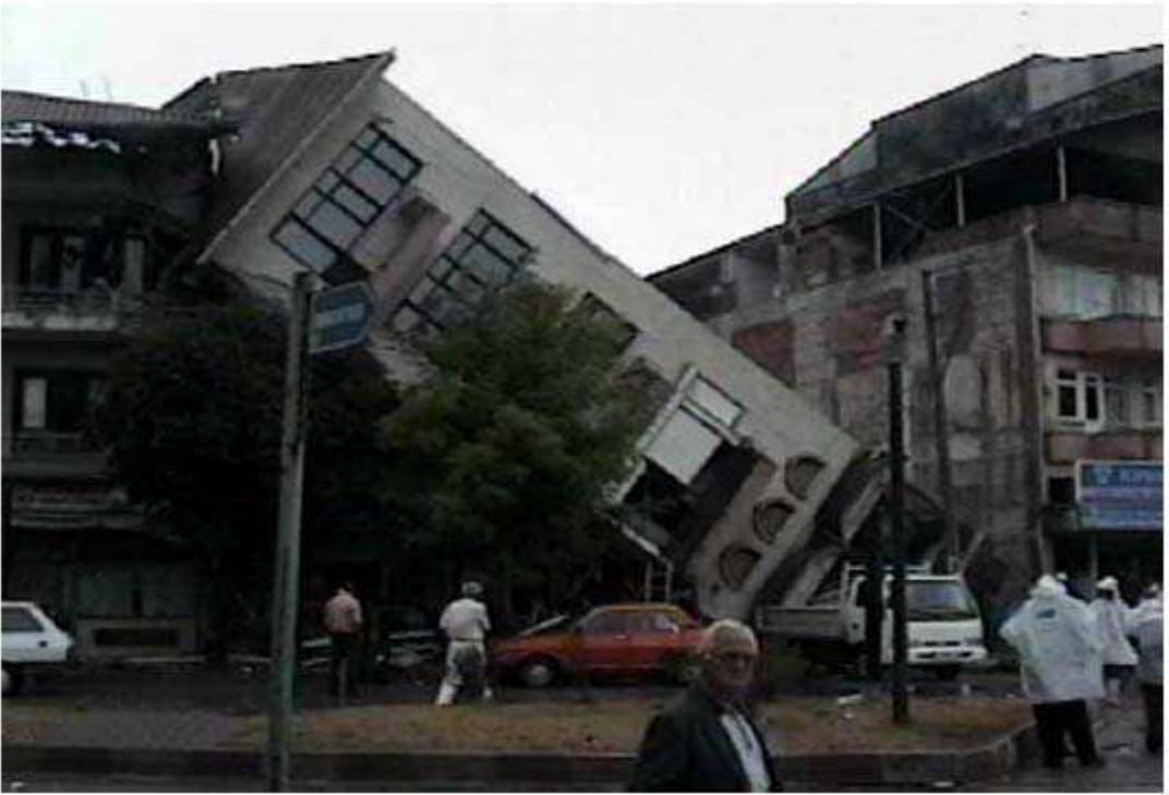
Şekil 1.5 Bina temel derinliğinin yetersiz olması dolayısıyla binanın yan yatması (Ansal vd.,1999)
