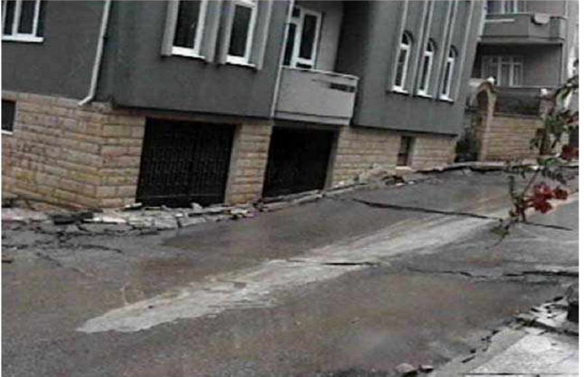
Şekil 1.3 Adapazarı'nda farklı oturmalarından dolayı yan yatmış bir bina (Ansal vd., 1999)
