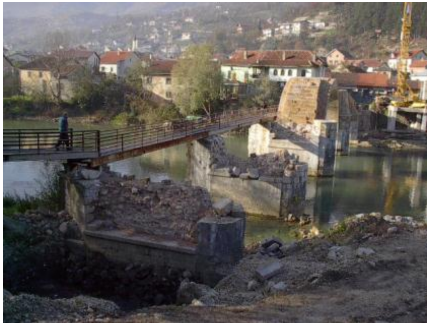
Şekil 5.9 Konjiç köprüsünün restorasyon öncesi durumu [107]
