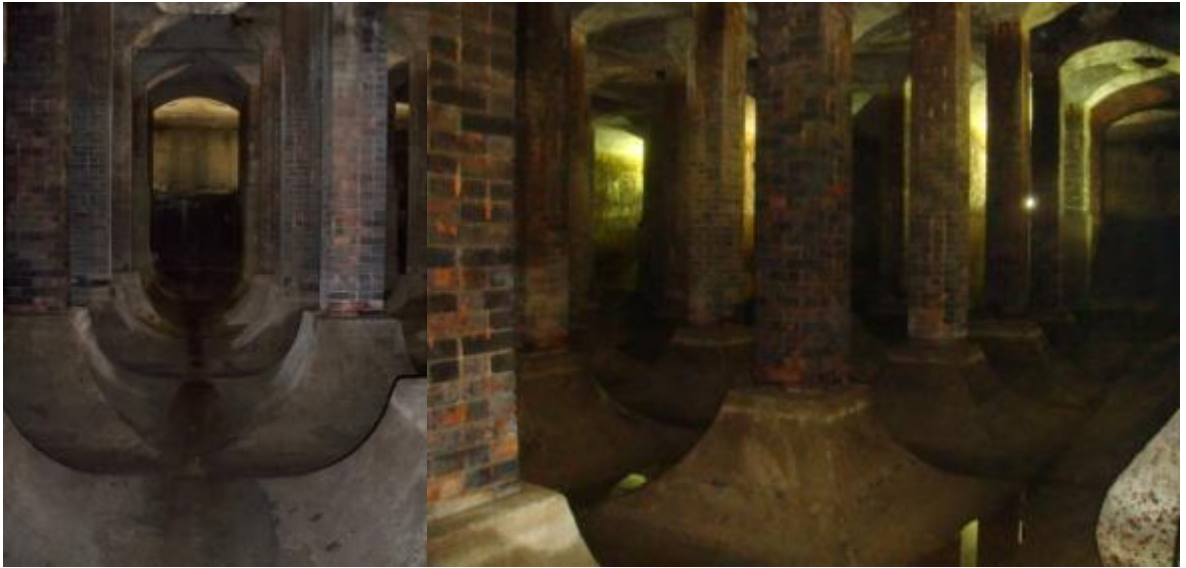
Şekil 5.17 Edirnekapı sarnıcındaki ters tonoz temeller[114]
