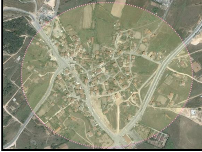
Şekil 3.15 Tepeören mahallesi merkez konut dokusu
