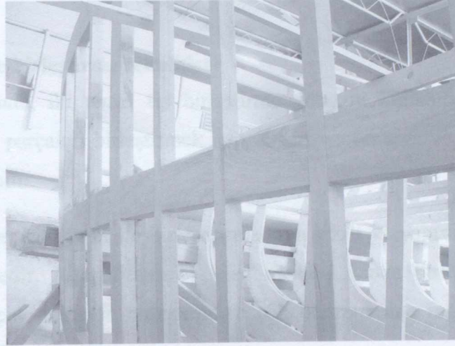
Şekil 8.11 Kıç ayna stringerleri ve dinlenme iç desteği
