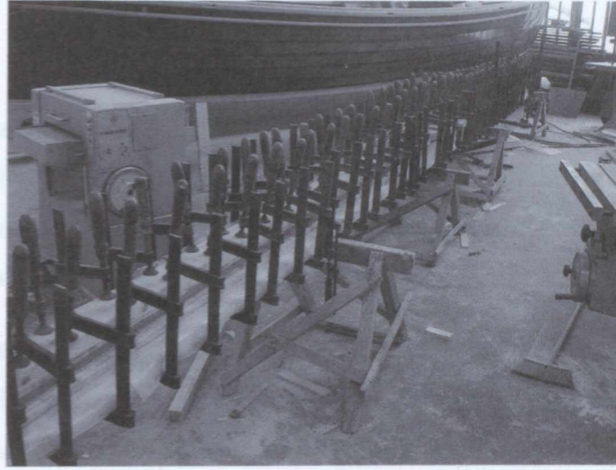
Şekil 8.17 Omurga laminasyonunun yapıştırılması
