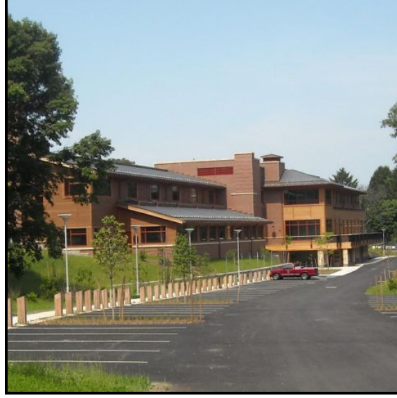
Şekil 5.4 Weld Hill Yönetim Binası [46]
