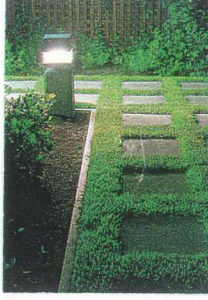
Resim 13: Alçak direkli alan aydınlatma aygıtı ile yapılan yaya yolu aydınlatması (Kaynak: W.H.W. WILSON, 1984, Outdoor Lighting).
