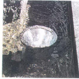
Resim 70: Islak yere uygun su aydınlatma aygıtı örneği
