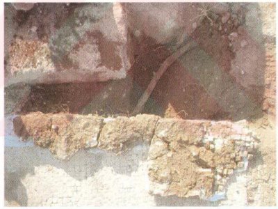
Fig. 5.4 Harç katmanları arasında bulunan ağaç kökünün uzaklaştırılması. Ksantos.
