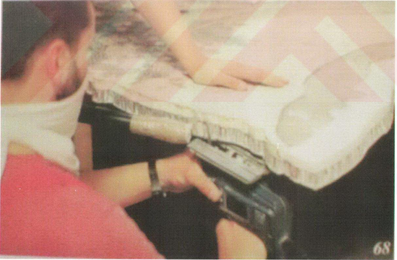
Fig. 5.43 Kireç harcı ile Aerolam paneli alınan İstanbul Büyük Saray Mozaïği'nin restorasyon çalışmasından bir görünüm. Aerolamın birleşim yerlerinin düzeltilmesine dikkat ediniz.
