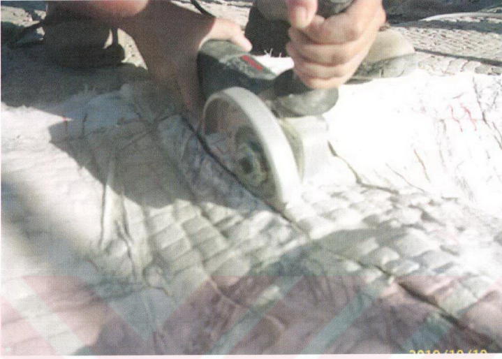
Fig. 5.31 Büyük boy tessera ve geniş derzlere sahip bir mozaikte büyük çaplı diskin kullanımı. Ancak hasarı azaltmak bakımından küçük çaplı aletlerin kullanımı daha güvenlidir.
