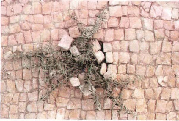
Fig. 4.9 Tesseraların dağılmasına neden olan bitki istilası.
