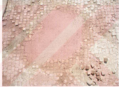
Fig. 5.16 Blokaj görevi gören taş, tuğla vb. moloz üzerine dolgu niteliğinde kireç harcı uygulaması. Tuğla tozu ihtiva eden kireç harcının ıslakken sahip olduğu canlı renk zamanla solarak belirginliğini kaybeder.
