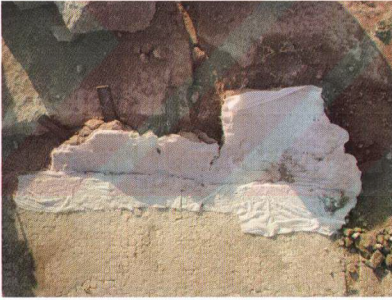
Fig. 5.4 Harç katmanları arasında bulunan ağaç kökünün uzaklaştırılması. Ksantos.
