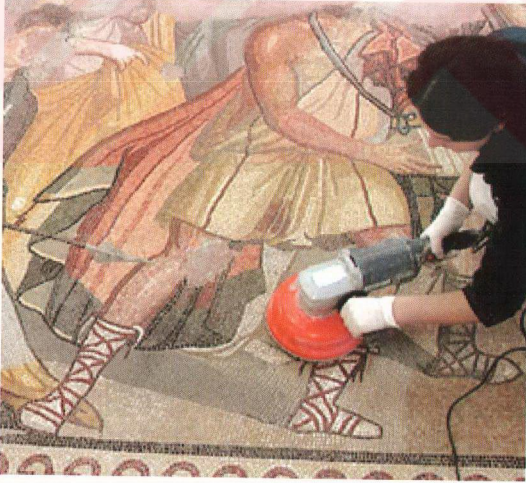
Fig. 5.3 Sağlamlaştırılmış mozaiklere el taşlama aletine takılan yumuşak fırçalarla yapılan nihai temizlik.
