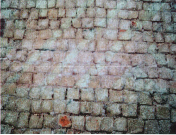
Fig. 4.6 Tesselatuma meydana gelen tuz kristalleşmesi (çipeklenme).
