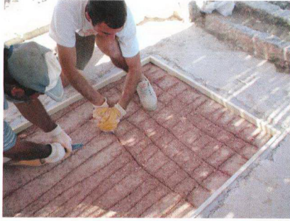
Fig. 5.47 Blokaj (statumen) ve kaba harç (rudus) tabakalarının hazırlanması. Letoon Tapınağı.
