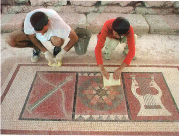
Fig. 5.49 İnsitu yerleştirilen mozaik.
