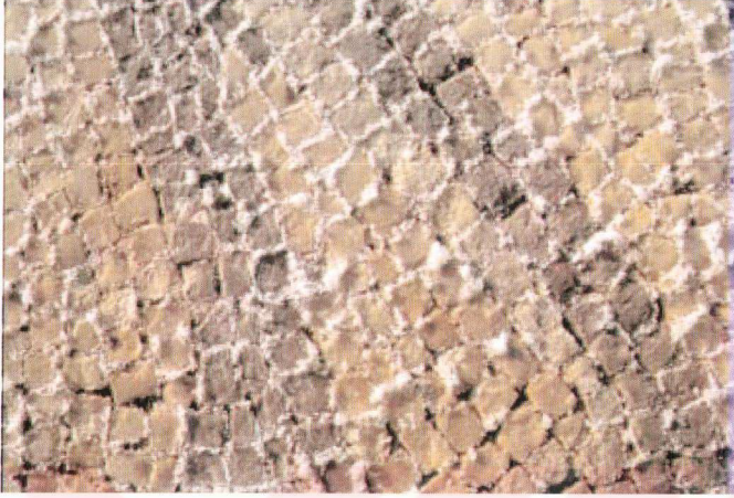
Fig. 4.7 Tesselatımda meydana gelen tuz kristalleşmesi (çiçeklenme).
