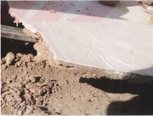
Fig. 5.21 Mozağin metal aletlerle ayrılması.
