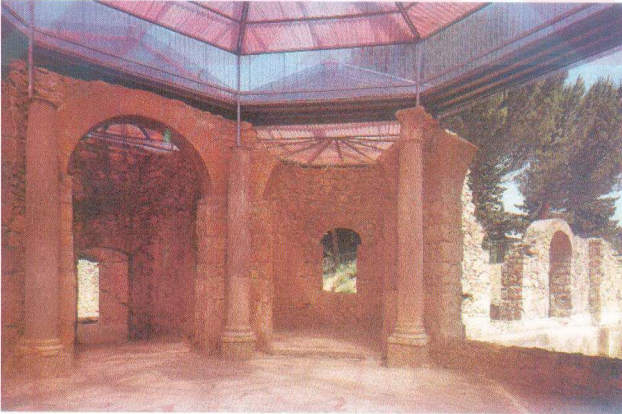
Fig. 5.5 Kalıcı çatı. Sicilya'dan bir örnek.
