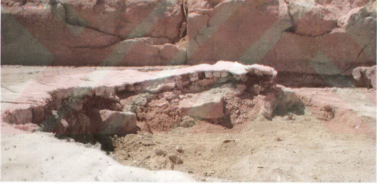
Fig. 4.5 Dışbükey deformasyon. Geçici taşıyıcı bez uygulanarak bir kısmı kaldırılmış mozağin geri kalan kısmında bulunan dışbükey deformasyon görülmekte. Ksantos.
