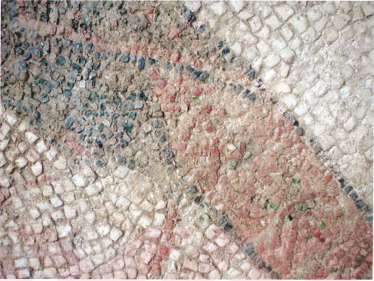
Detay 1 Atmosferdeki reaktif gazların tesseralarda meydana getirdiği değişim.
