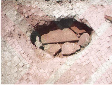
Fig. 5.16 Blokaj görevi gören taş, tuğla vb. moloz üzerine dolgu niteliğinde kireç harcı uygulaması. Tuğla tozu ihtiva eden kireç harcının ıslakken sahip olduğu canlı renk zamanla solarak belirginliğini kaybeder.
