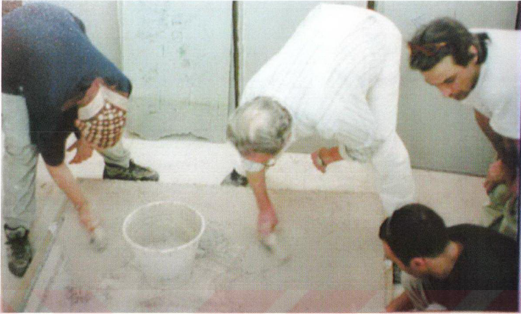
Fig. 5.41 Tessellatumun taze harç yatağına yerleştirilmesinden önce arkadan ince harçla sıvanması. CCA atölyesi, Gaziantep Müzesi.
