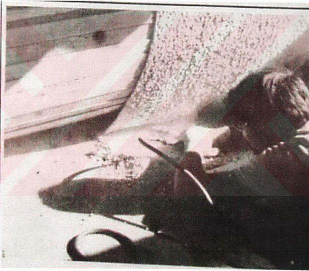
Fig. 5.34 Küçük pinomatik alet kullanarak tessellatumun harçtan ayrılması.
