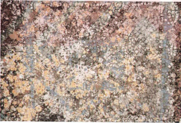
Fig. 4.11 Mikroorganizma istilasına uğramış bir taban mozaïi. Biyolojik filmler karışık renklerde olabildiği gibi siyah, kahverengi, yeşil gibi tek renge de sahip olabilmektedirler.
