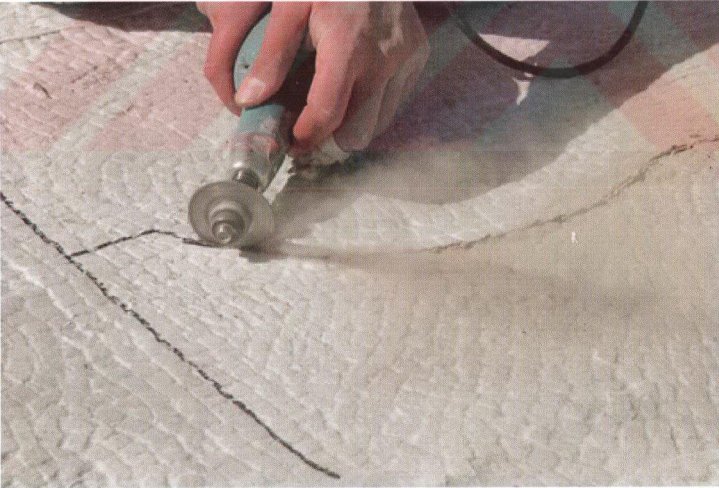
Fig. 5.28 İnce bez ile sabitlenen tessellatumun motive zarar vermeyecek şekilde dairesel bir hat izlenerek kesilmesi.
