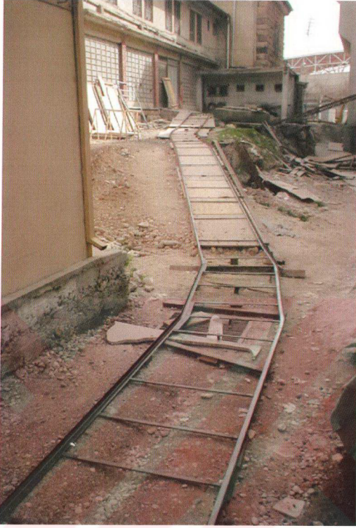
Fig. 5.61 Depo ve restorasyon atölyesi arasında kurulan raylı sistem. Gaziantep Müzesi.
