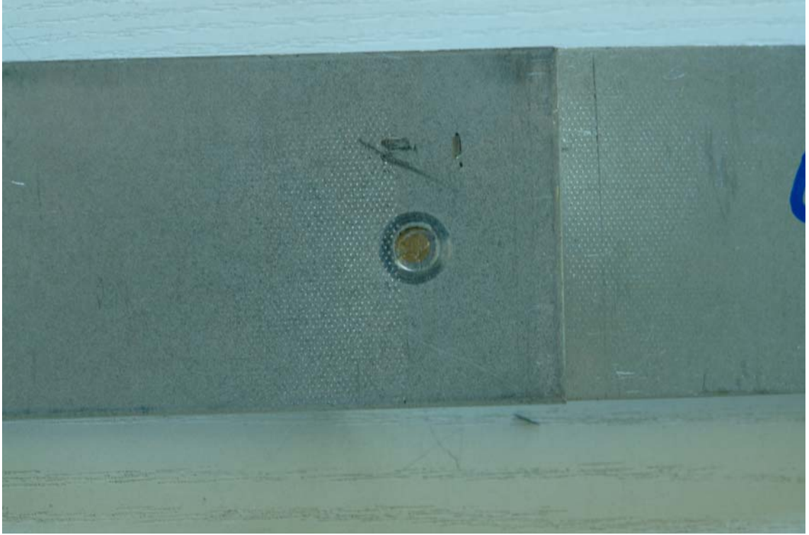
Şekil 7.5 Yük taşıyıcı kiriş ile taban panel malzemesinin nokta kaynağı gerçek görüntüsü.
