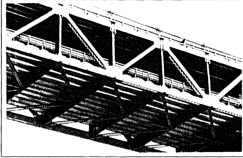
Şekil 3.72 San Fransisko-Oakland Körfezi Köprüsünün rijitlik kafesi.
