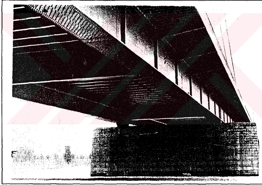
Şekil 3.60 Theodor Heuss Köprüsünün rijitlik kirişinin alttan görünüşü.
