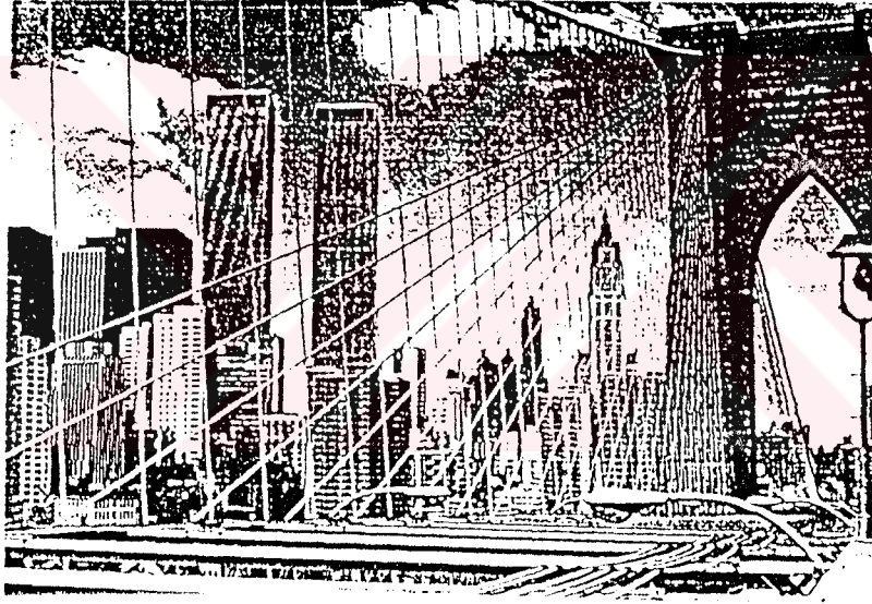
Şekil 1.2 Brooklyn Köprüsünde köprü tabliyesinden kablo sisteminin görünüşü.
