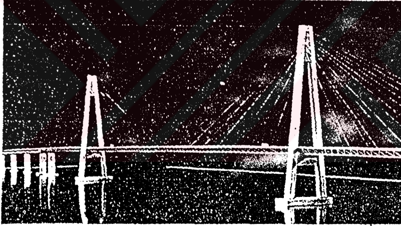
Şekil 1.57 Great Belt Köprüsü için 780 m. ana açıklıklı eğik askılı köprü projesi.
