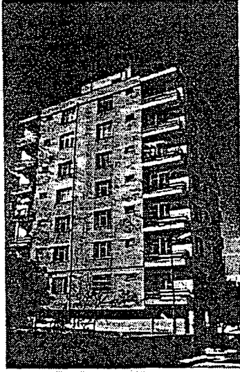
a) Ceyhan'da orta hasarlı bina
