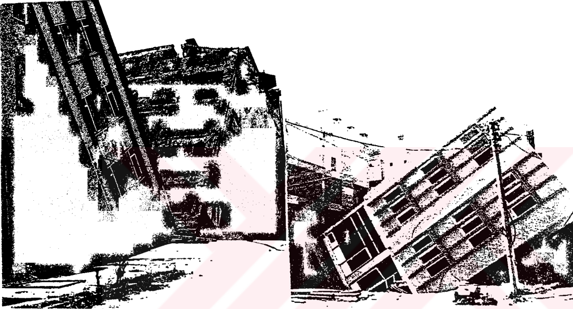
Şekil 3.1 Bolu ve Adapazarı depremlerinde sıvılaşma nedeni ile yana yatan binalar (Ansal vd., 1999)
