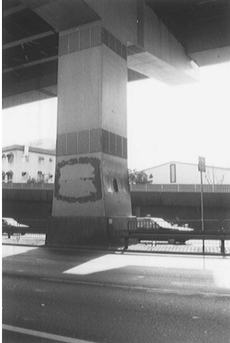
Şekil 1.2 CFT Eleman olarak tasarlanmış köprü ayağı.
