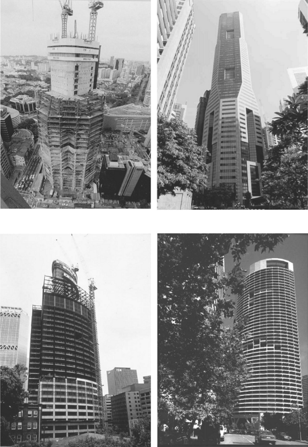
Şekil 1.1 CFT Kolonlar kullanılarak tasarlanmış çok katlı yapı.
