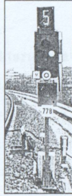
Şekil 2.34 Sinyale yerleştirilmiş hareketli kol
