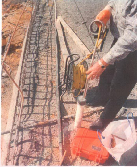
Şekil 5.17 (a) Eğim ölçerin okuma almak için borunun içine yerleştirilmesi
