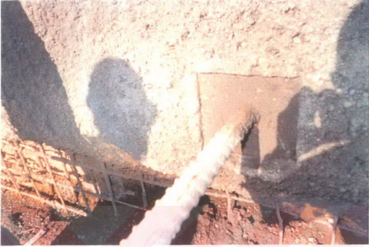
Şekil 5.17 (e) Enjeksiyonu tamamlanmış, taşıyıcı plakası yerleştirilecek olan deney çivisi
