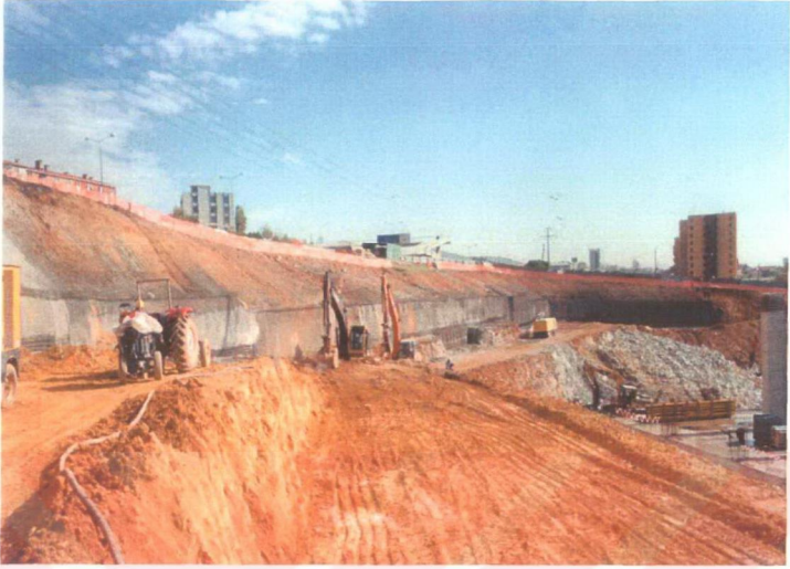
Şekil 5.17 (i) Kalıcı zemin çivili duvar inşaatının diğer aşamaları
