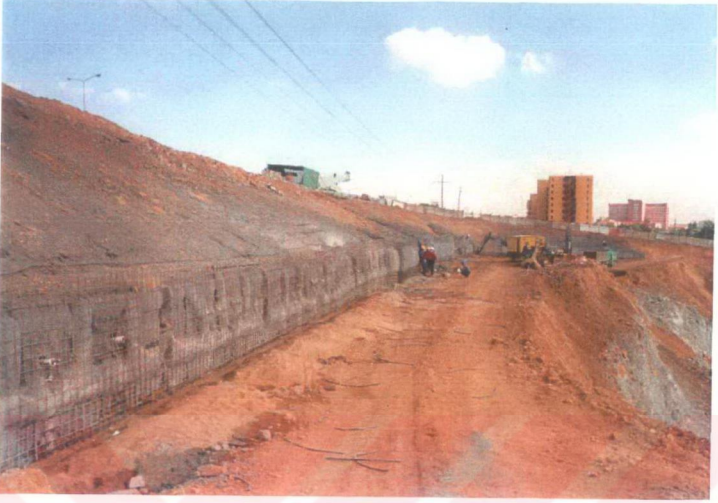
Şekil 5.17 (g) En üst aşamasının birinci kat püskürtme betonu tamamlanmış kalıcı zemin çivili duvar
