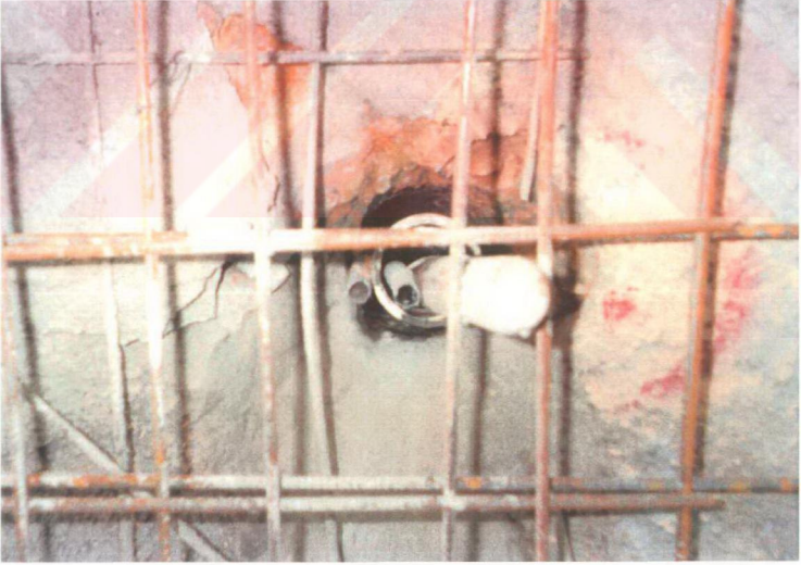
Şekil 5.17 (d) Arazide projesine uygun olarak yerleştirilmiş kalıcı zemin çivisi
