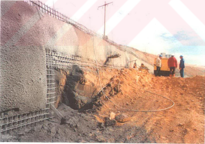
Şekil 5.17 (h) En üst aşaması tamamlanmış, bir alt aşamasının yapımına geçilmiş kalıcı zemin çivili duvar
