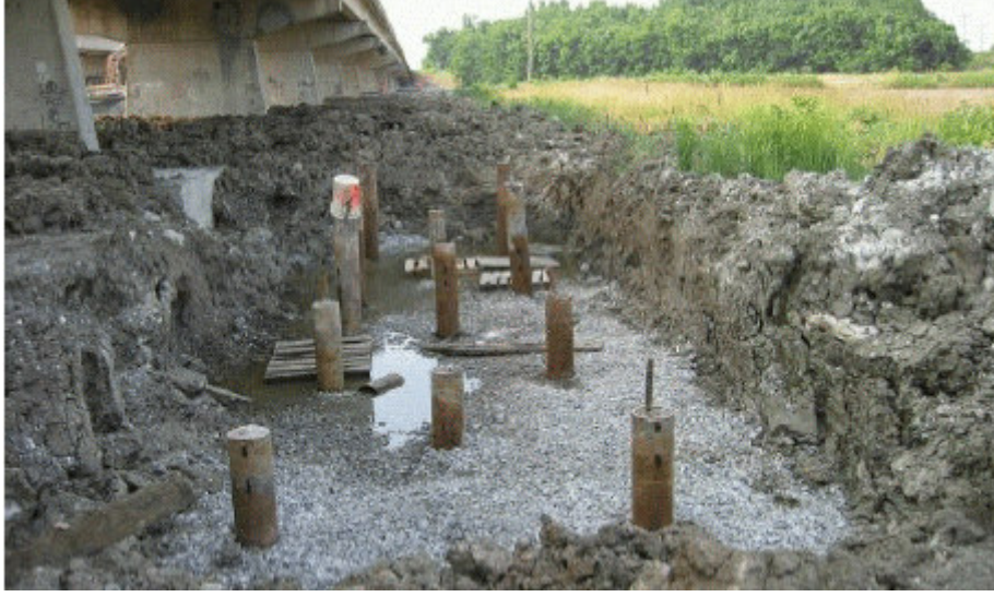
4. Şekil 4.3 – Deney kazıklarından bir görünüm
