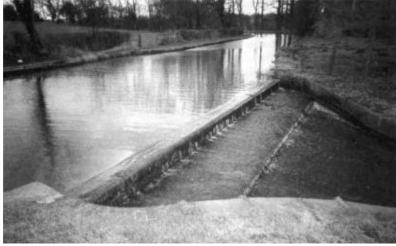
Şekil 1.7 Welford havuzu baypas (Grand Union Kanalı)(C. Bromwich, 2003)
