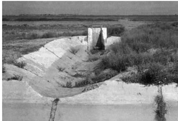
Şekil 1.8 Sulama kanalı (Kazakistan Maktaral Bölgesi)
