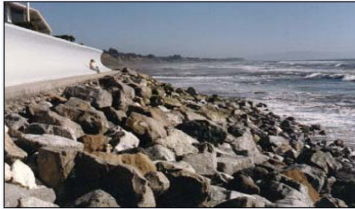
ı) Kavisli ve anroşmanlı kıyı duvarı (Via Gaviota, Aptos) [5]
