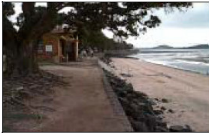
f) Eğimli ve anroşmanlı kıyı duvarı (Kohimarama) [1]
