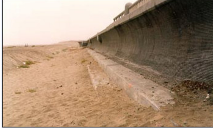
a) Kavisli kıyı duvarı (Great Highway, San Francisco, CA) [5]
