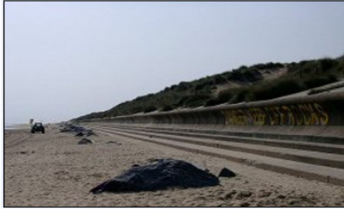
h) Basamaklı ve kavisli kıyı duvarı (Uk, 2003) [5]
