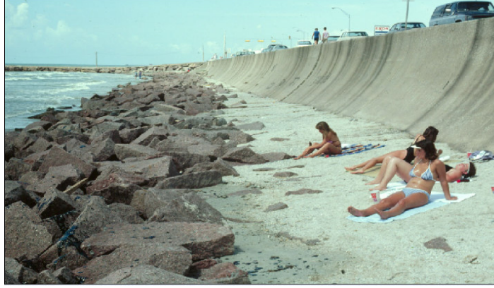
j) Kavisli ve anroşmanlı kıyı duvarı (Galv) [5]
