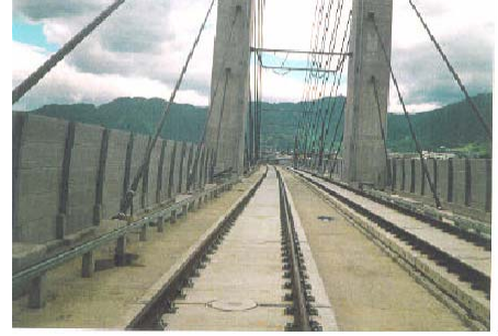
Şekil 2.9 Shinkansen prefabrik üstyapı sistemi (Erkul, 2002).
