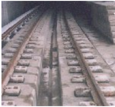
Şekil 2.5 LVT, TT içine gömülü travers mesnetli rijit üstyapı sistemi (Erkul, 2002).
