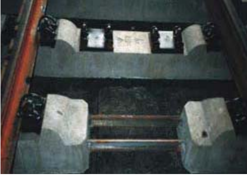
Şekil 2.6 ATD sistemi, Nant 1993 TT üzerine döşeli travers mesnetli rijit üstyapı sistemi (Erkul, 2002).
