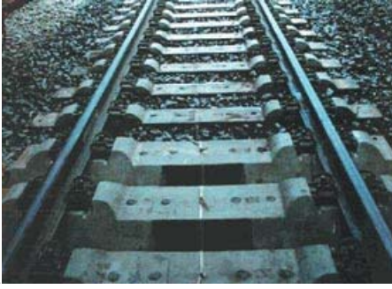
Şekil 2.7 GETRAC TT üzerine döşeli travers mesnetli rijit üstyapı sistemi (Erkul, 2002).
