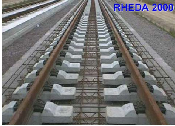
Şekil 2.3 Rheda 2000 Taşıma Tabakası (TT) içine gömülü travers mesnetli rijit üstyapı (Esveld, 2003).
