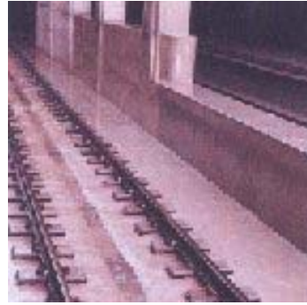
Şekil 2.5 LVT, TT içine gömülü travers mesnetli rijit üstyapı sistemi (Erkul, 2002).
