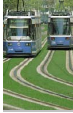
Şekil 2.8 Rasengleis monolitik rijit üstyapı sistemi (Erkul, 2002).
