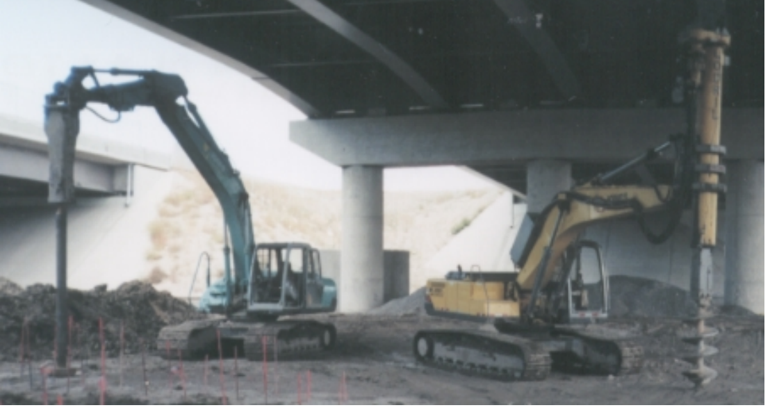
Şekil 3.2 Geopier inşa ekipmanları; özel tokmaklı kazıcı ve sondaj makinesi. (Lawton, 2004)
