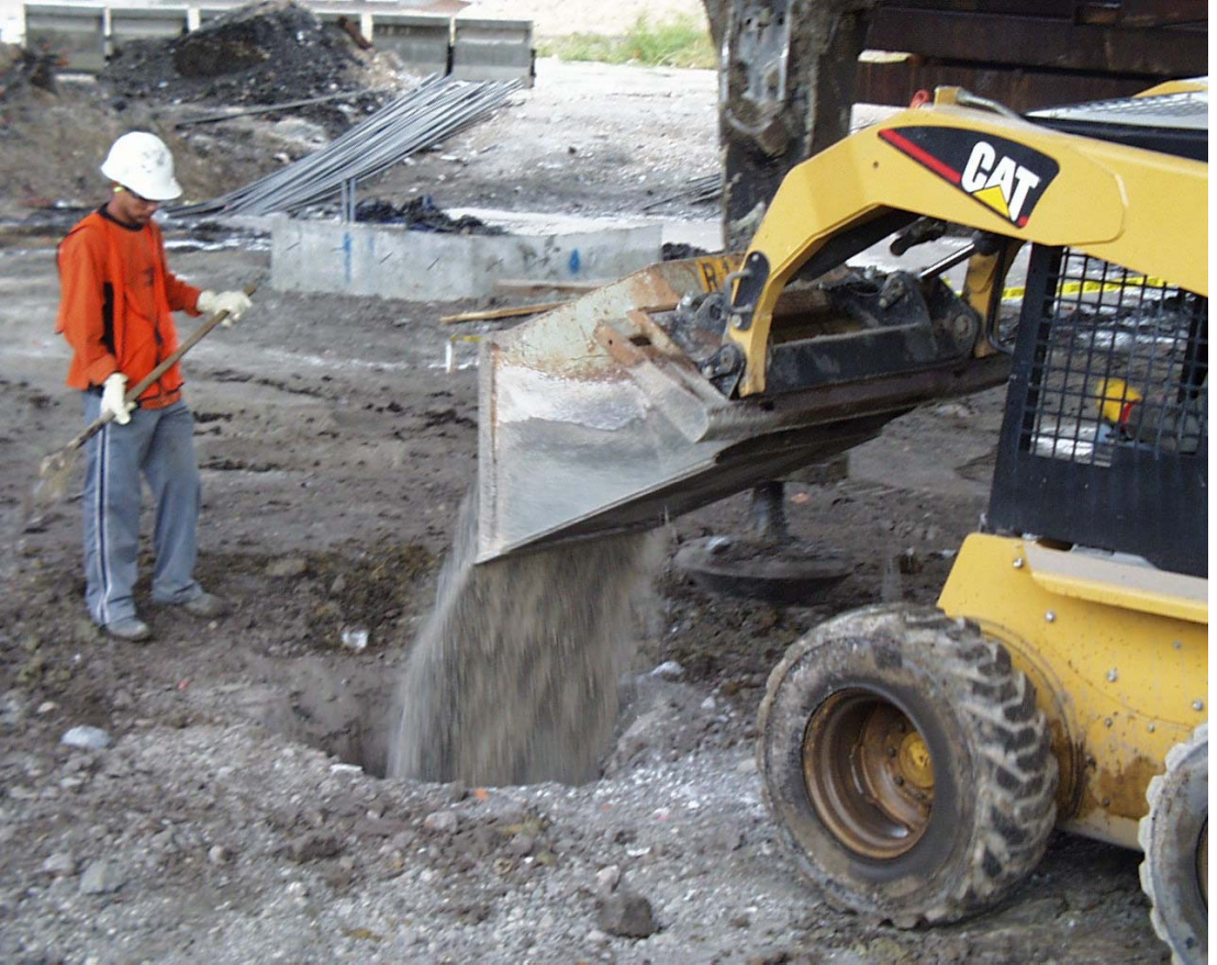
Şekil 3.3 Agreganın yerleştirilmesi.
