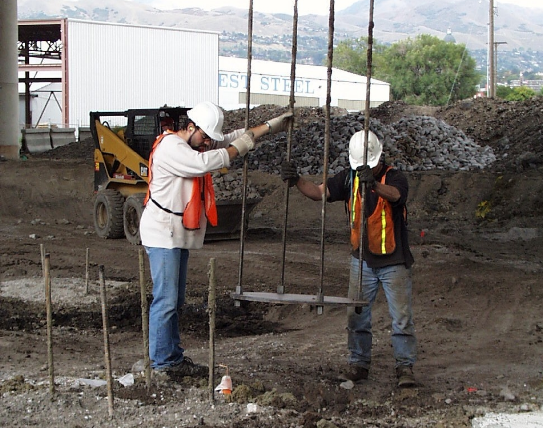
Şekil 3.5 Donatılı geopier kurulumu. (Lawton, 2004)
