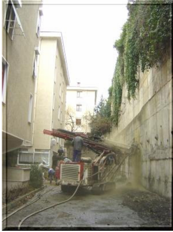
Şekil 3.4 Ankraj Uygulaması
