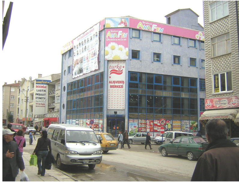
Şekil 6.72 Turca Center görünüş
